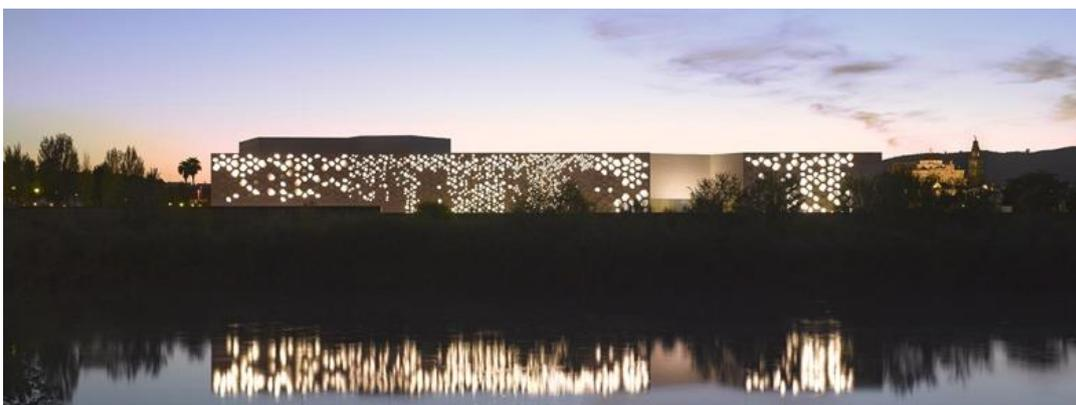
Además, esta fachada tiene una doble función, más allá de la proyección. Sus perforaciones, durante el día, filtran la luz natural, arrojando una iluminación tamizada a la calle interior cubierta.
