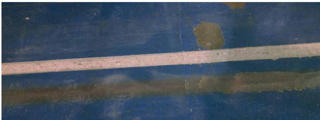
Imagen 37. Fresado realizado en la parte en que irá colocada la cinta
