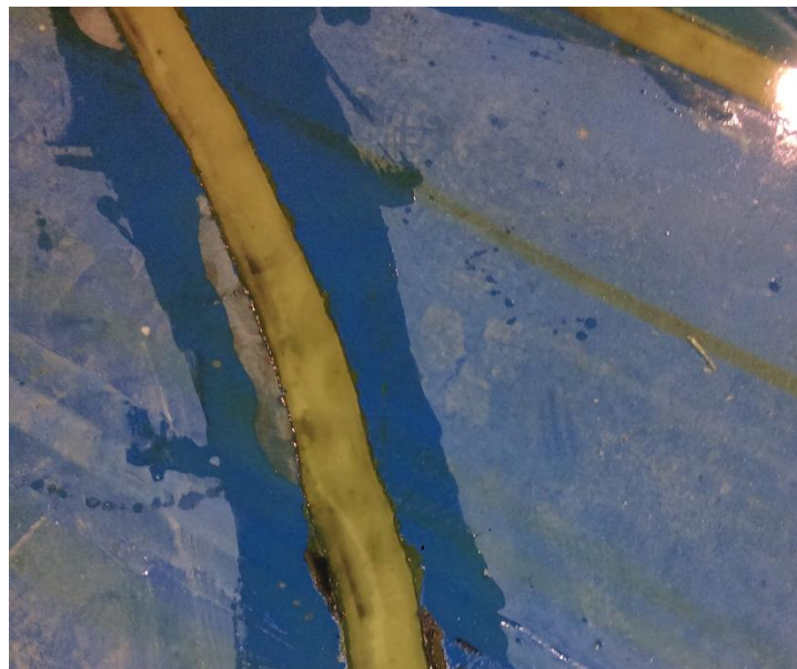
Imagen 39. Resinado de la parte fresada anteriormente
