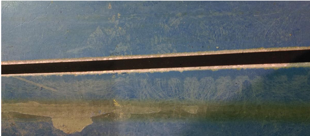
Imagen 38. Colocación de la cinta magnética
