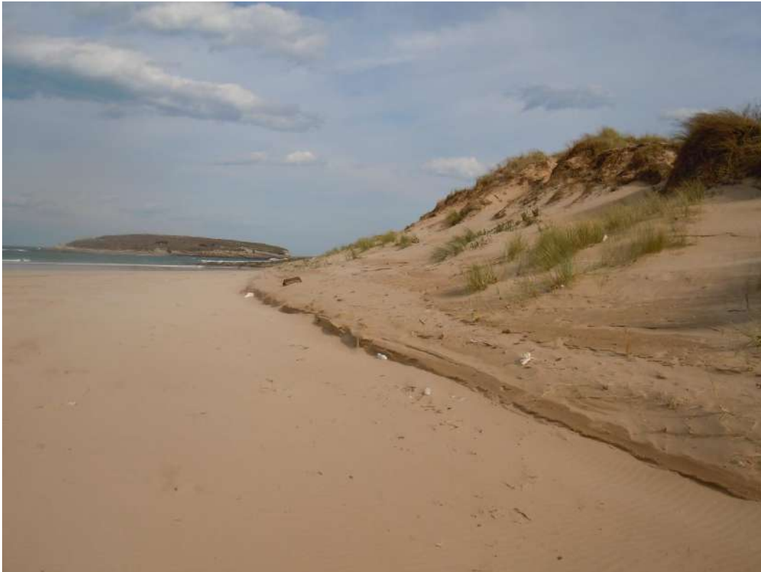
Figura 16: Estado de la zona de actuación 2 (Plano 6).
