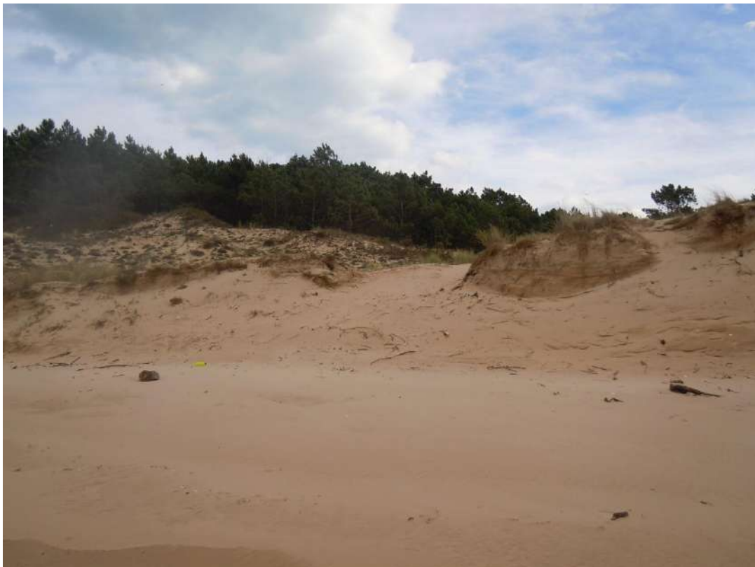
Figura 17: Vista del cordón dunar erosionado en la zona de actuación 2 (Plano 6).
