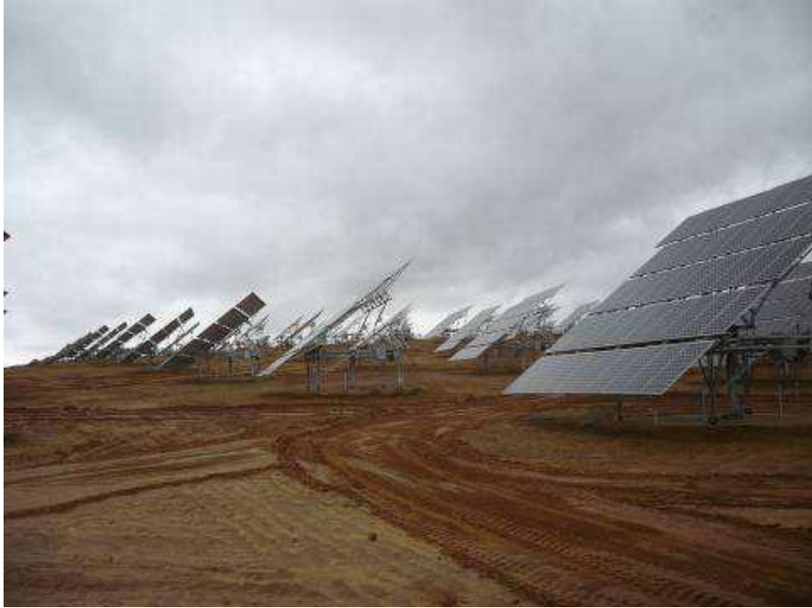
Imagen 1 Seguidores solares “Pevafersa”. (Fuente: Propia)
