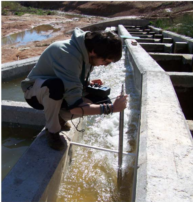
Figura 23.- Control hidráulico. Medición de velocidades.
