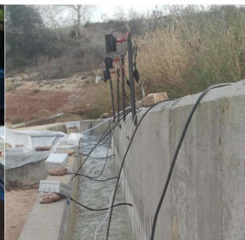
Figura 27.- Instalación del sistema de CCTV en el canal de nado Vadocondes.
