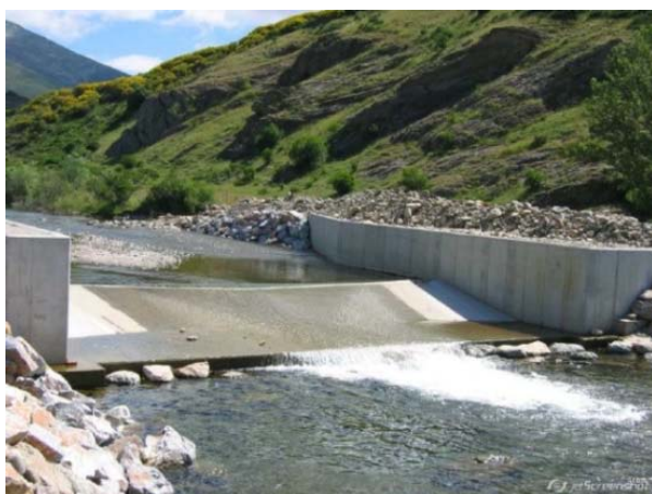
Figura 3.- Barrera artificial física. Estación V-flat.
