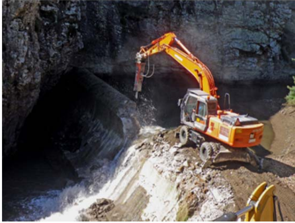
Figura 5.- Demolición azud. ©CHD.
