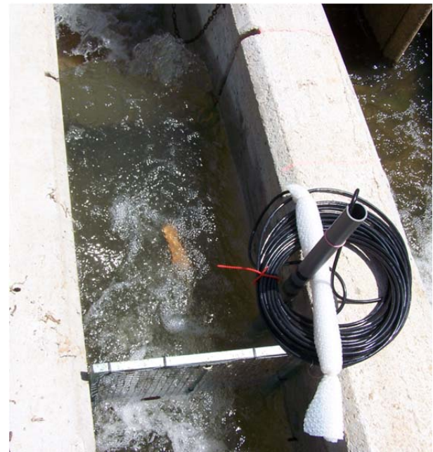
Figura 24.- Control hidráulico. Medición de profundidades.
