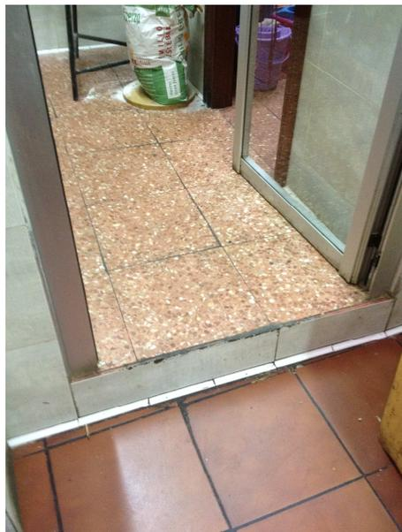
Destacar también que en la zona de barra se ha detectado una incidencia formada por en el punto de intersección de dos módulo de la barra que se encuentran a distinto nivel y pueden suponer un riesgo por golpe.
