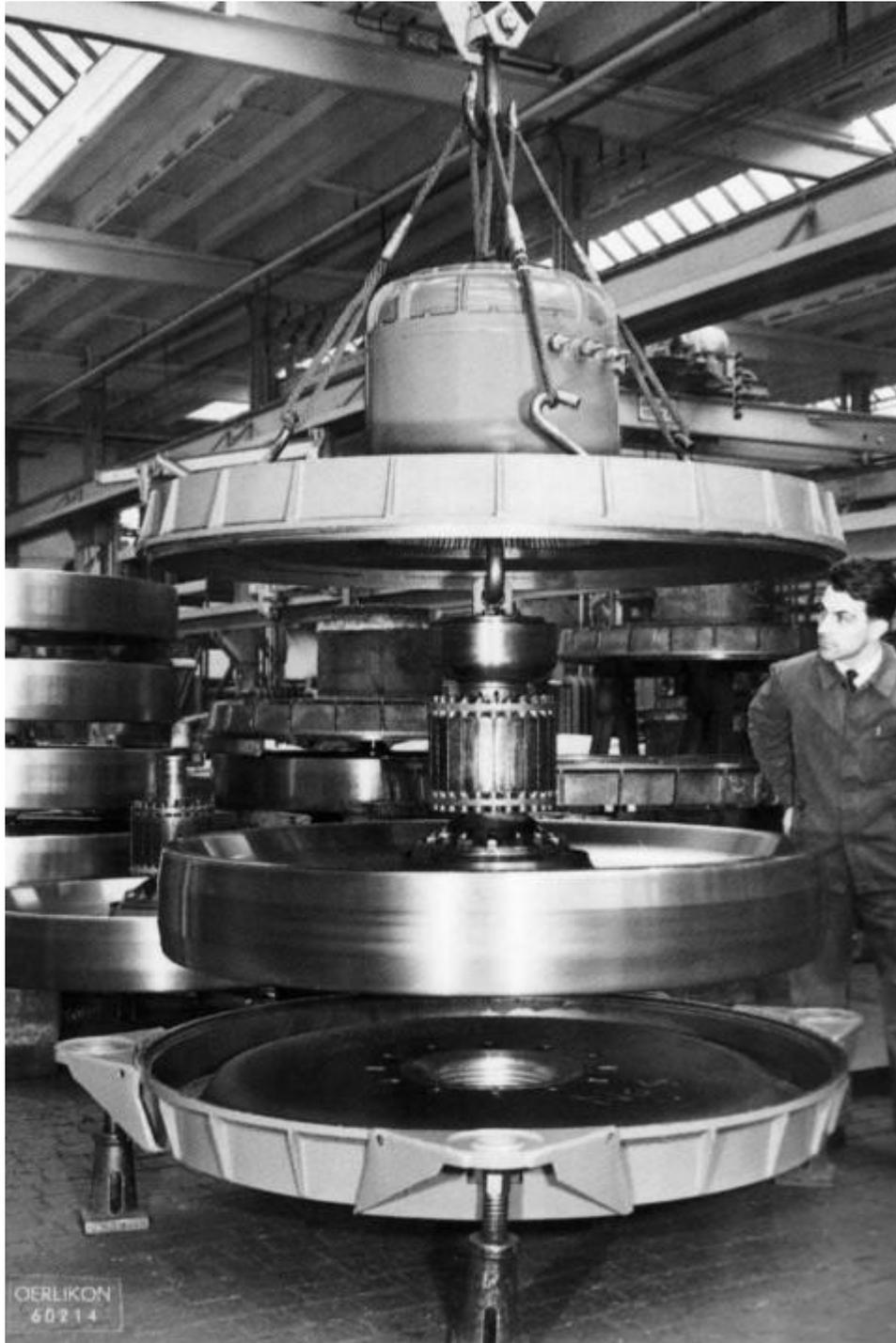
Figura 8. Despiece de un volante de inercia masivo [Kamm, 2008]
