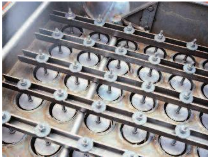
Figura 2.4: Limpieza automática del intercambiador [27]
