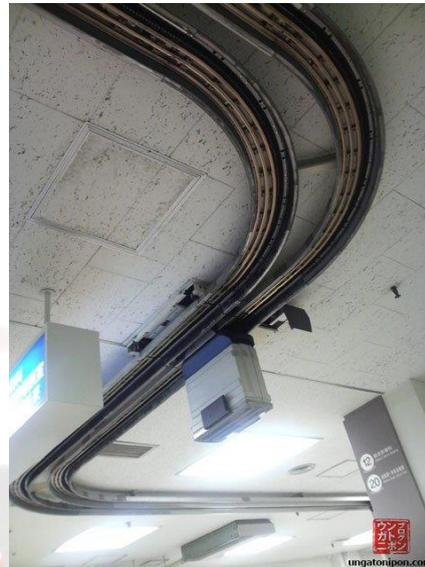
En mi opinión sería hacer algo lógico como no usar papel para ver el historial médico de un paciente, sería tenerlo digitalizado con pantallas táctiles en cada sala, pero se desmarcan con este impresionante sistema de transporte, que, por cierto, fue instalado y fabricado por Siemens.
