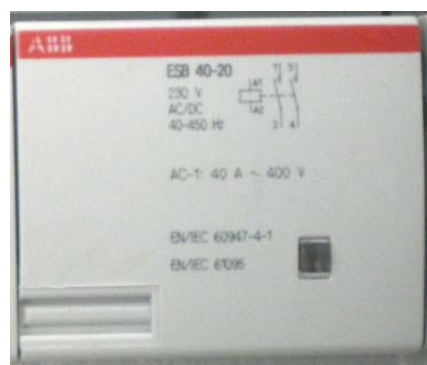
Figura 22. Contactor.
