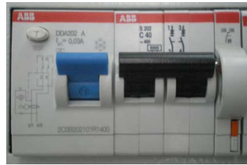
Figura 20. Interruptor diferencial.
