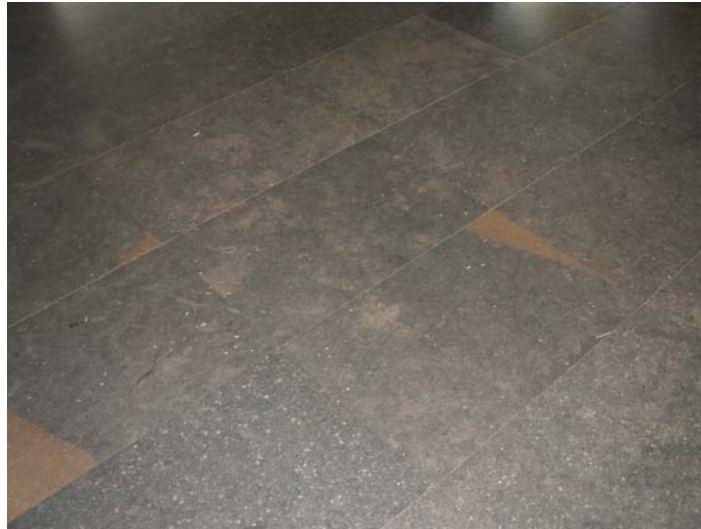
Figura 50. Pavimento antideslizante en interior estación de tren de Valladolid.
