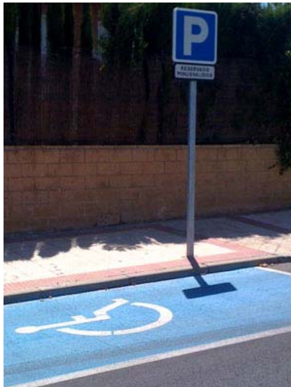
Figura 47. Aparcamiento. Señalización horizontal y vertical aparcamiento discapacitados.
