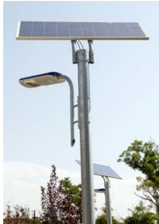
Figura 19. Farola con energía solar. Fuente: www.adif.es
