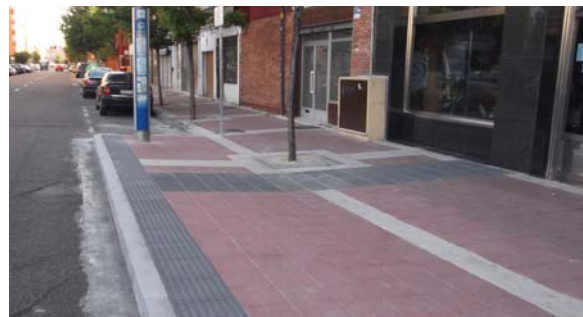
Figuras 45 y 46. Franja de pavimento tacto visual de 1,20 m de ancho, perpendicular al sentido de la marcha desde bordillo hasta fachada. Paradas de autobús 844 (nueva) y 1322 (reformada)
