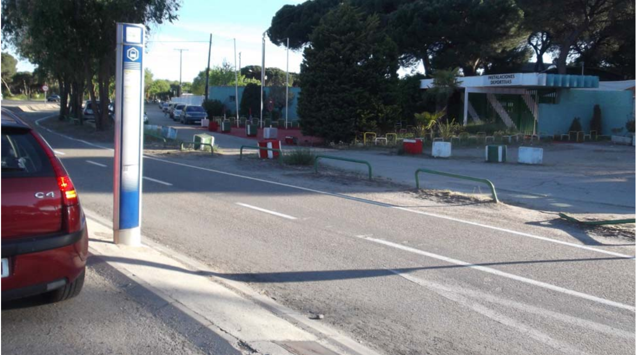
Figura 112. Pendiente de acera no adecuada en parada de autobús 863.
