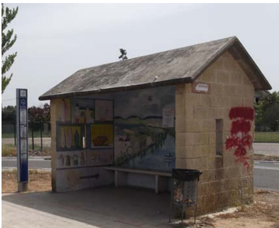
Figuras 134 y 135. Inexistencia de apoyo isquiático en paradas de autobús 911 y 784.
