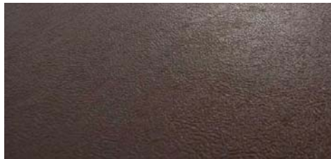
Figura 69. Pavimento antideslizante en aseos.
