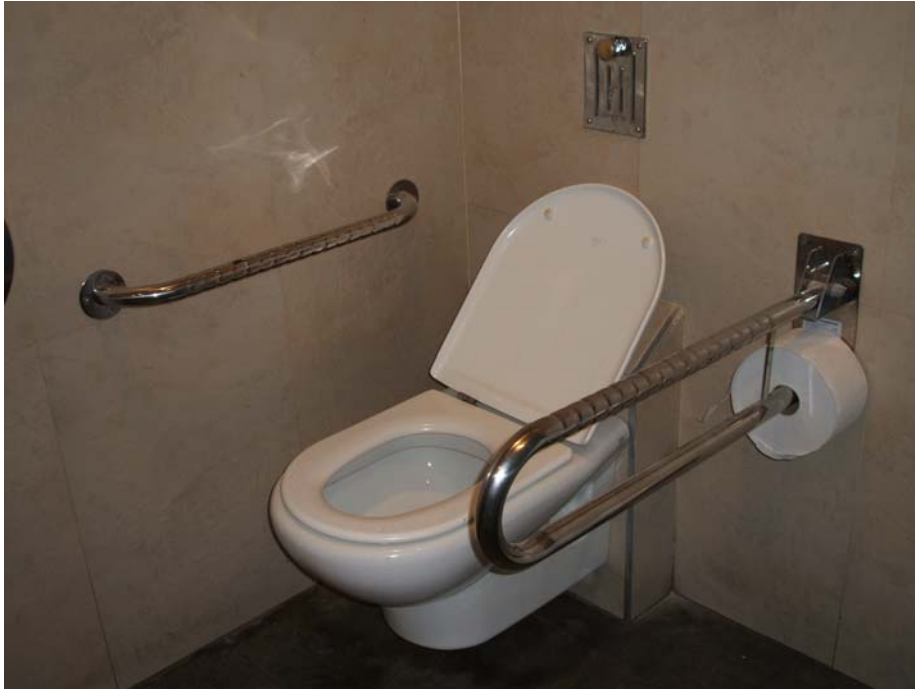
Figura 71. Barras de apoyo aseos en estación de tren de Valladolid.
