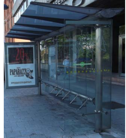
Figuras 132 y 133. Inadecuada señalización de cerramiento transparente o traslúcido en paradas de autobús 832 y 1127.
