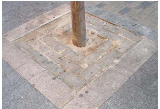
Figuras 43 y 44. Alcorques cubiertos o enrasados con el pavimento en parada de autobús 583 y parada de taxis junto Colegio de Abogados
