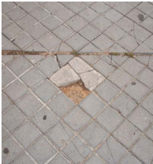
Figuras 166 y 167. Pavimentos con piezas o elementos sueltos y material no compacto, parada de taxis de Hernando de Acuña y Camino del Obregón.
