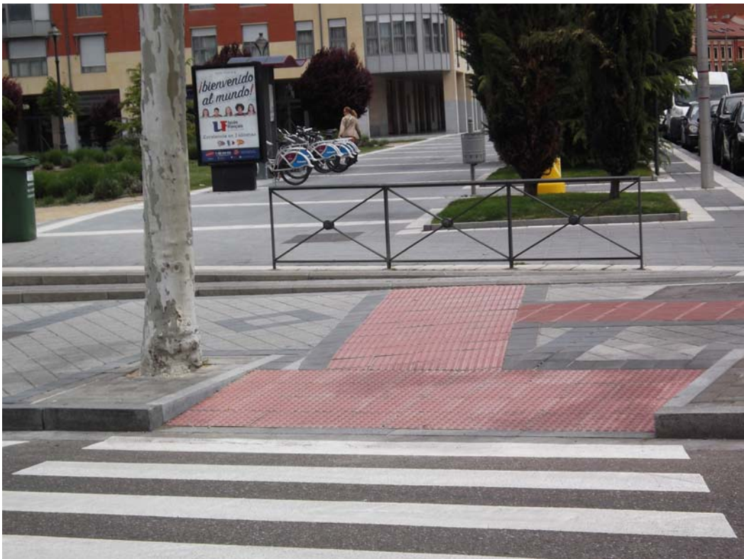
Figura 39. Vado de acceso a parada de autobús 1163 y junto estación de tren
