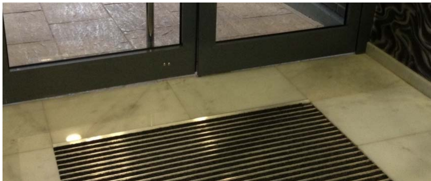
Figura 63. Felpudo enrasado con el pavimento.
