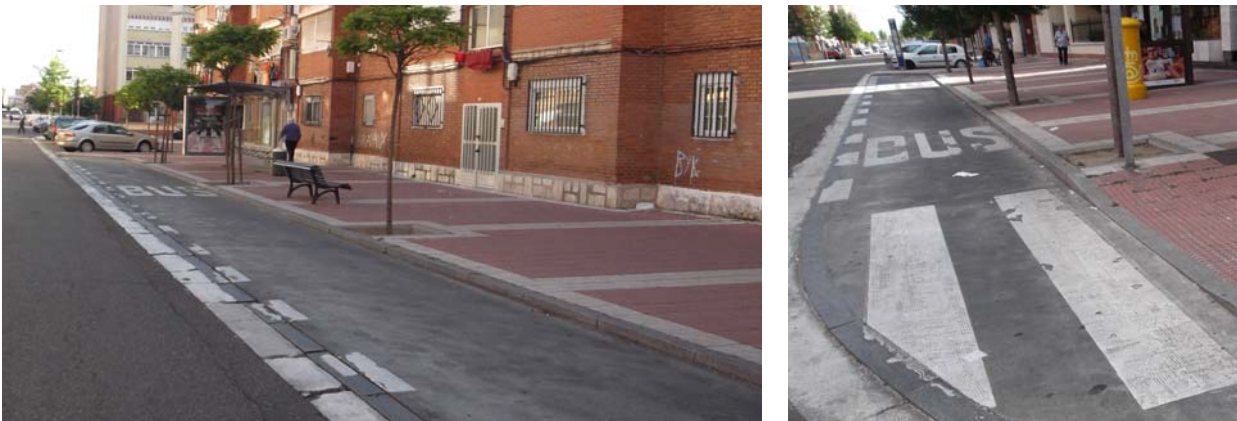
Figuras 87 y 88. Elementos rígidos; SI, con carril habilitado. Paradas de autobús 674 y 672.
