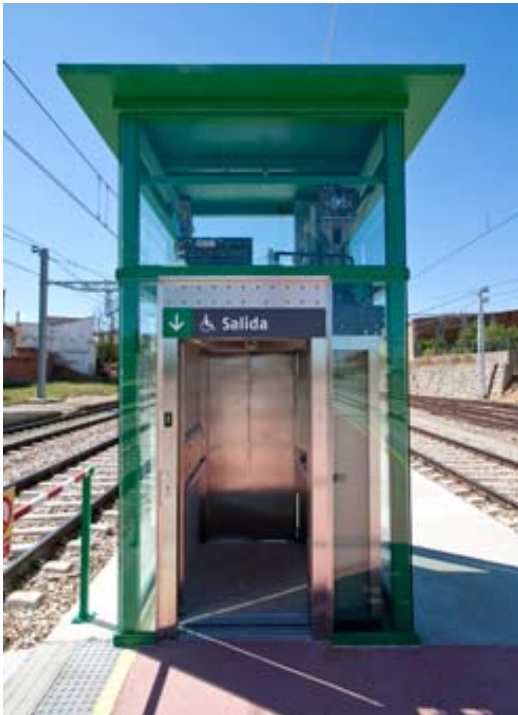
Figura 18. Ascensor. Fuente: www.adif.es
