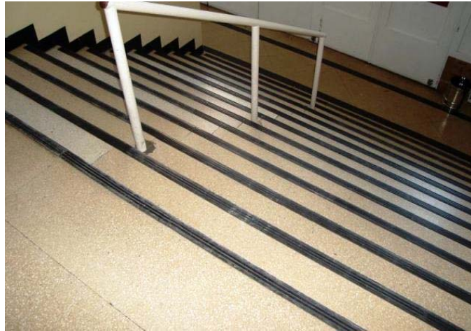
Figura 56. Bandas antideslizantes en peldaños.
