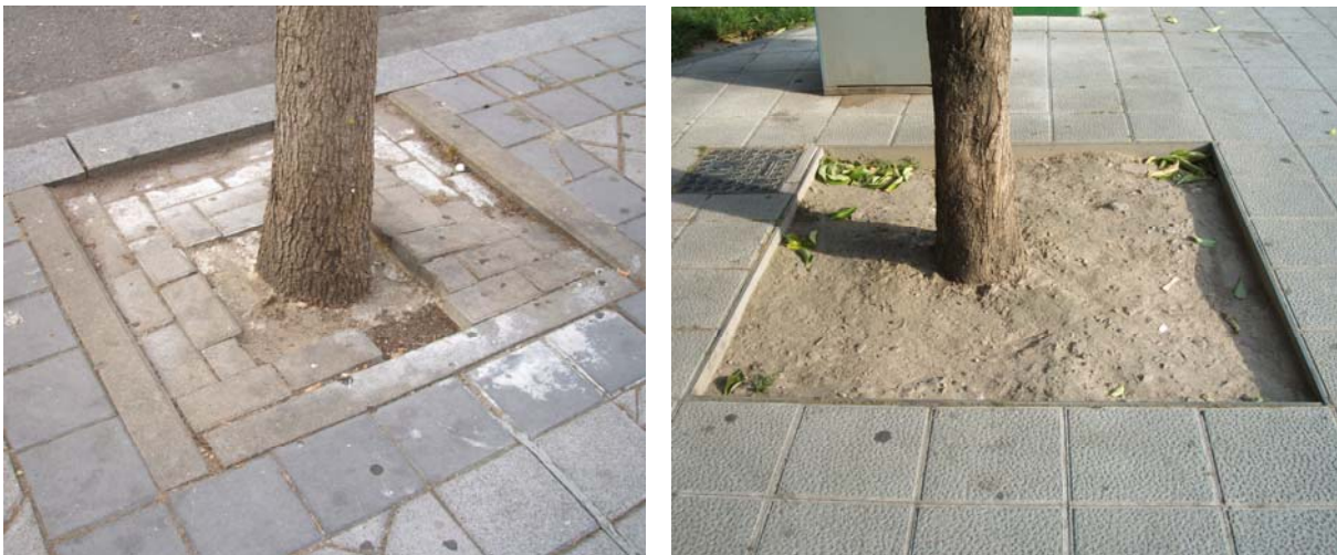
Figuras 183 y 184. Alcorque en paradas de taxis en Puente Colgante (cubierto pero no enrasado) y Plaza Zorrilla (sin cubrir).
