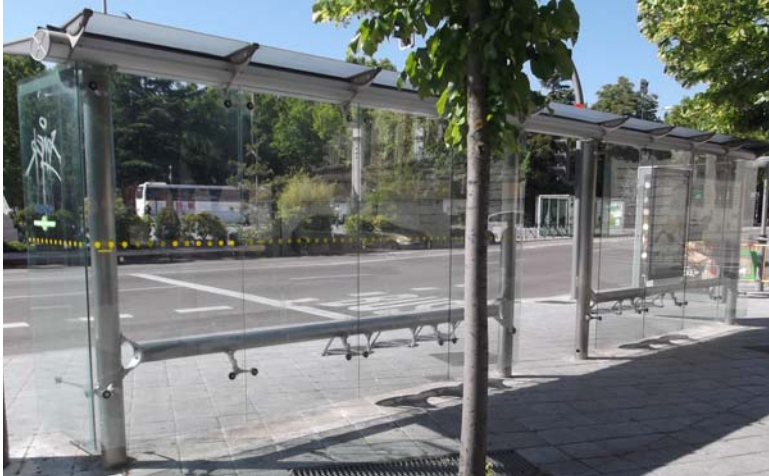
Figuras 132 y 133. Inadecuada señalización de cerramiento transparente o traslúcido en paradas de autobús 832 y 1127.
