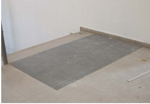
Figura 57. Pavimento en arranque de escalera.
