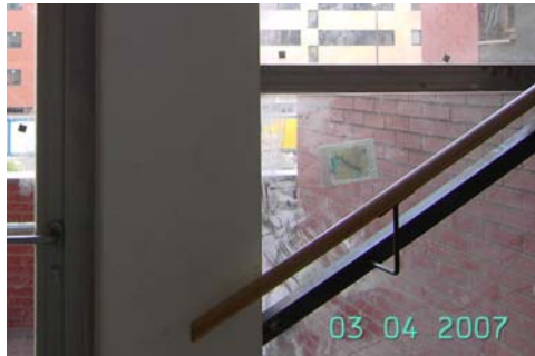
Figura 59. Prolongación de pasamanos en escalera.
