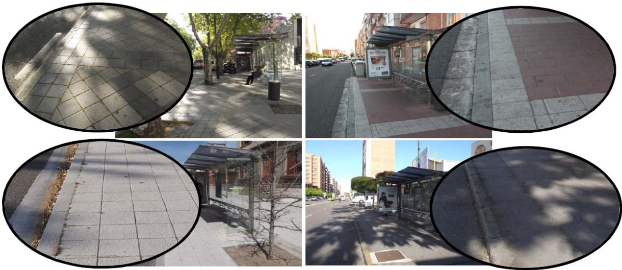
Figura 40. Pavimentos sin piezas o elementos sueltos; tipos de pavimento. De izquierda a derecha y comenzando por arriba; paradas de autobús 1185, 673, 1289, 651
