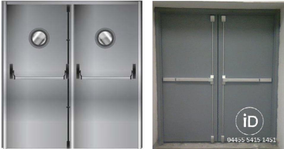
Figuras 52 y 53. Salidas de emergencia. Mecanismo apertura puerta emergencia.
