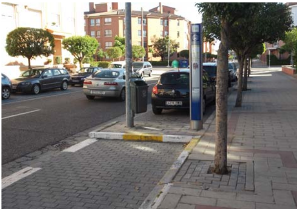
Figuras 43 y 44. Alcorques cubiertos o enrasados con el pavimento en parada de autobús 583 y parada de taxis junto Colegio de Abogados
