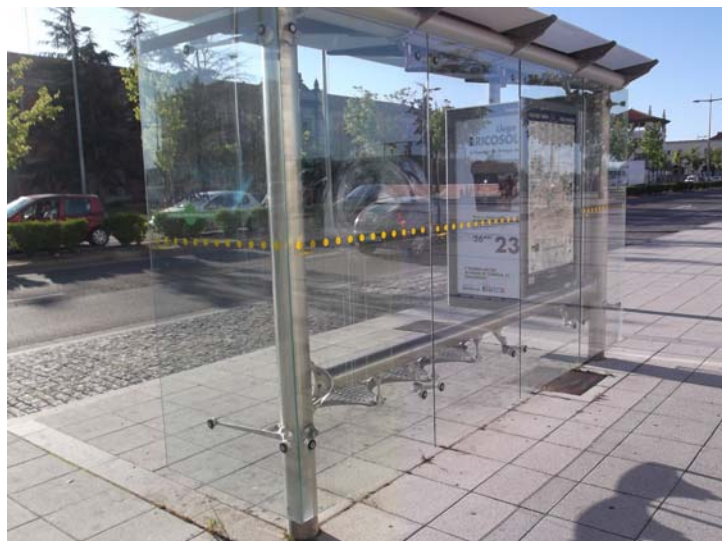
Figura 91. Cerramiento de vidrio de marquesina. Parada de autobús 1281.
