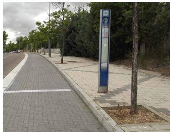
Figura 137. Porcentajes alcorques cubiertos o enrasados con pavimento en paradas de autobús y la parada 1268 que incumple el requisito. Fuente: Elaboración propia
