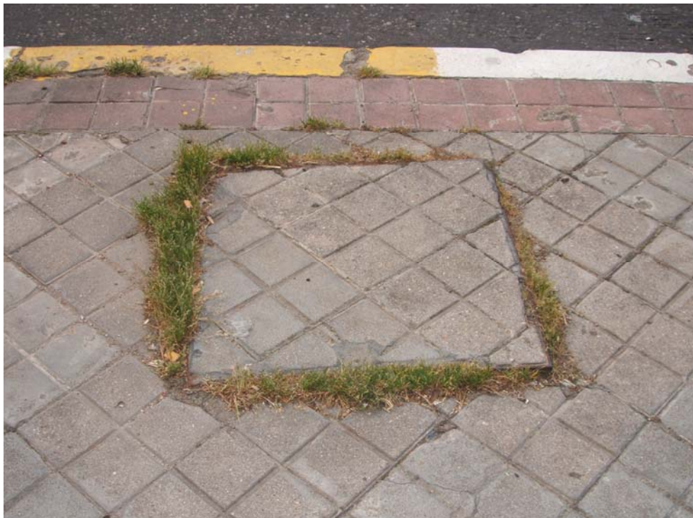
Figura 181. Tapa de arqueta no enrasada en parada de taxis de Calle Hernando de Acuña.
