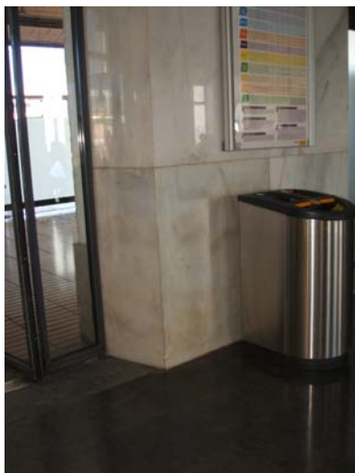
Figura 54. Contraste de color entre suelo y pared en estación de tren de Valladolid.
