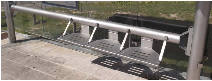
Figura 143. No existencia de reposabrazos en asientos extremos en parada de autobús 1358. Fuente: Elaboración propia.
