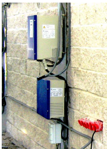
Fig. 6.7: Inversor utilizado en la instalación MODEN.
