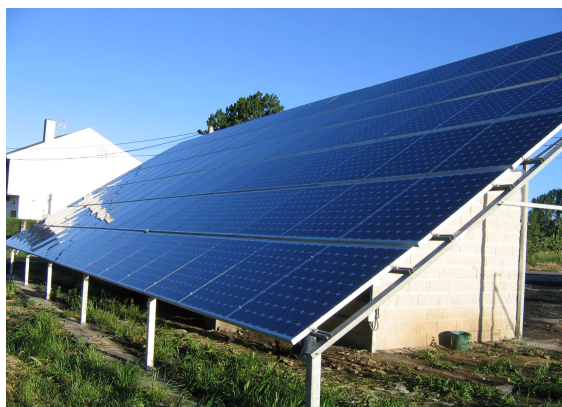
Fig: 6.5: Generadores fotovoltaicos utilizados con el sistema MODEN V.
