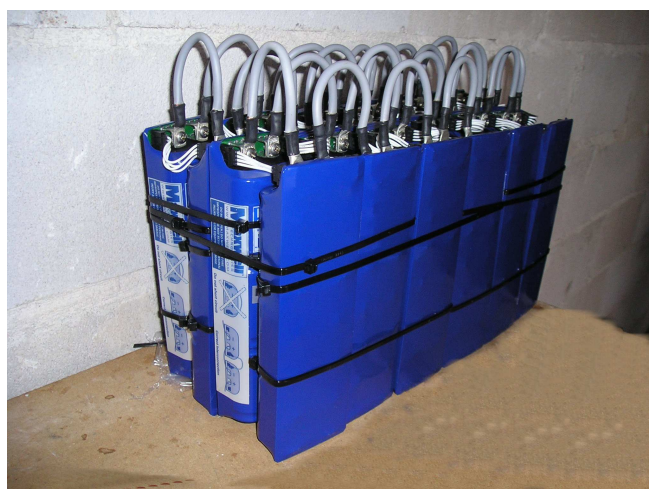
Fig: 6.8: Batería de ultracondensadores del prototipo MODEN.
