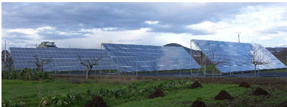
Fig: 6.3: Generadores fotovoltaicos de la planta “Ponferrada I”.
