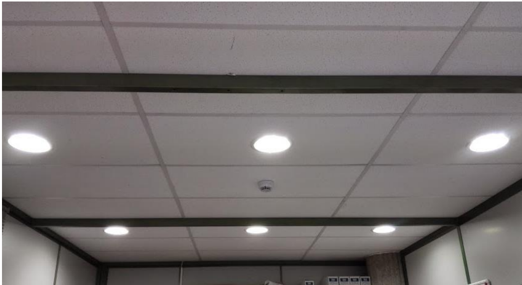
Figura 4.20: Vista de las luminarias empotradas en el techo del despacho de los responsables
