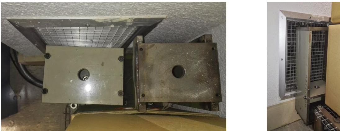
Figura 4.22: Elementos obstaculizando extracción de aire en sala Mecánica-Fuerza y Par
