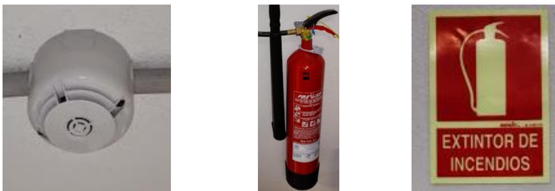
Figura 4.23: Elementos de protección contra incendios en el LCD
