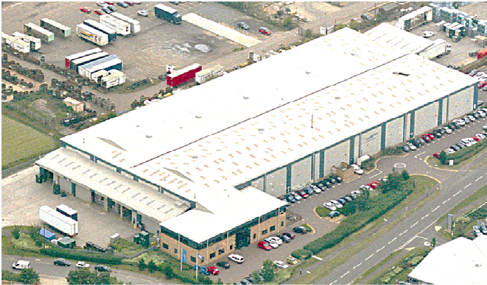
Figura 21. Planta de Grupo Antolín en Royal Leamington Spa, donde se fabrican techos interiores y DVD para la mayor parte de las marcas de Reino Unido.
