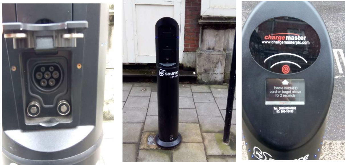
Figura 38. Poste de recarga de vehículo eléctrico, de la compañía Source London. En la foto de la izquierda, la conexión del cable. En la foto de la derecha, el sistema detector de tarjeta magnética para su uso.
