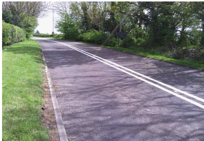
Figura 42. Tramo de carretera secundaria en Royal Leamington Spa, sin arcén y con escalón en el lateral
