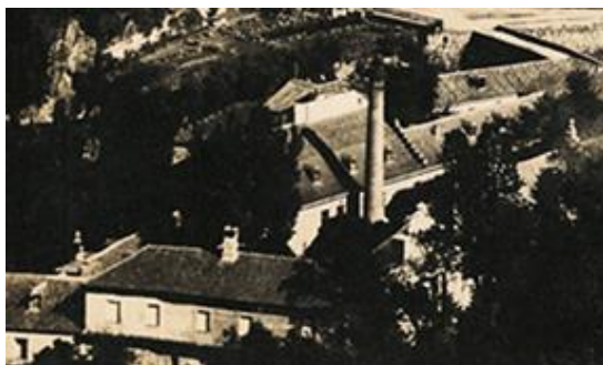
Vista de la fábrica de harinas "La Moneda", dónde se aprecia su chimenea. Fot. Col. Doblón
