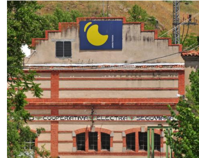
Antiguo edificio de la Cooperativa Electra Segoviana, actualmente pertenece a la empresa Unión Fenosa. Camino de la presa, Barrio de San Lorenzo (Segovia) Arch. www.unaventanadesdemadrid.com
