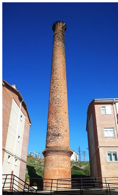
Chimenea de la antigua fábrica La Innovadora. Año 2015. Fot. Col. Raúl Estaire
