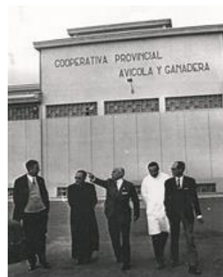
Inauguración de las nuevas instalaciones de Coop. Agrícola Provincial Avícola y Ganadera en La Lastrilla. Fuente: Arch. AVIGASE
