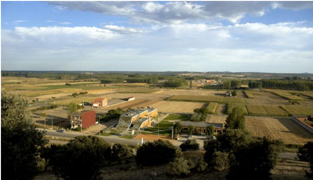
Figura 22: Vista general del edificio y su entorno. Fuente: CSO arquitectura.
