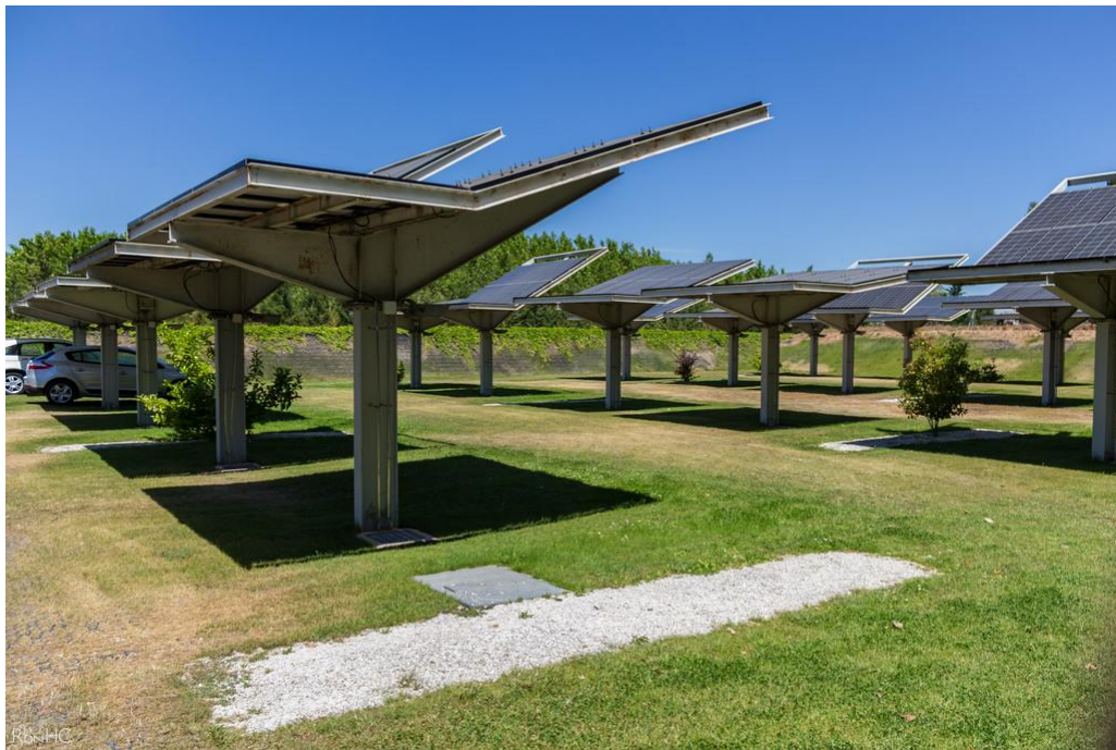
Figura 51: Imagen de la zona de parking, “artesa” con los paneles fotovoltaicos. Fuente: Yucatan Pictures
