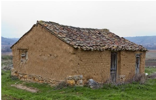
Figura 4: Imagen de una construcción popular de adobe en Castilla y León. Fuente: [ siempredepasso.es [Internet]
