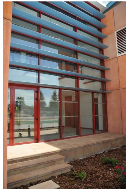
Figura 38: Vista exterior de la zona acristalada. Fuente: Alia Arquitectos
