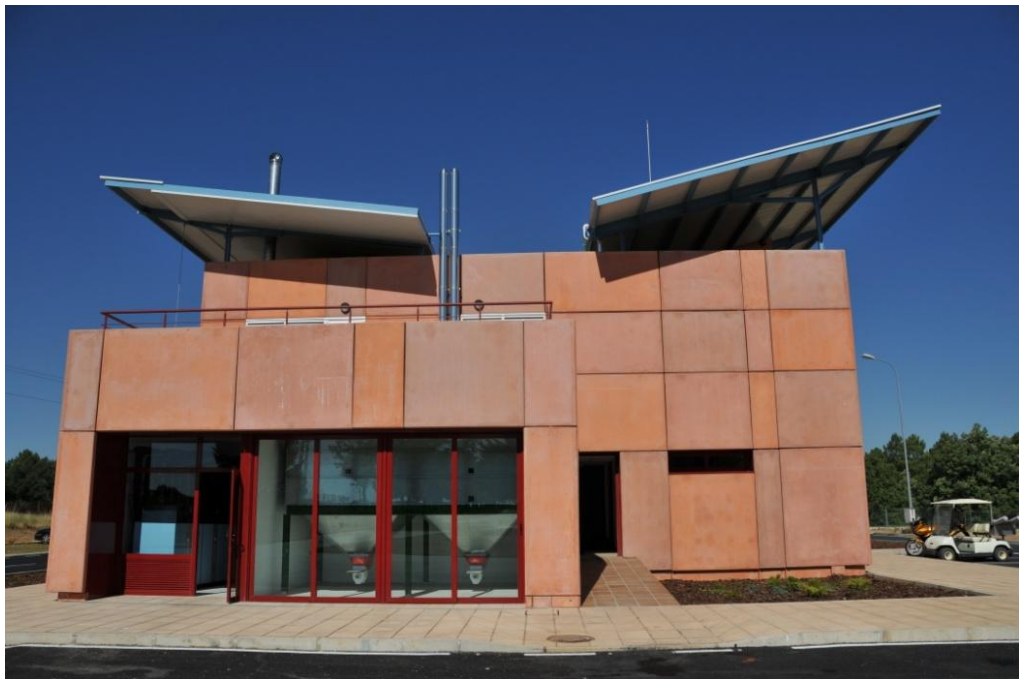
Figura 32: Vista exterior del nuevo edificio. Fuente: Alia Arquitectos
