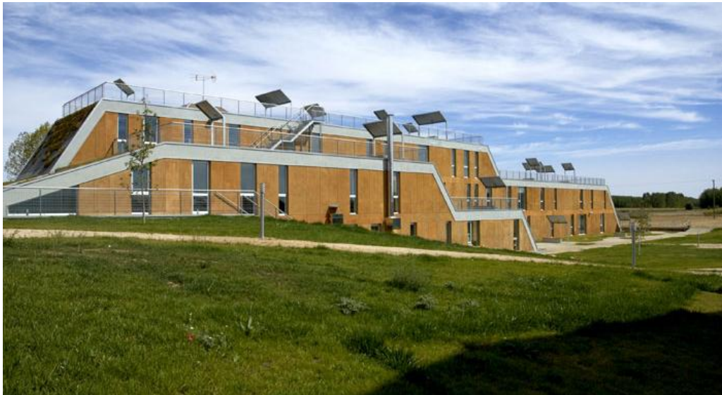
Figura 23: Vista exterior del conjunto. Fuente: CSO arquitectura
