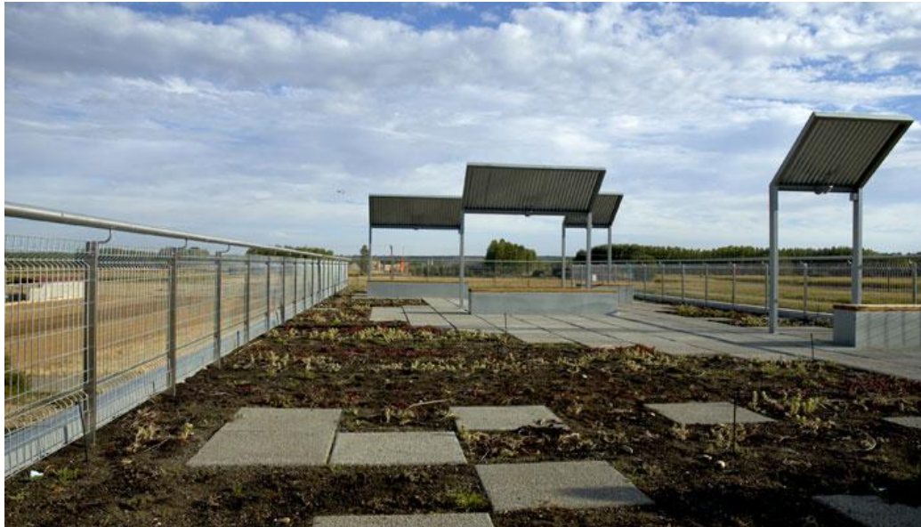
Figura 26: Vista de la cubierta. Fuente: CSO arquitectura
