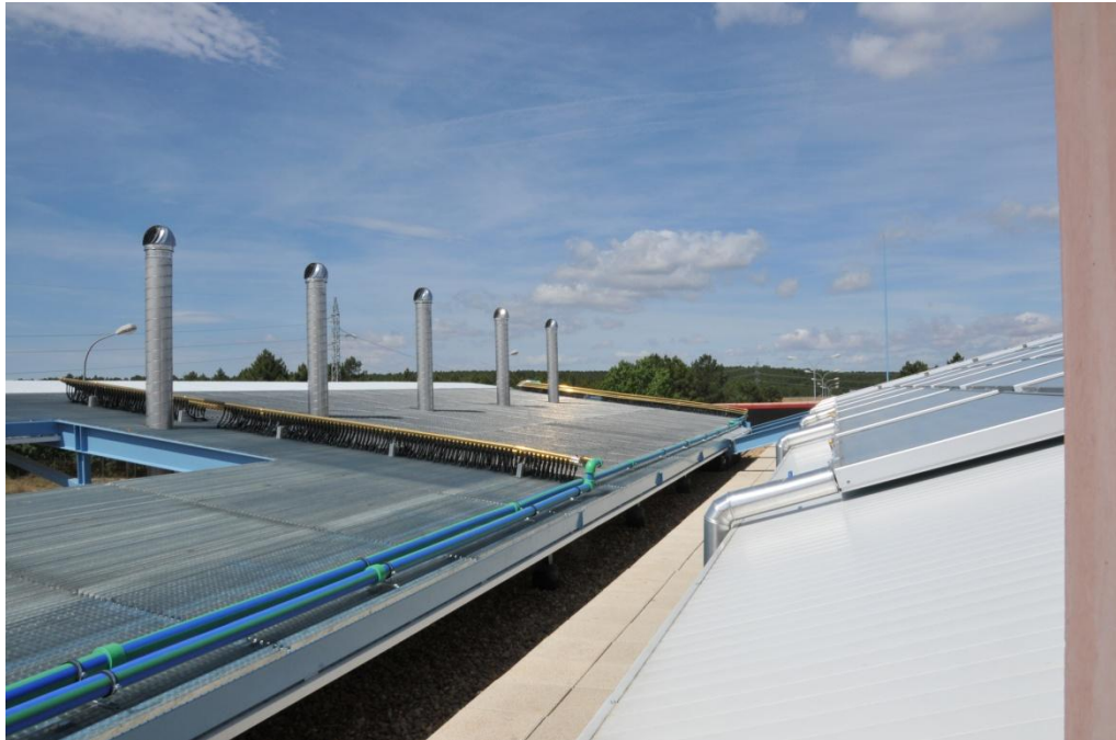
Figura 464: Vista de la cubierta en construcción. Fuente: Alia Arquitectos
