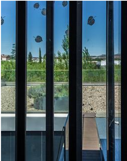
Figura 58: Vista de la idea de "fachada multicapa". Fuente: Yucatan Pictures
