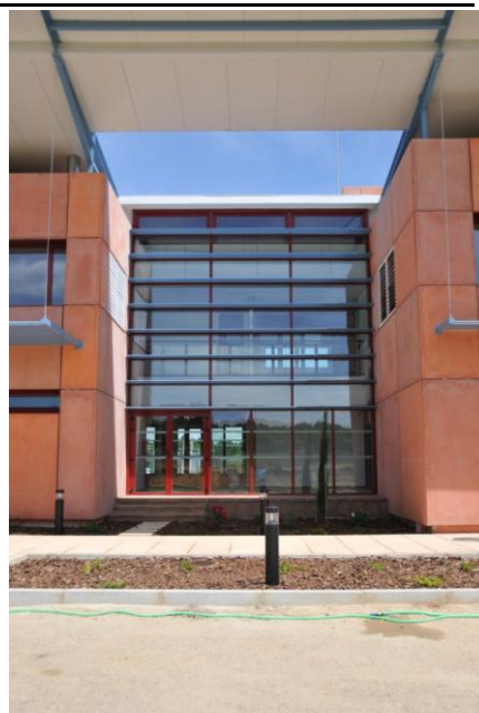
Figura 37: Vista exterior de la fachada. Fuente: Alia arquitectos.
