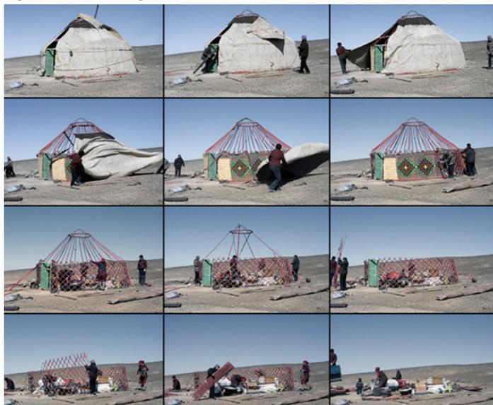
Figura 6 | Proceso de desmontaje
