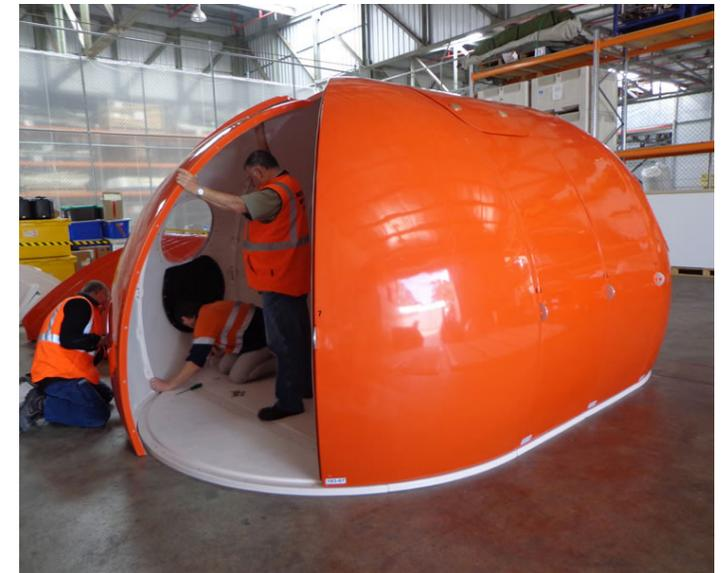
Figura 74 | Montaje del módulo extensible
