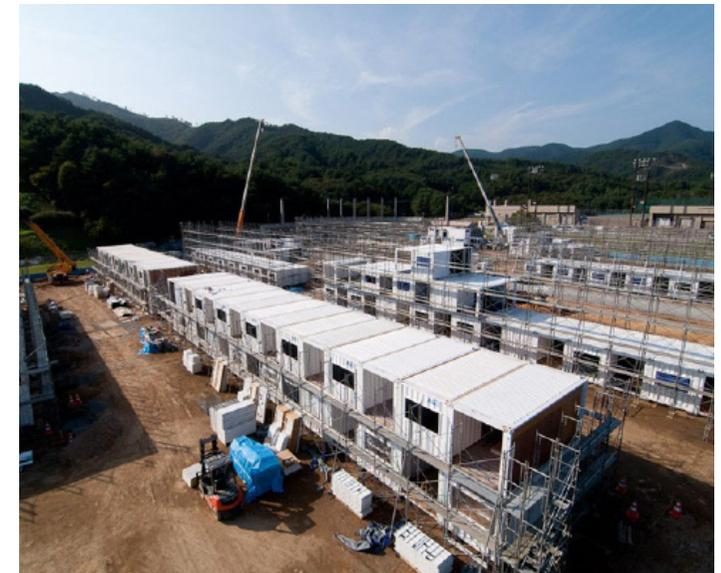
Figura 38 | Construcción con contenedores alternados.
