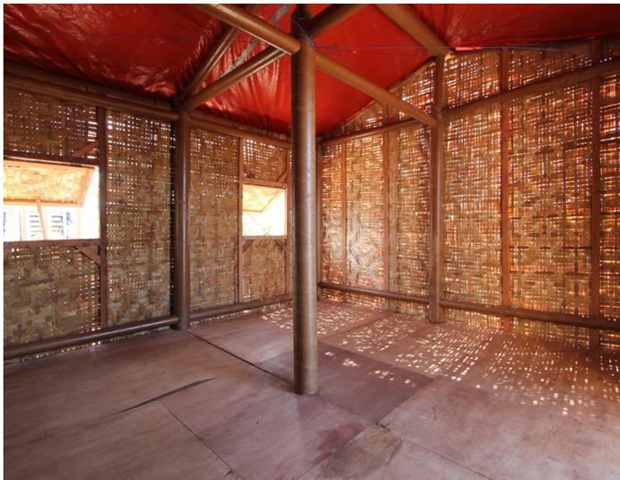
Figura 30 | Paper Log House en Filipinas, con estructura de tubos de cartón y cerramiento de bambú
