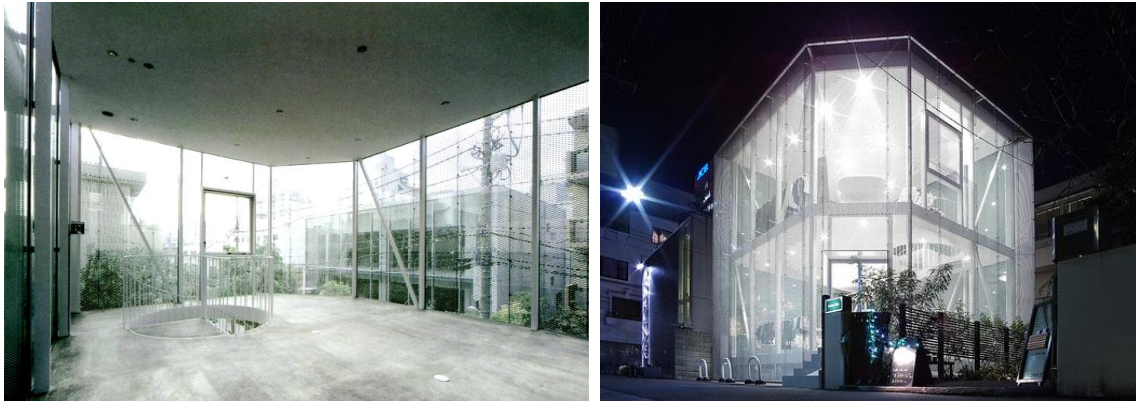
Imágenes 17 y 18. Interior (izqda.) y exterior (dcha.) del edificio para la tienda Carina en Aoyama.
