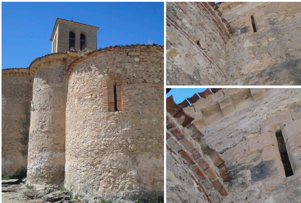
Ilustración 8. Comparativa del método de construcción, cornisa y formación de huecos entre la construcción original, con piedra labrada, izquierda; y la sacristía, de construcción posterior, con ladrillo de arcilla, derecha.
