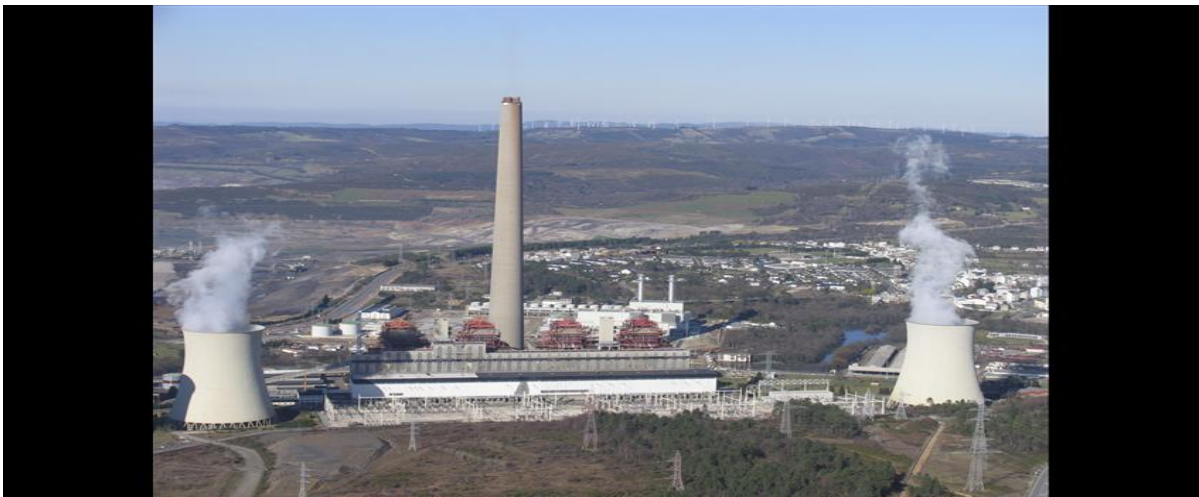
CENTRAL TÉRMICA DE AS PONTES (PONTEVEDRA). FOTO: ENDESA.COM
