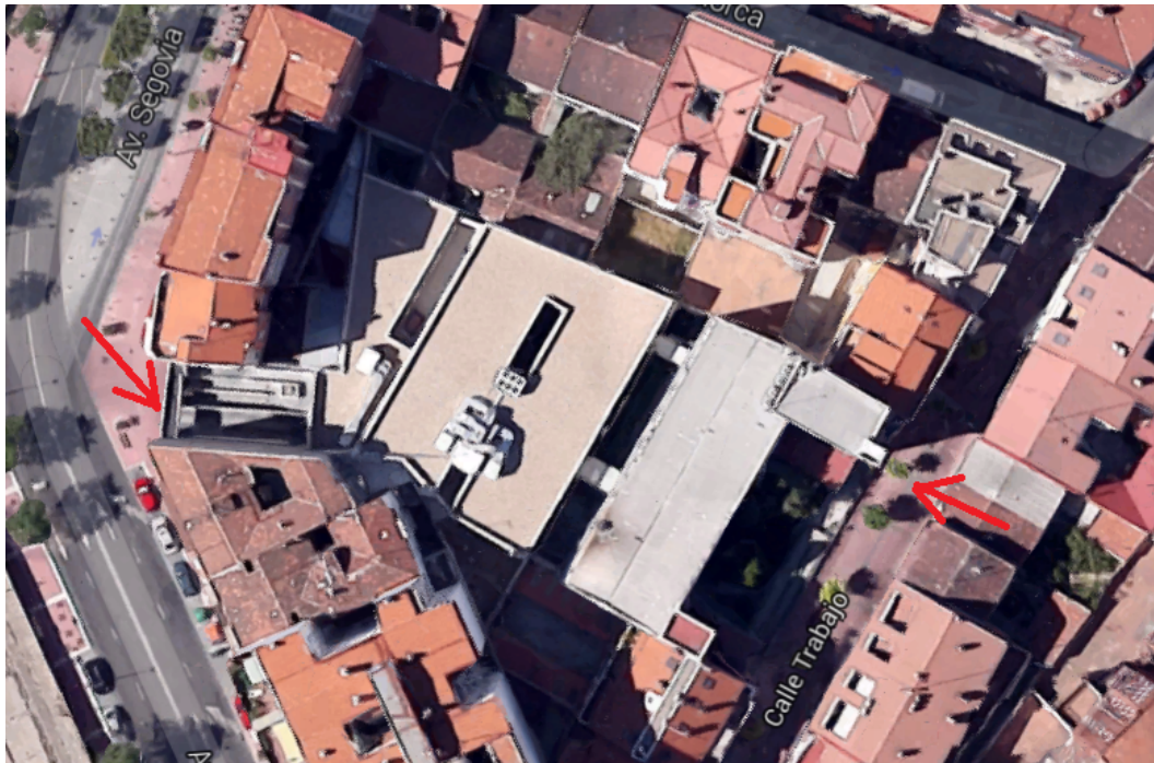
Figura 8.2: Vista de los accesos al Centro de Salud y de Especialidades
