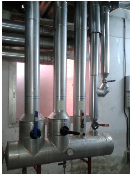
Figura 7.19: Colector nuevo adicional de retorno de frío
