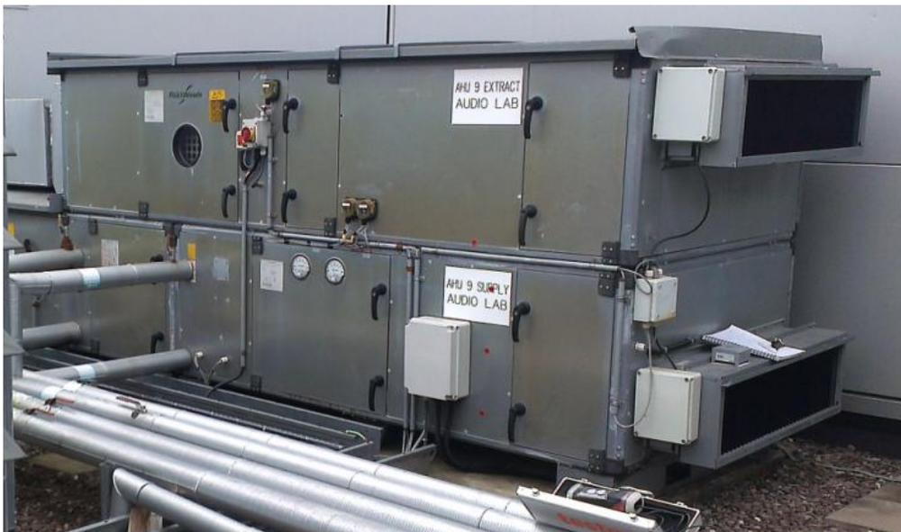
Figura 2: El sistema AHU09 real sobre el tejado de la escuela de música en Cork, Irlanda.
