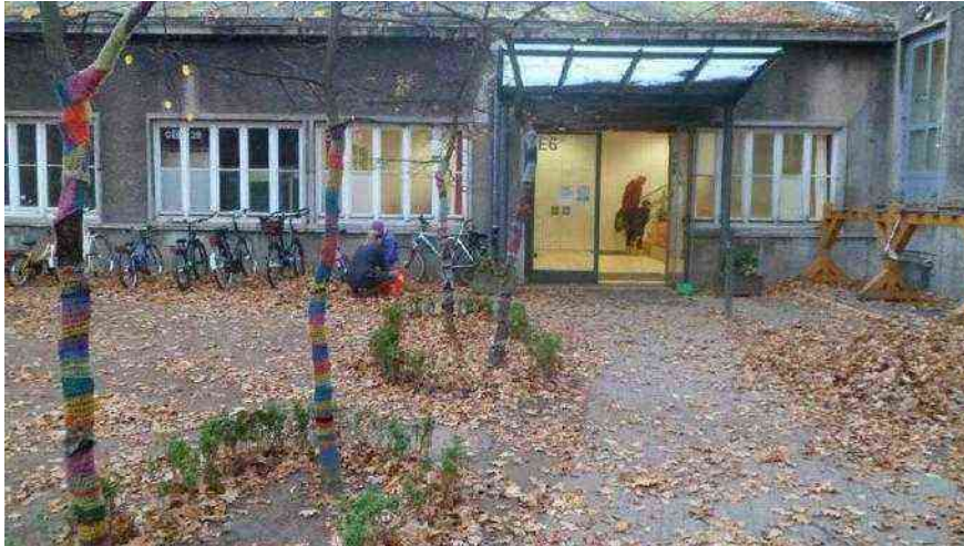
Foto 2: Entrada al edificio
