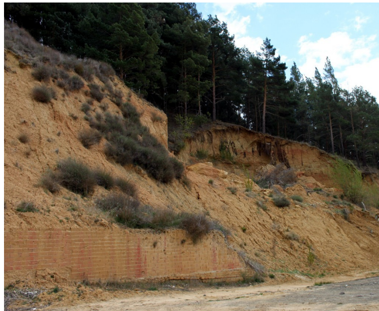
Foto 8. Deslizamientos en el pie de las laderas, a escasos metros de una vivienda unifamiliar (IOM, abril 2012)
