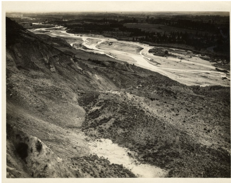
Foto 6. Vista del río Carrión a su paso por Valcabadillo en 1930. Nótese la alta carga sólida del cauce como se deriva del carácter fuertemente trenzado (foto tomada en Valcabadillo, Confederación Hidrográfica del Duero, 1930)
