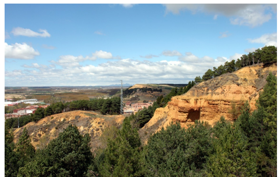
Foto 3. Estado actual de las laderas (JMB, abril 2012)
