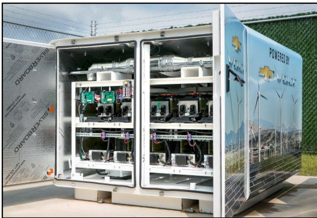
Ilustración 101: Baterías del Chevrolet Volt, para el uso en central eólica. Fuente: GM
