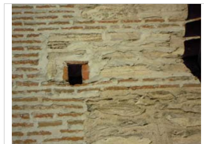
Torre. Mechinal realizado en ladrillo perteneciente al andamiaje.
