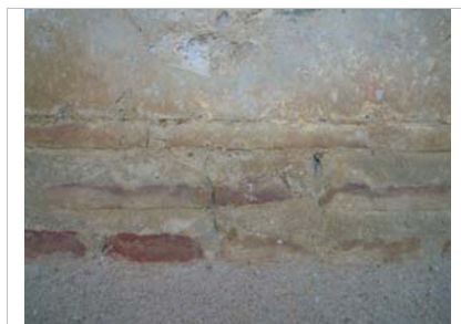
Verdugada de tres hiladas con mechinal oculto por un ladrillo.
