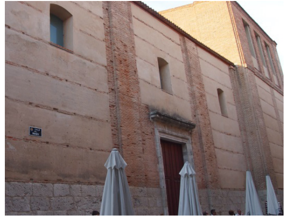
Figura 5.150. Lateral de la iglesia de San Martín. Valladolid.
