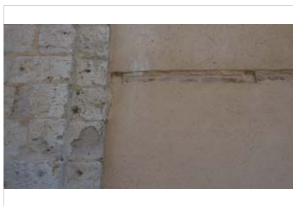
Detalle de los mechinales en la hilada
