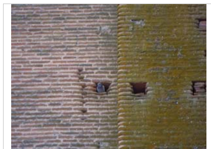
Detalle del muro norte. Mechinales de los andamios donde se albergan las palomas
