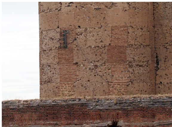
Figura 5.115. Imagen de la tapia mixta de uno de los cubos de la muralla exterior del castillo de Rivilla de Barajas. AV
