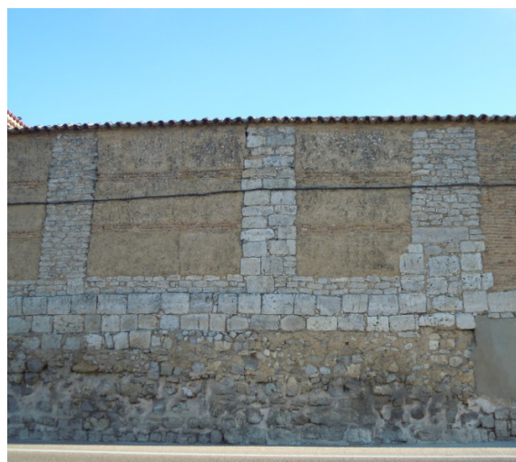
Figura 5.235. Detalle de la cerca del convento de la Concepción, Santa Clara. Medina de Rioseco (VA)
