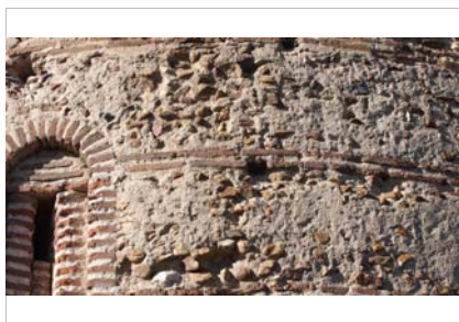
Detalle del hueco de ventana recercado con ladrillo y la verdugada
