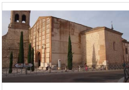
Fachada lateral con verdugadas de ladrillo
