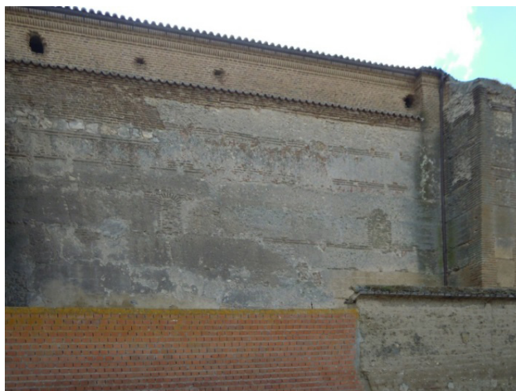
Figura 5.96. Muro norte de la iglesia de San Pelayo en Sinlabajos (AV), conserva las trazas y la construcción del muro mudéjar.
