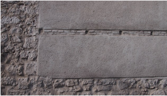
Figura 5.166. Detalle de los mechinales del muro de la nave de San Agustín
