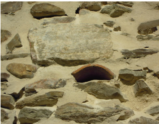
Figura 5.11. Detalle de mechina en la Muralla de Coca (SG).
