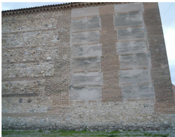
Figura 5.178. Detalle de la reconstrucción del muro de la iglesia de Nuestra Señora de la Asunción en Muriel de Zapardiel. VA.
