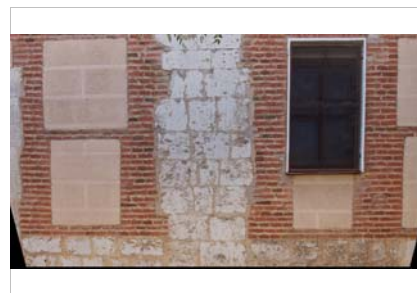
Fachada singular de la iglesia con machón de sillar y ladrillo
