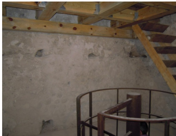
Figura 5.31. Detalle del muro hacia el interior de la torre de la Iglesia de San Esteban. Cuéllar. SG
