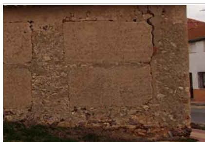
Muro mixto de tapia reforzado con mampostería
