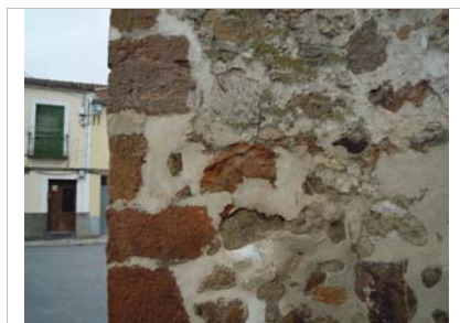
Recercado de esquinas en sillares
