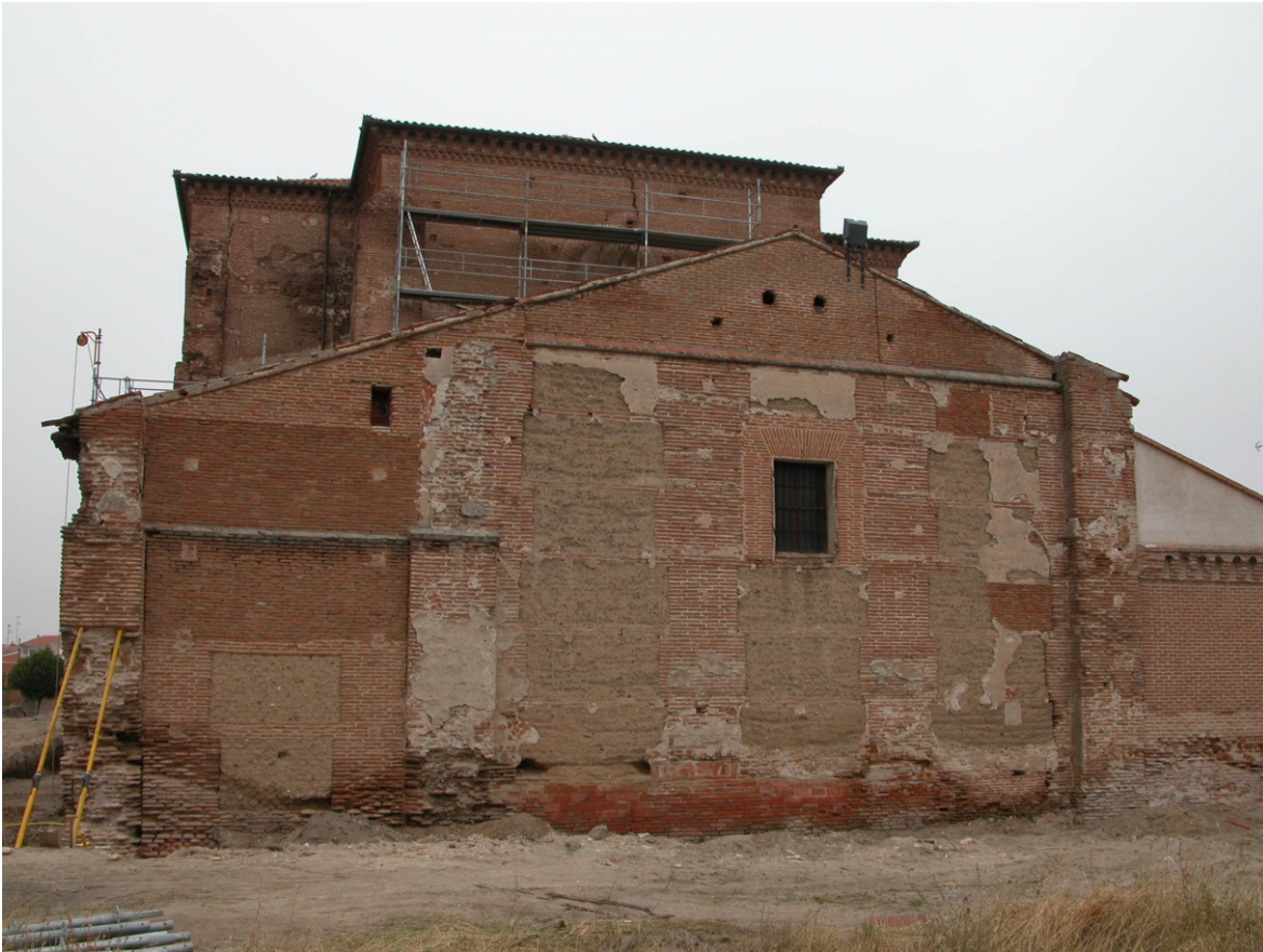
Figura 5.188. Imagen durante las obras de rehabilitación cedida por el Dr. Arquitecto Antonio Paniaga, autor de la rehabilitación.
