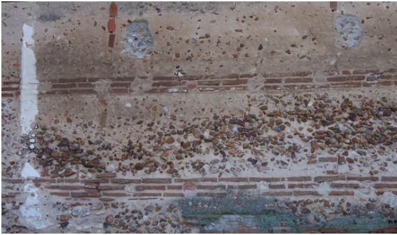
Figura 5.1. Muro verdugado. Iglesia de Blasconuño de Matababras (AV).
