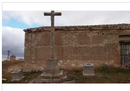
Muro mixto con enfoscado
