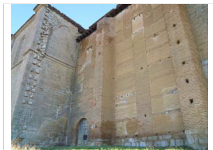
Muro mixto con machones rectos y cajones de tapia de tierra
