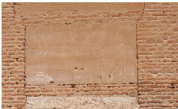
Figura 6.5. Cajón de tapia de tierra de la iglesia de Santa Catalina. Toro. ZA.
