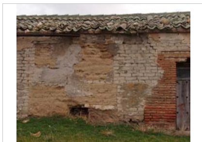
Muro mixto de tapia reforzada con adobe.
