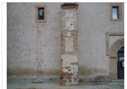
Contrafuerte y muro oeste. Técnica mixta de ladrillo y tapia
