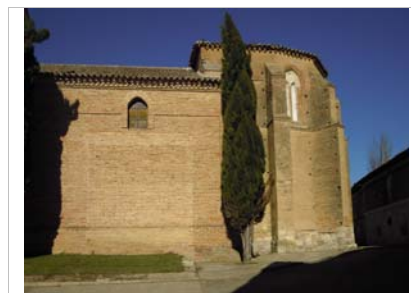
Ábside con huecos de los mechinales en los muros y contrafuertes
