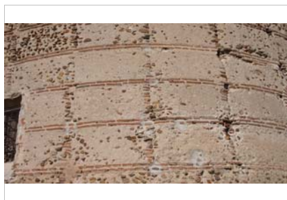
Muro curvo de tapia fajeado con ladrillo, se aprecian los cajones
