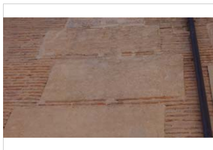
Detalle de la ocultación de los mechinales de las verdugadas.
