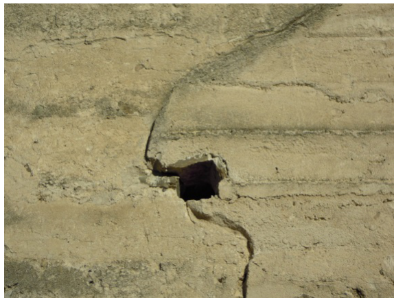
Figura 5.12. Detalle de mechina en la torre de San Nicolás, Coca (SG).
