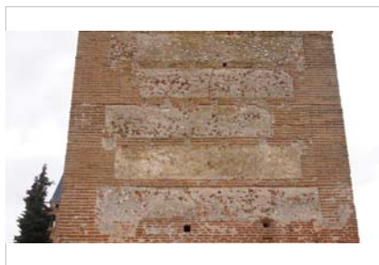
Torre construída con machones en las esquinas y verdugadas de ladrillo
