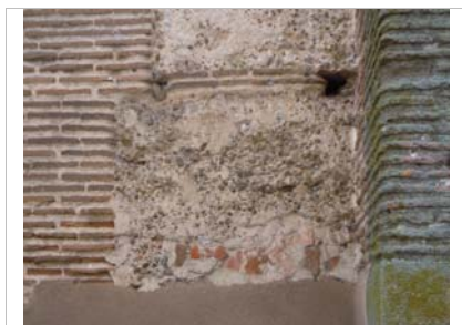
Detalle del muro norte. Mechinales de gran tamaño
