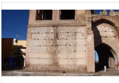
Fachada de la puerta verdugada y encadenada en esquinas
