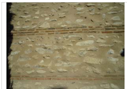
Detalle de las fajas de la nave
