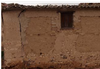
Muro mixto de tapia reforzado con adobe
