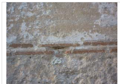
Mechinal oculto en verdugada con 2 hilada como elemento de remate
