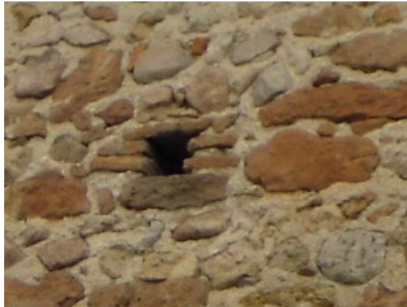
Figura 5.10. Detalle de mechina en la iglesia de El Salvador, Fuentepelayo (SG).
