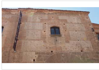
Alzado, vista de la ventana con sus recercados. Vista de mechinales.
