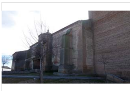
La nave posee contrafuertes construídos con posterioridad
