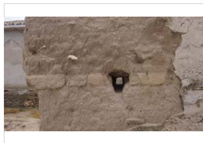
Hilada de adobe con mechinal interior
