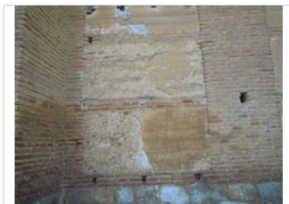
Detalle del cajón de tapia de tierra
