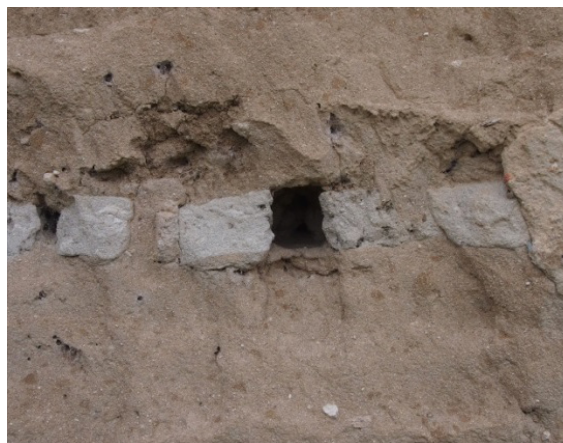
Figura 5.135. Detalle de mechinal del almacén agrícola en Rapariegos. SG.
