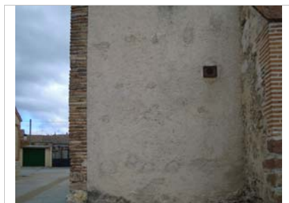
Detalle muro norte, se adivinan las trazas de los mechinales bajo el mortero
