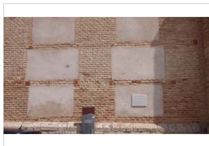
Fachada principal del templo con el muro mixto
