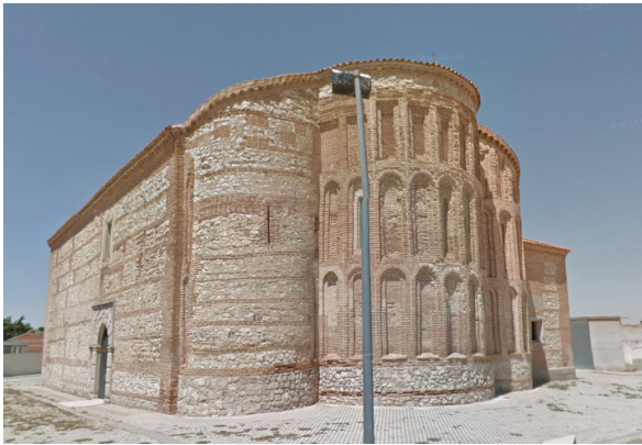
Figura 5.55. Cabecera de la iglesia de Muriel de Zapardiel (VA). Ábside de la epístola reconstruido con tapia encintada.
