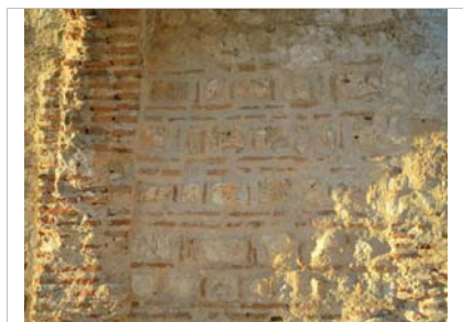
Combinación de ladrillo y cal y canto en puerta de entrada de San Martín
