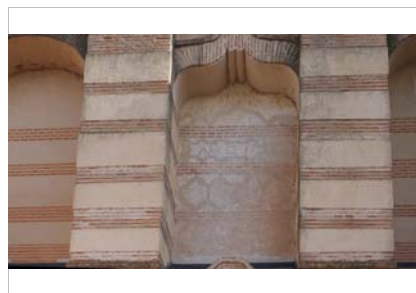
Fajeado con hiladas de ladrillo
