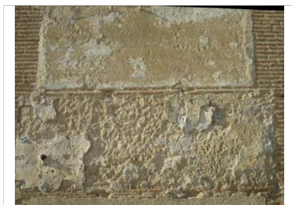
Detalle de cajones con mortero de cal
