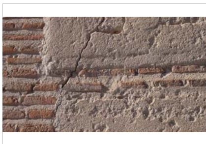
Detalle del muro Oste de la torre
