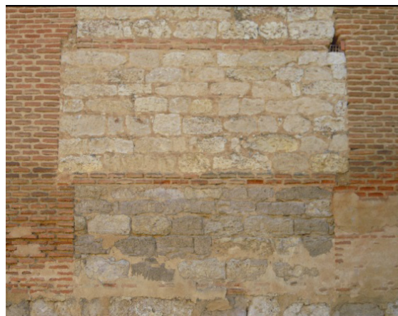
Figura 5.205. Detalle del muro del alzado lateral de la Iglesia convento de San José. Medina de Rioseco. VA.
