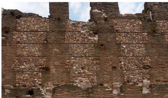
Figura 5.130. Detalle del muro exterior hacia el suroeste del convento de San Agustín Extramuros en Madrigal de las Altas Torres. AV.
