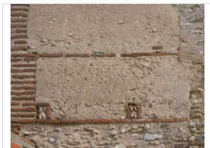
Contrafuerte con una hilada de ladrillo
