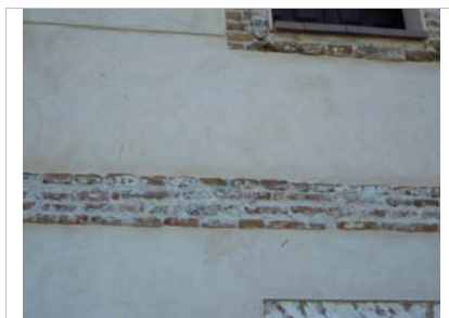
Verdugado cuádruple de la edificación adosada a la iglesia
