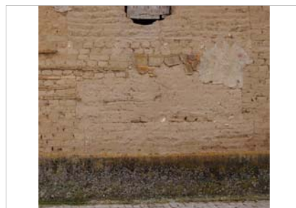
Zócalo enfoscado de cemento y parte de muro de tapia.
