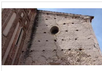
Muro este de la nave
