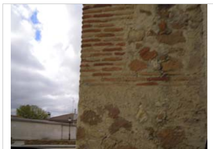
Detalle del contrafuerte del muro oeste.
