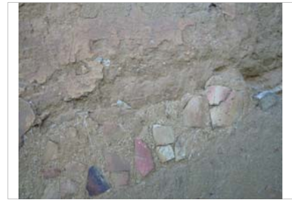
Revestimiento que incorpora trozos de teja
