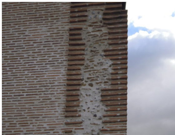
Figura 5.190. Detalle de la fachada donde se aprecia el muro compuesto por dos hojas de ladrillo y relleno de tapia.
