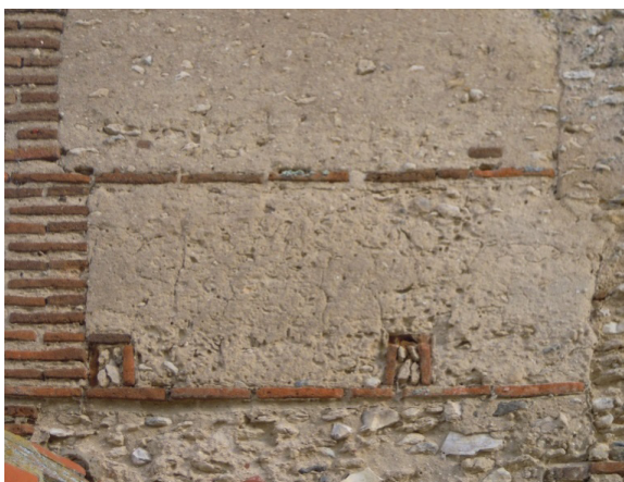
Figura 5.21. Imagen del contrafuerte de la iglesia de San Pelayo. Sinlabajos. AV.
