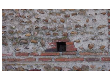
Mechinal sobre la verdugada con recercado de ladrillo
