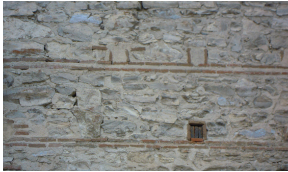
Figura 6.7. Cajones de piedra rajuela de la iglesia de San Miguel. Arévalo. AV.
