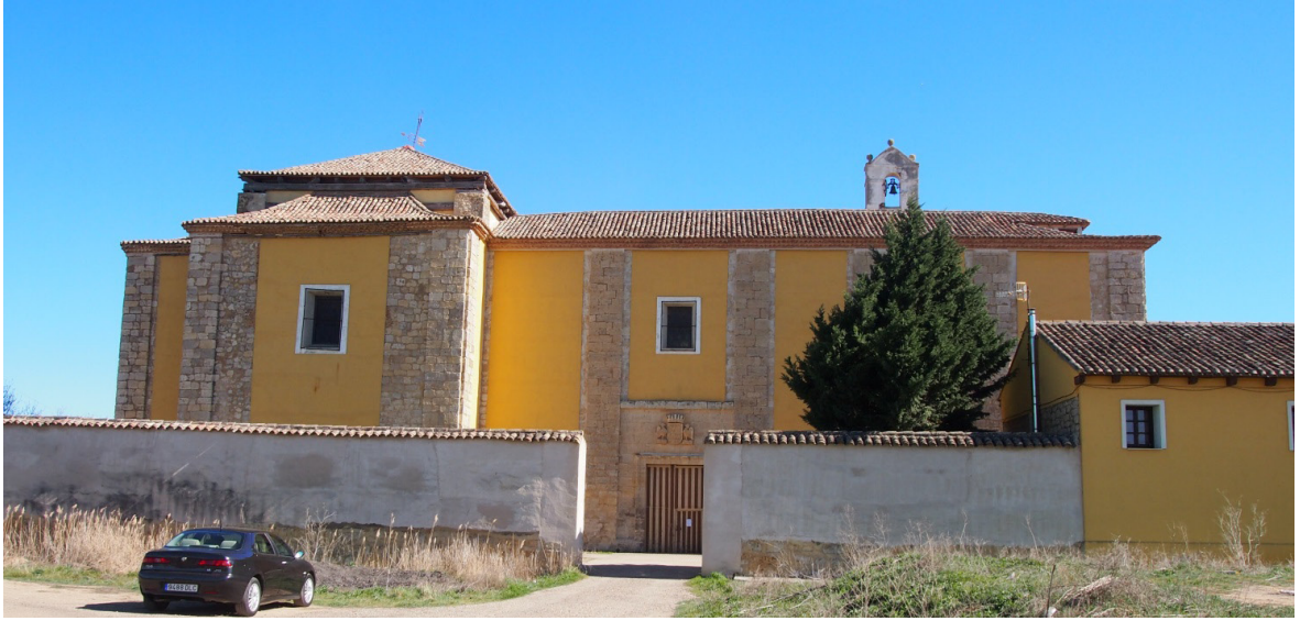
Figura 5.110. Iglesia del Convento de Santa Clara. Medina de Rioseco. (VA)
