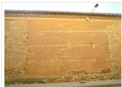
Machones de mampostería
