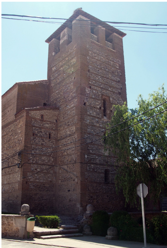
Figura 5.215. Torre de la iglesia de Santo Tomás de Aquino. Montejo de Arévalo. AV.
