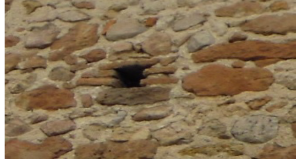
Figura 6.7. Mechinal de apoyo de andamio situado en la Iglesia del Salvador. Fuentepelayo. Ambos muestran una forma similar de ejecución, a pesar de la distancia geográfica.
