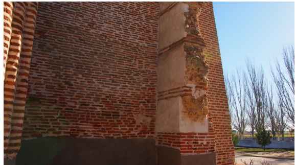
Figura 5.88. Iglesia parroquial de Cervillego de la Cruz. Detalle del muro de la antigua torre.
