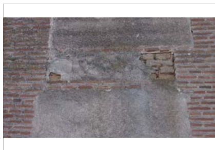
Detalle de muro norte, con machones y verdugadas de ladrillo. Cajón de adobe
