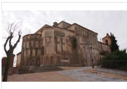
Ábside doble realizado con arcos doblados
