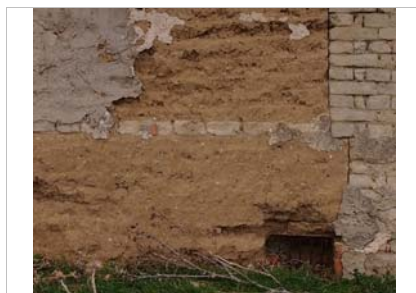
Detalle de la verdegada de adobe con mechinales intertos en ella.
