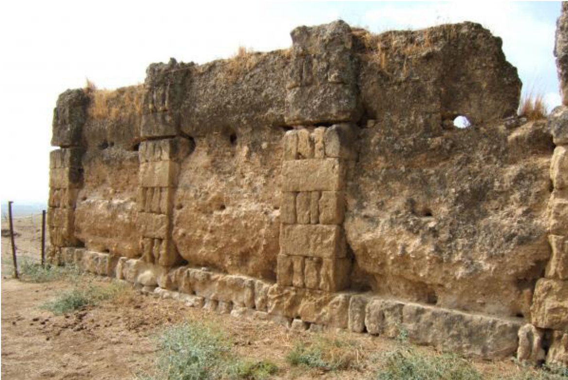
Figura 4.7. Almunia al-Rummaniyya. Villa de recreo construida por el tesorero del Califa al Hakam II, Durriir al-Sagir. S. X. Muro mixto de sillaría a soba y tizón y lienzos de tapia. Situado en Medina Azahara (Córdoba).
