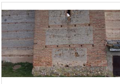
Lienzo de muralla con machones en esquinas y verdugadas en su desarrollo
