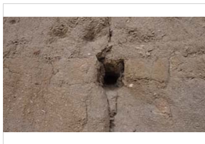
Detalle del mechinal en la verdugas de adobe
