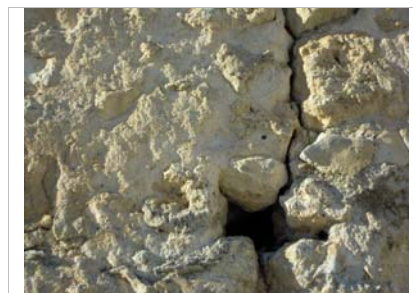
Detalle del mechinal en el borde del cajón de tapia
