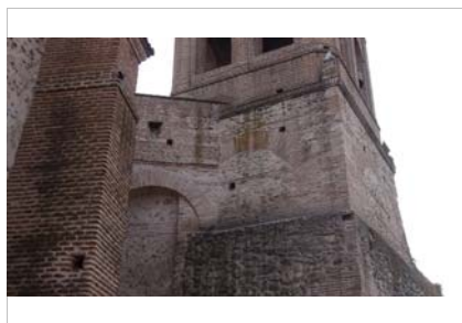
Cuerpo de la torre fajeado en ladrillo
