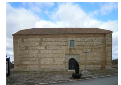
Fachada oeste. Verdugada con incipientes machones
