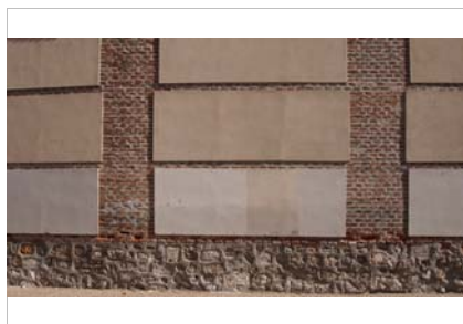
Muro de la iglesia.
