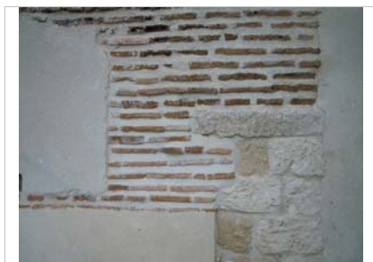
Machon que combina sillar y ladrillo
