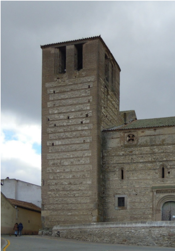
Figura 5.213. Iglesia de San Miguel, Arévalo
