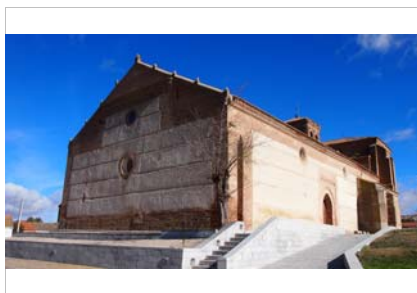
Fachada oeste. Muro verdugado y encadenado en esquinas
