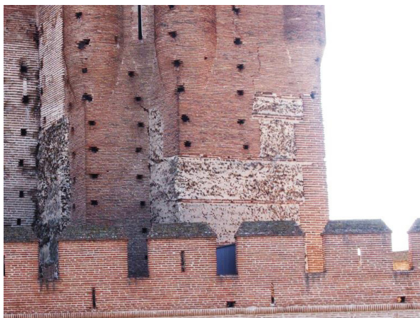
Figura 5.246. Detalle de la primera torre. Frenteado con verdugada de dos hiladas de ladrillo. Castillo de la Mota. Medina del Campos. VA.
