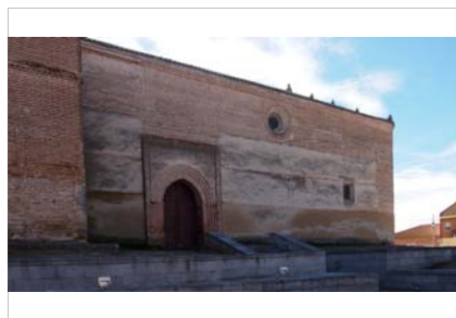
Fachada norte con portada. Muro verdugado y encadenado en esquinas
