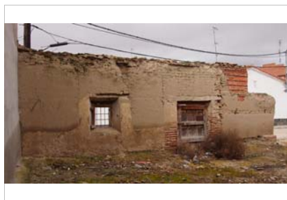
Hoja interior de la vivienda
