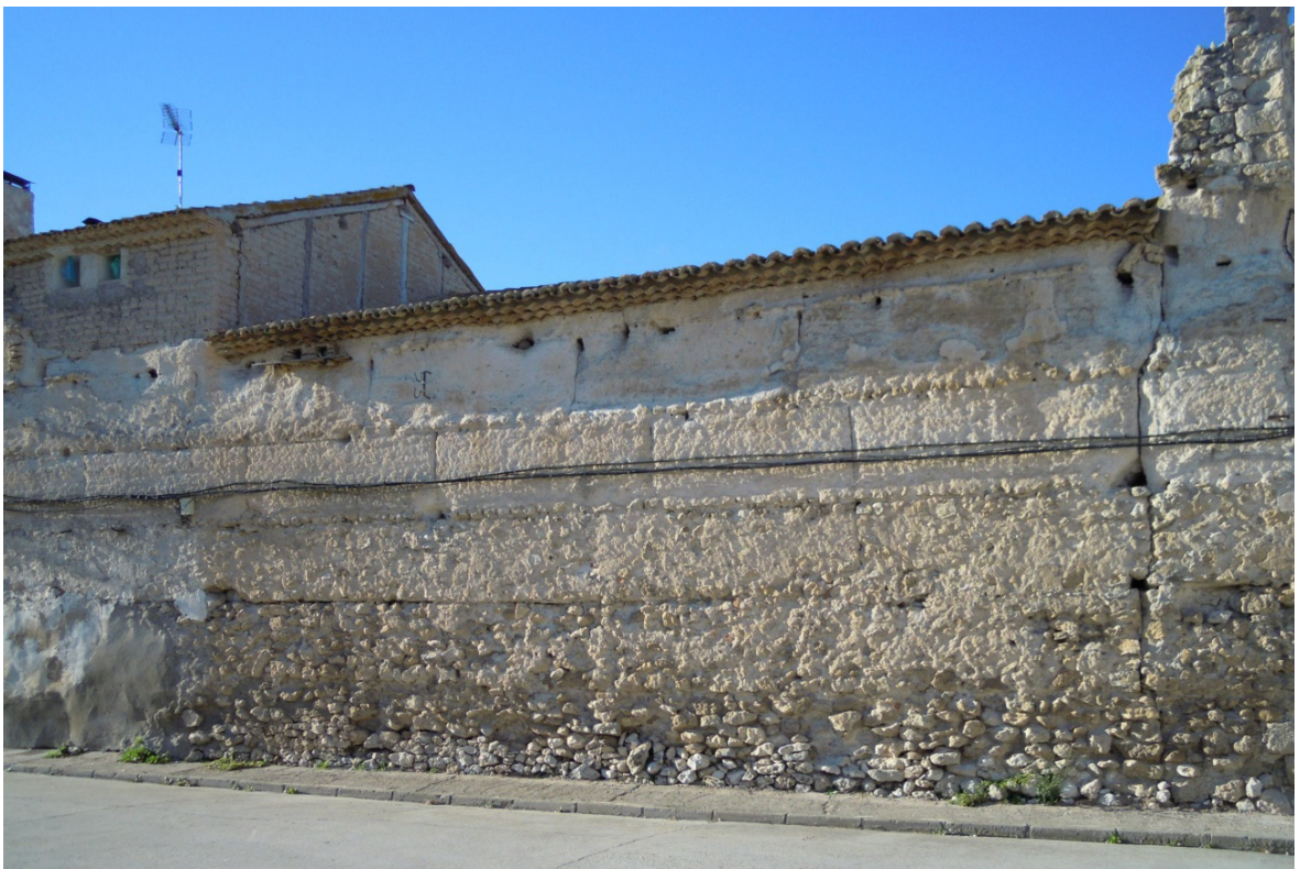
Figura 5.37. Detalle del lienzo del alzado Sur del palacio medieval de Laguna de Contreras. SG.
