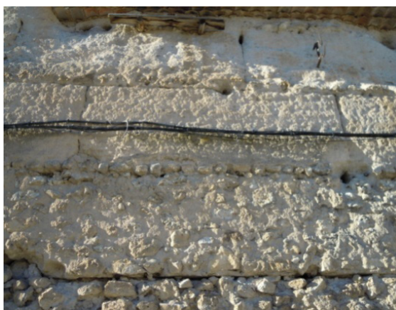
Figura 5.27. Detalle de la fachada principal del palacio medieval en Laguna de Contreras. SG.
