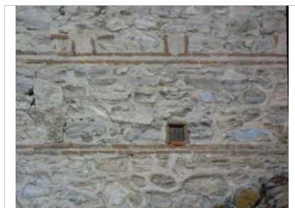
Detalle de mechina sobre verdugada en torre.
