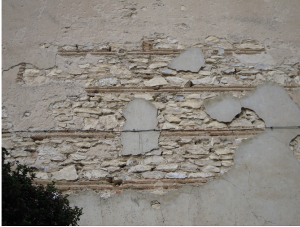
Figura 5.49. Detalle de la torre levantada con fábrica mixta de cajones de piedra rajuela rejuntada con mortero de cal y arena y encintada con verdugada doble de ladrillo.
