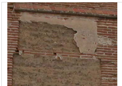
Detalle del mechinal en la verdugada
