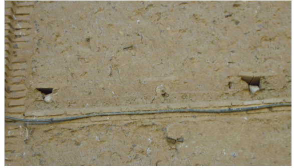
Figura 6.18. Sobre la verdugada. Iglesia de San Sebastián en Abarca de Campos. PA
