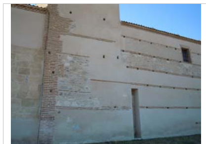
Fachada norte. Verdugada con dos hiladas de ladrillo
