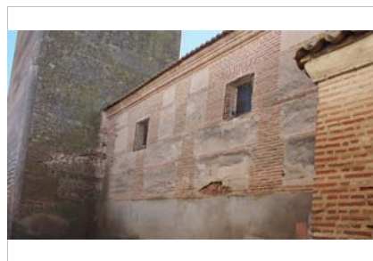
Vista de la torre y la nave en su fachada Norte
