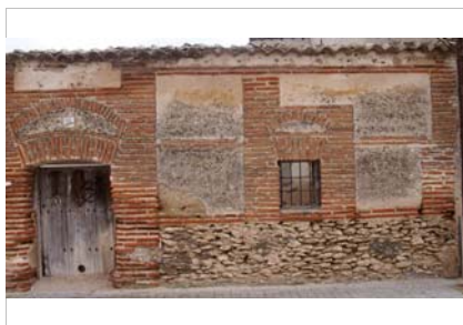
Hoja exterior de la vivienda
