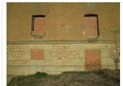
Zócalo de sillarejo con línea de imposta resaltada
