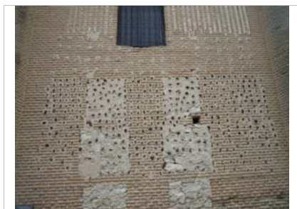
Detalle de muro
