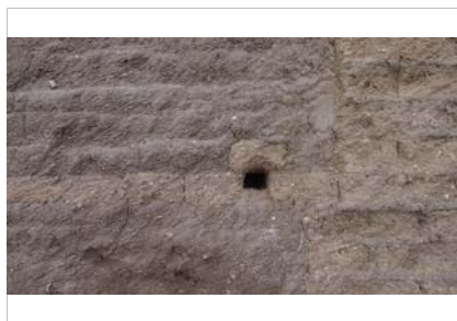
Detalle de mechina con protección de adobe en la parte superior
