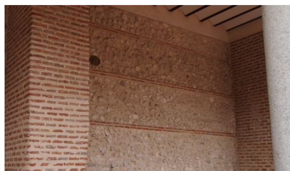
Figura 5.44. Detalle de la hilada inferior de la nave de la iglesia de Santa María del Castillo. Olmedo. (VA)
