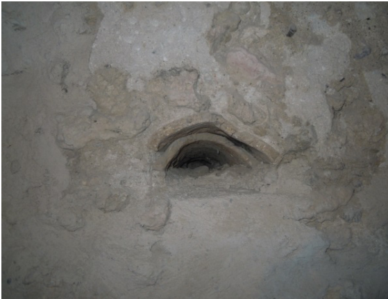
Figura 5.9. Detalle de mechina en la iglesia de San Esteban, Cuéllar (SG).
