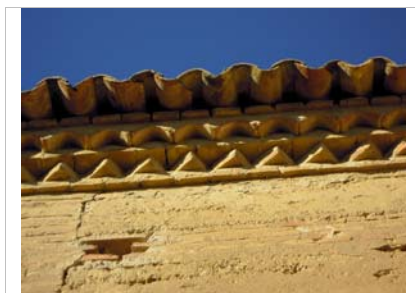
Alero con ladrillos en esquinilla
