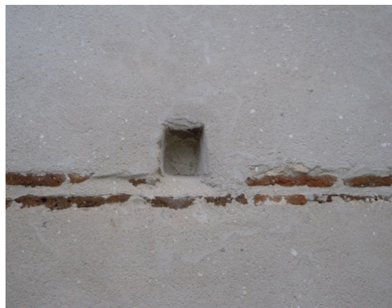
Figura 222. Detalle de mechinal sobre la verdugada de la torre de la iglesia parroquial de Pinarejos. SG
