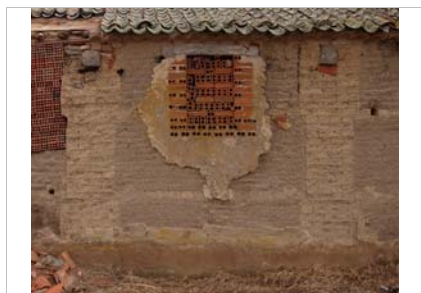
Muro de tapia reforzado con machones y verdugadas
