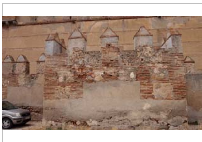
Detalle de la muralla exterior
