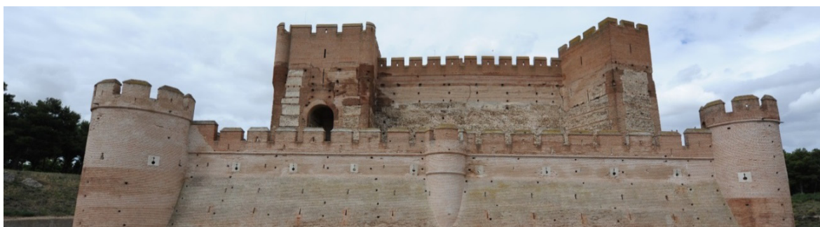
Figura 5.244. Lienzo oeste donde se aprecian los restos originario de muralla de la repoblación (S. XII) en tapia unitaria a la que se unieron posteriormente las torres de planta rectangular levantadas en muro mixto.
