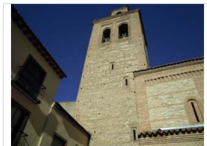
Torre de mampostería encintada
