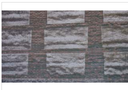
Detalle del muro de la nave
