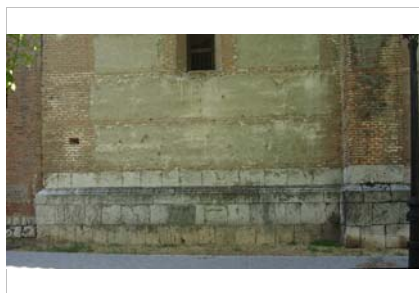
Zócalo de sillares
