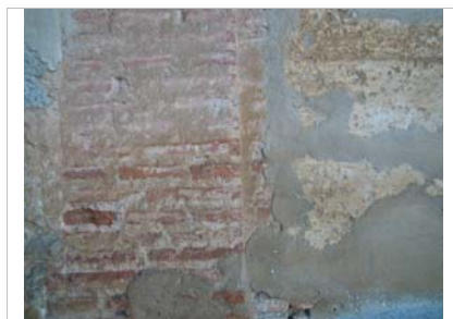
Detalle del machón de ladrillo
