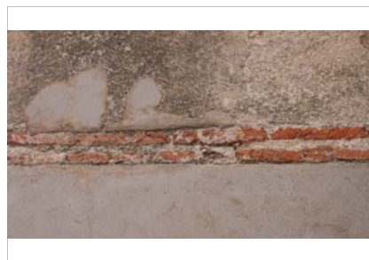
Detalle de mechina oculto en la verdugada
