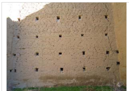
Muro Este realizado en adobe con alguna verdugada de ladrillo. Mechinales
