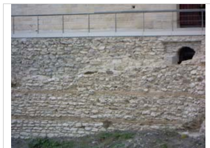
Foso del castillo con verdugadas de ladrillo y mampostería
