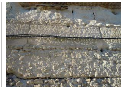
Muro sureste parte superior de tapia de tierra
