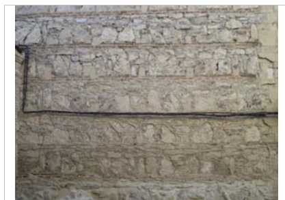
Fachada norte, detalle de la mampostería encintada con las verdugadas
