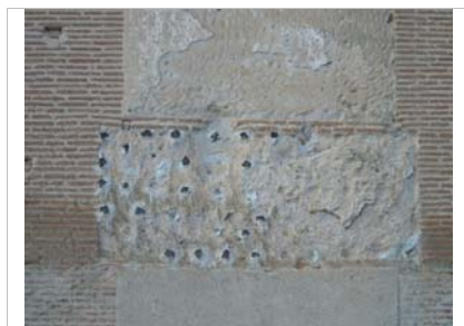
Detalle de revestimiento de cajón con escorias
