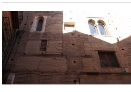
Detalle de las ventanas del muro mixto del palacio
