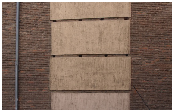
Figura 5.143. Detalle del muro del convento de las Descalzas Reales en Valladolid
