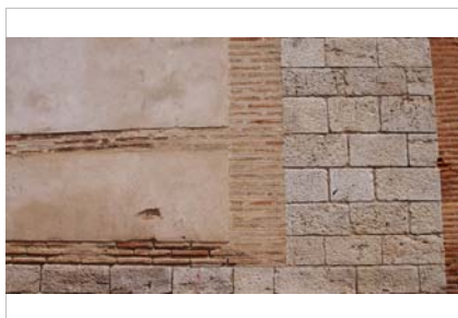
Detalle de la mezcla del sillar y el ladrillo
