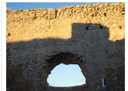
Lienzo de la nave, se observan las trazas de los cajones y su revestimiento.
