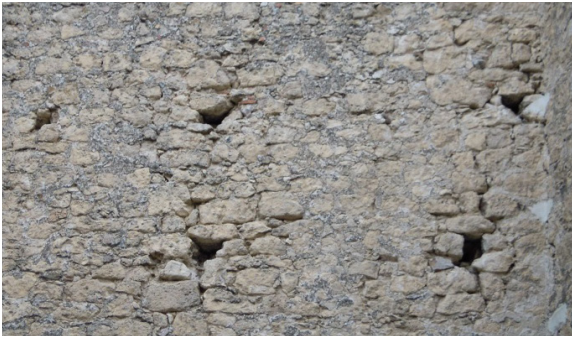
Figura 6.10. Tapia de mampostería con mechinal sobre el cajón. Iglesia de Santa María, Fuentepelayo. SG.
