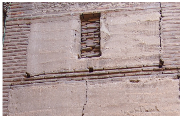
Figura 6.27. En la hilada superior sin elemento de remate. Palacio de Cascales en Segovia.
