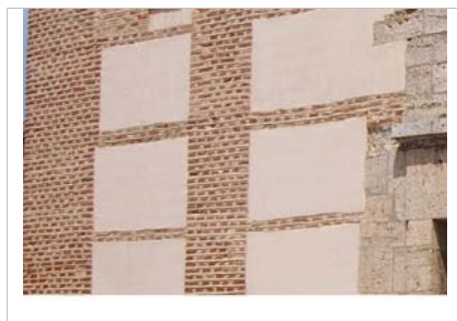
Detalle del muro con los machones rectos y las verdugadas
