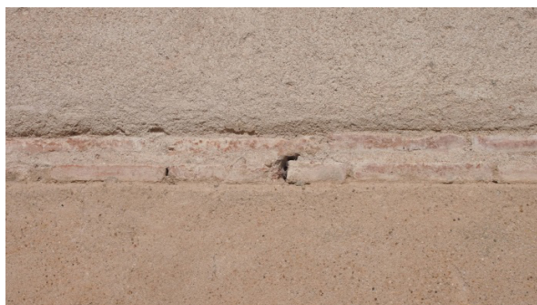
Figura 5.77. Detalle del mechinal de la nave de la iglesia de San Cipriano. Fontiveros. AV.
