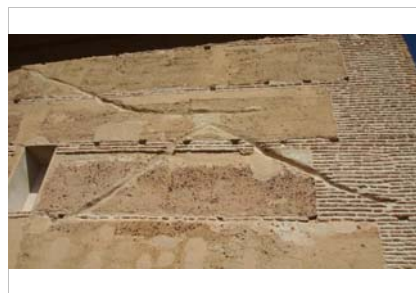
Machones de ladrillo en las esquinas y verdugado el resto del muro.
