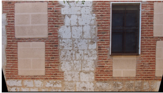
Figura 5.123. Detalle del machón con mezcla de sillarejo y ladrillo.
