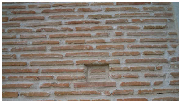
Figura 5.4. Fábrica aparejada. Detalle de muro de ladrillo en el Hospital Simón Ruiz de Medina del Campo (VA)
