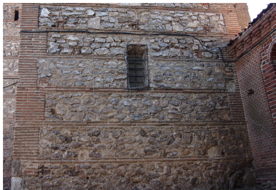
Figura 5.216. Iglesia de San Miguel, Arévalo
