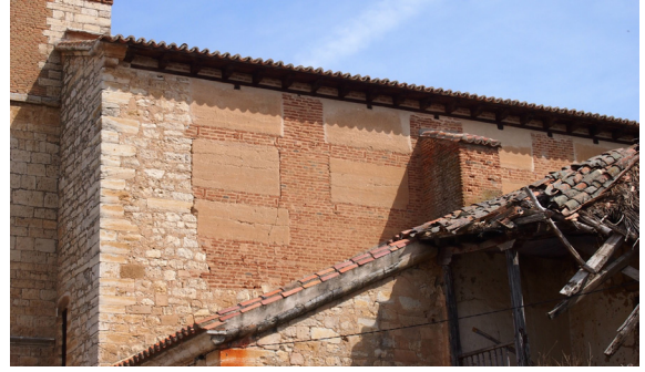
Figura 5.251. Detalle del muro de la iglesia parroquial de San Román de Hornija. (VA)
