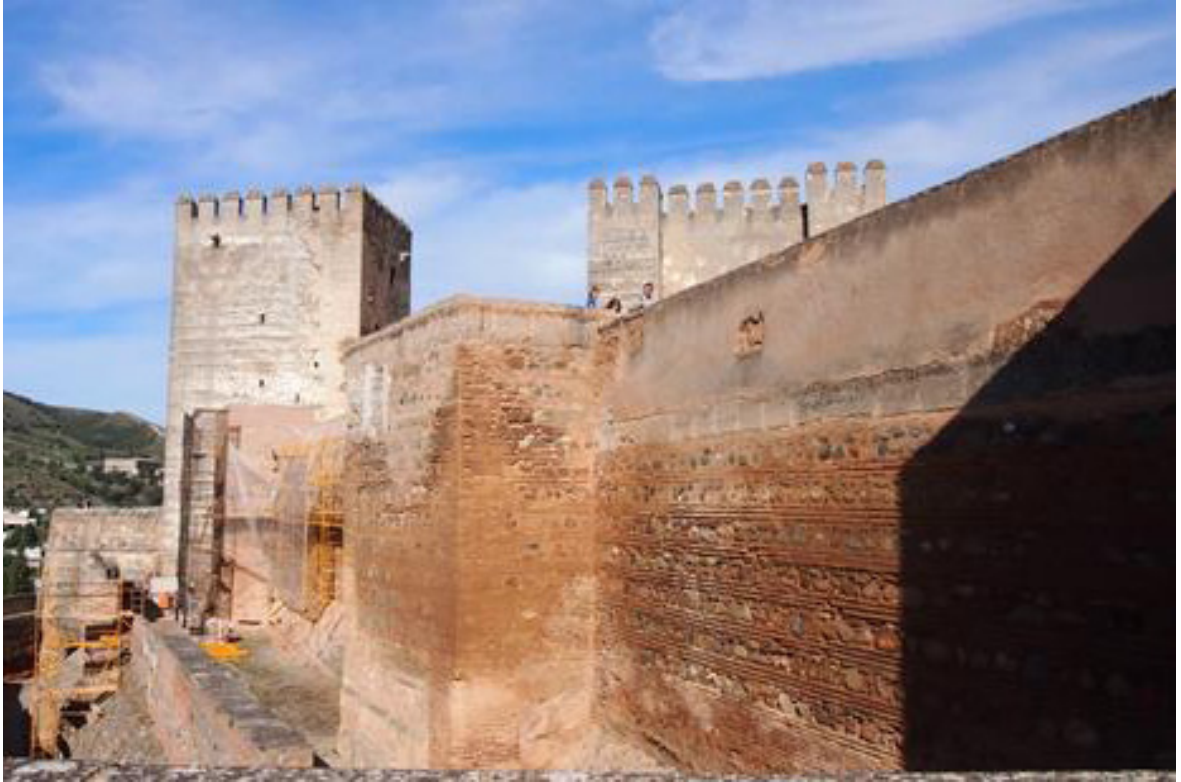
Figura 4.8. Alcazaba de la Alhambra de Granada. Verdugado de tres hileras de ladrillo y encadenado en esquinas.
