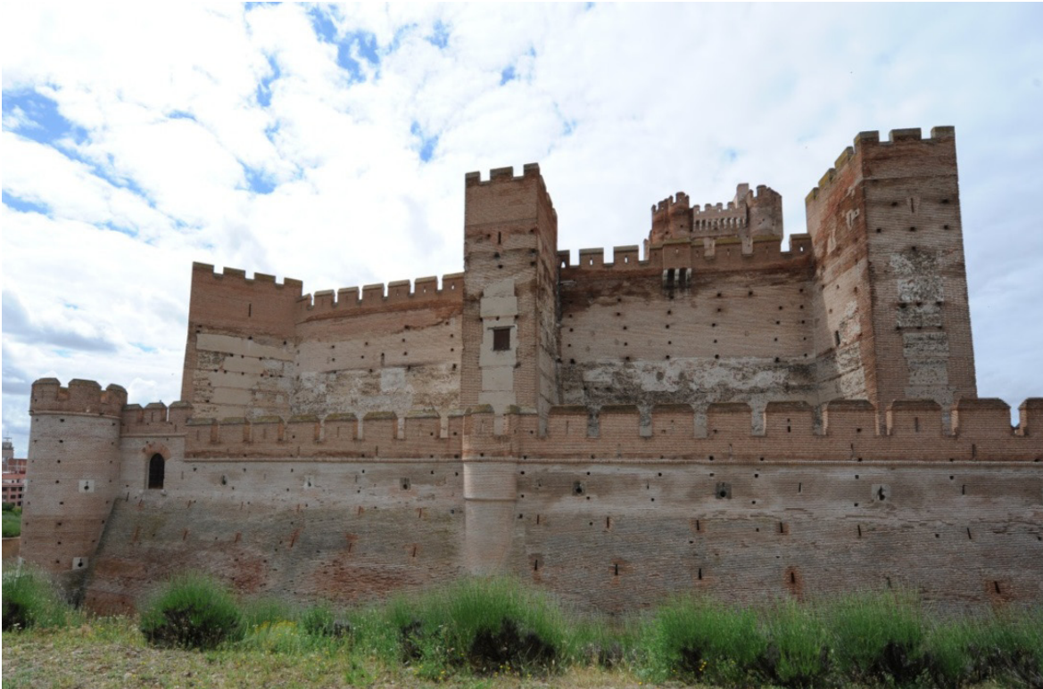
Figura 5.245. Lienzo sur, se aprecian los restos originario de muralla de la repoblación (S. XII) en tapia unitaria a la que se unieron posteriormente las torres de planta rectangular levantadas en muro mixto.
