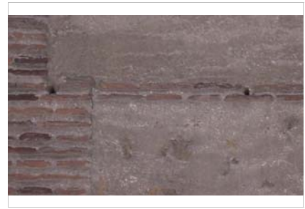
Detalle de los mechinales dentro de la verdugada.
