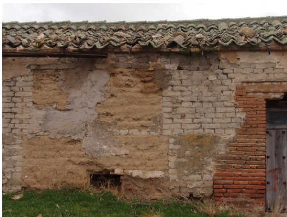
Figura 5.134. Detalle de muro del almacén agrícola en Rapariegos. SG.
