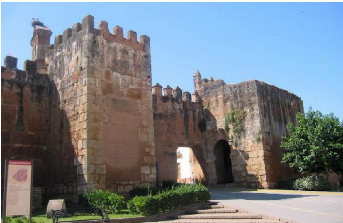
Figura 4.9. Murallas de Niebla (Huelva). Encadenado de sillar en esquinas de torres.
