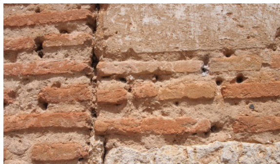
Figura 6.23. Oculto en la segunda hilada. Iglesia de Roncesvalles y Santa Catalina en Toro.
