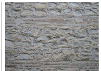
Detalle de lienzo de mampostería con tres verdugadas.
