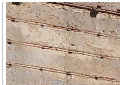
Detalle de los mechinales
