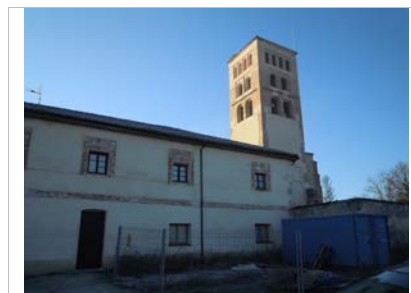
Edificación anexa y torre con cuerpos inferiores en calicanto y sup. en ladrillo
