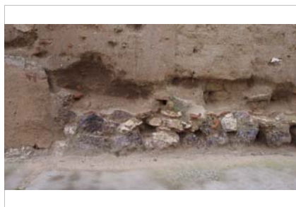
Zócalo realizado en mampostería de piedra
