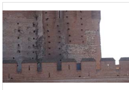
Detalle del muro mixto en una de las torres adosada a la muralla
