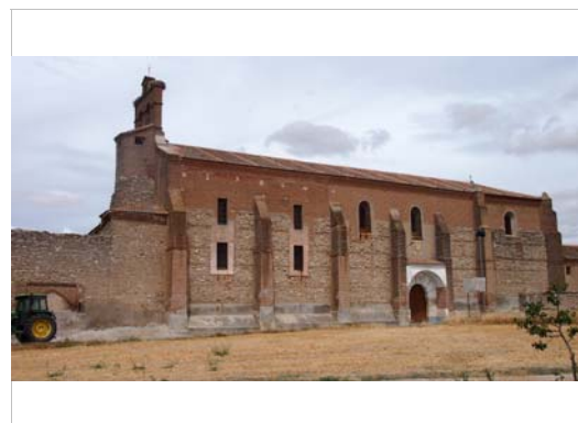
Imagen del trozo de edificio que cuenta con muro mixto
