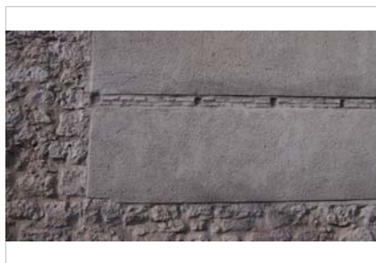
Detalle del muro: machón, verdugada y mechinales
