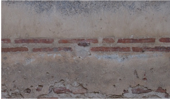
Figura 6.17. Sobre la primera hilada con elemento de remate. Iglesia de la Asunción en Fuente el Saúz. AV
