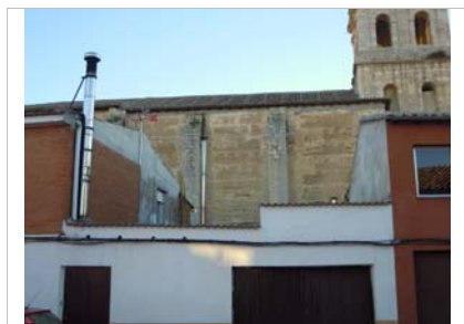
Muros realizados con machones de sillar y cajones de tapia.
