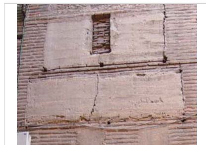
Detalle de los machones y las verdugadas con los mechinales
