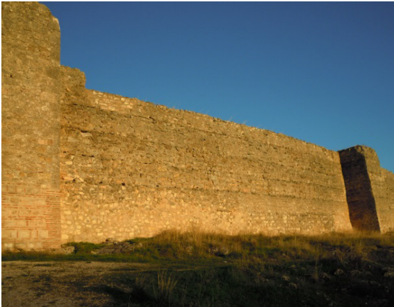
Figura 5.7. Imagen de la muralla de Fuentidueña. SG.
