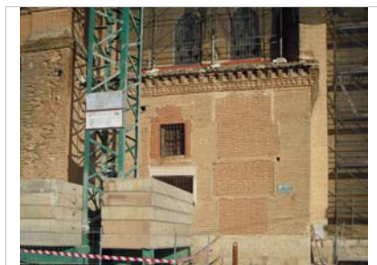
Muro sur. Cajones chapados en ladrillo
