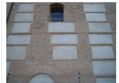
Detalle de los cajones de la facha
