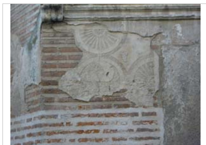
Revestimiento con esgrafiado sobre ladrillo
