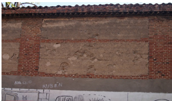
Figura 5.154. Detalle de cerca exterior del convento de Santa Teresa. Se aprecian las líneas de las tongadas y las protecciones de los mechinales con ladrillo.
