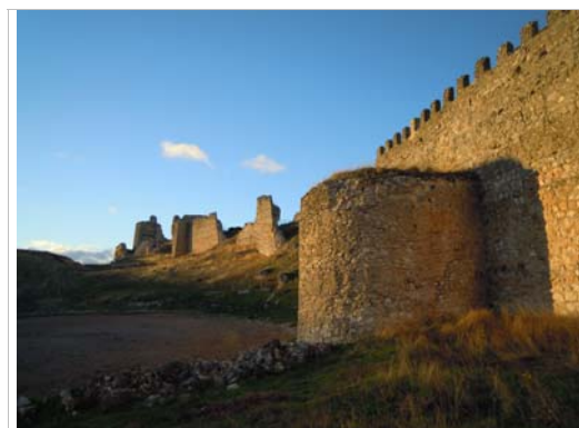
Foto general de la muralla
