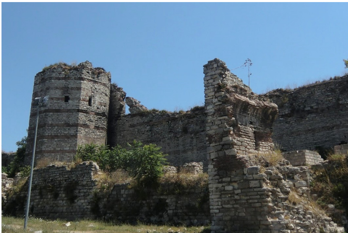
Figura 4.6. Muralla de Estambul. Construcción con sillería de piedra caliza y verdugadas de ladrillo.
