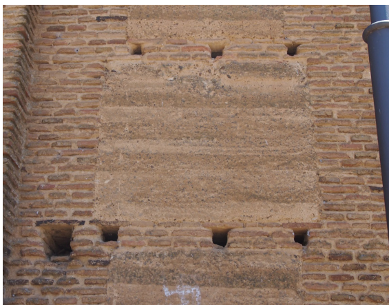
Figura 5.242. Detalle de las dos variedades de mechinal del Albergue de los Peregrinos Sahagún. (LE): el correspondiente al andamio y el correspondiente al encofrado.
