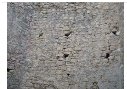
Muro este. Oquedades de los mechinales
