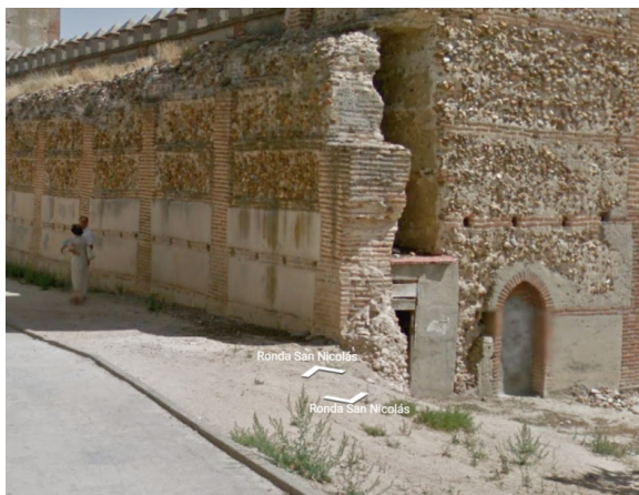
Figura 5.196. Detalle de alzado con machones y tres hiladas que atraviesan el muro.
