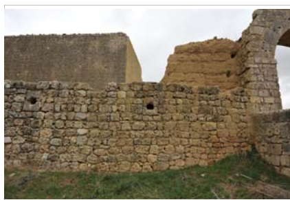
Núcleo de tapia, se aprecian restos de las hojas de piedra en la parte superior
