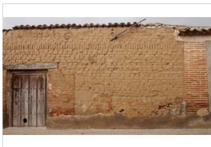
Parte del muro en adobe con detalle de adobes colocados en vertical en superior
