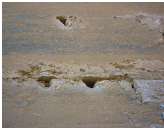
Figura 5.60. Detalle de los mechinales de la iglesia de San Justo y Pastor, Cuenca de Campos (VA)
