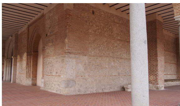
Figura 5.43. Nave de la iglesia de Santa María del Castillo. Olmedo. (VA)
