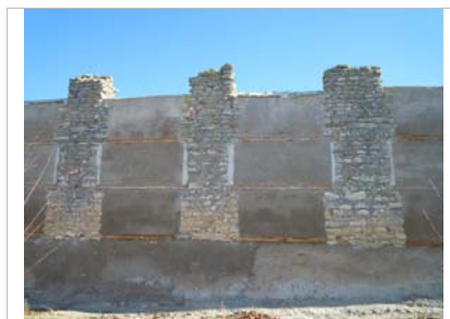
Cerca con mochones dentados de mampostería y verdugadas de ladrillo
