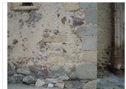
Refuerzo de sillares en esquinas
