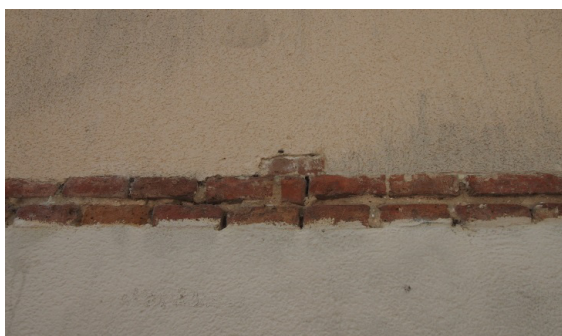
Figura 5.192. Detalle del mechinal situado en la segunda hilada con elemento de remate con ladrillo.
