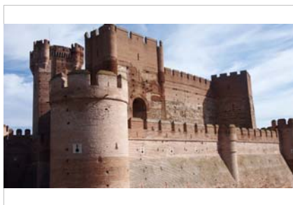
Vista general del conjunto
