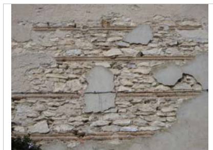
Dos hiladas de ladrillo con cajones de mampostería. Detalle de la torre.
