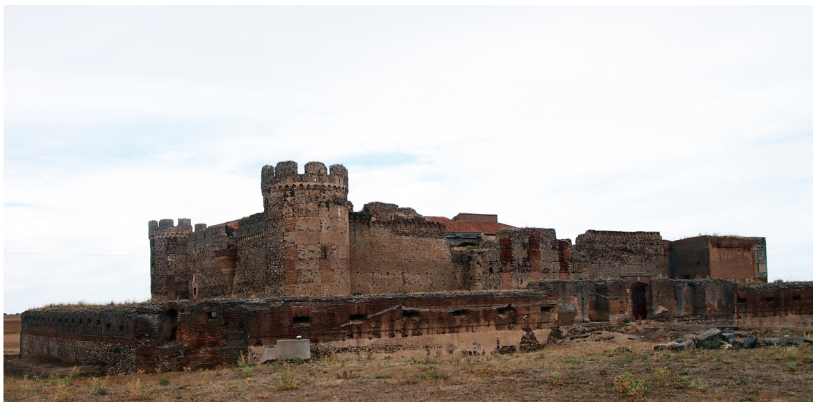
Figura 5.116. Imagen exterior del castillo de Castronuevo en Rivilla de Barajas. AV. Se aprecian dos de las torres semicirculares del recinto exterior levantadas con tapia mixta reforzada con machones de ladrillo.
