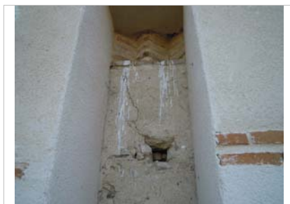
Muestra que se ha dejado en el muro norte.
