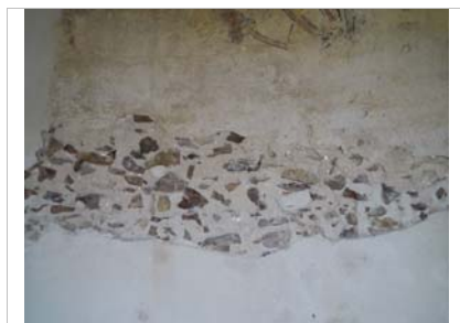
Relleno de la tapia con cal y canto
