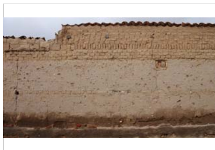
Muro mixto con verdugada de adobe
