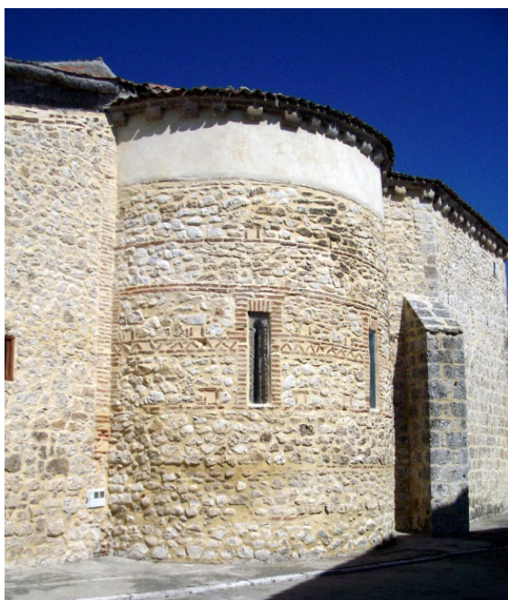
Figura 5.25. Parroquia Nuestra Señora de los Remedios. La Parrilla. VA. Imagen cedida por el Profesor José Ignacio Sánchez Rivera, profesor Titular de la Escuela Técnica de Arquitectura de Valladolid.
