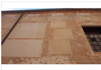
Detalle de los cajones con revestimiento.
