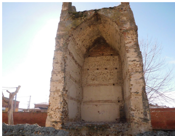
Figura 5.197. Detalle de torre albarrana con verdugadas de tres hiladas que atraviesan el muro.
