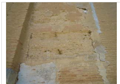
Detalle del cajón de tapia de tierra con mortero de revestimiento
