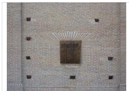
Muro norte de la torre. Presencia de mechinales
