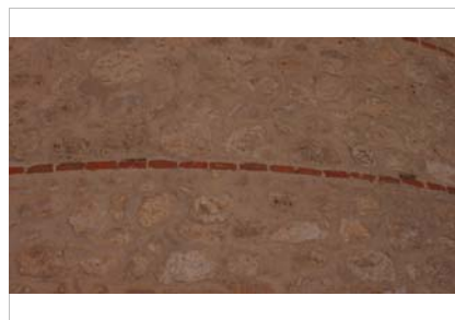
Detalle de los mechinales sobre la hilada.
