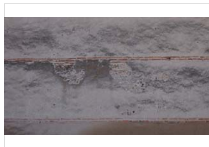
Detalle del verdugado de la fachada norte.
