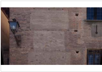
Detalle del muro mixto de machones y verdugadas de ladrillo
