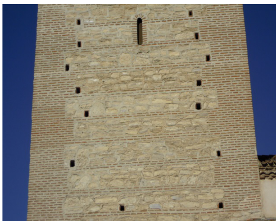
Figura 5.208. Torre de San Martín. Arévalo.
