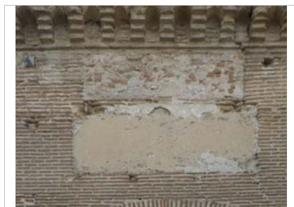
Detalle del muro norte, cajones con revestimiento de mortero.
