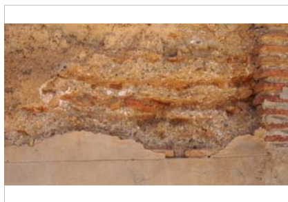
Mortero de cal entre las tongadas de tierra.
