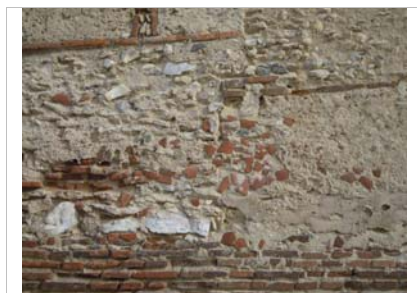
Detalle de la unión del contrafuerte a los pies de la nave
