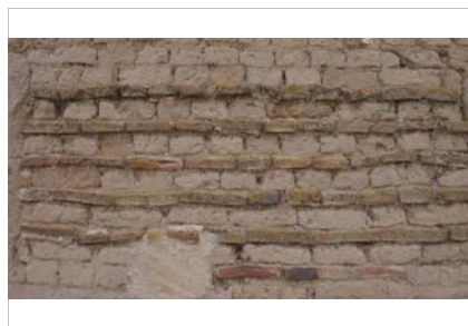
Entre las verdugadas se han colocado ladrillos
