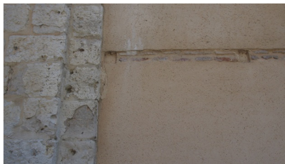
Figura 5.160. Detalle del encuentro de las verdugadas con el machón en la fachada de la iglesia del Monasterio de las Huelgas Reales en Valladolid.
