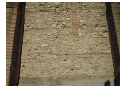
Detalle de muro de la nave
