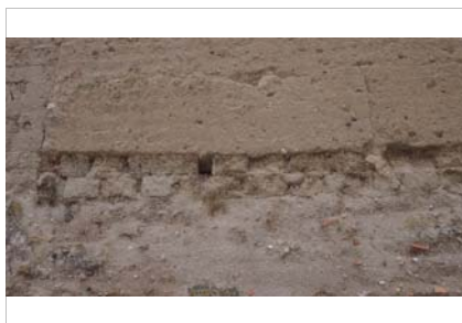
Verdegada doble de adobe con mechina
