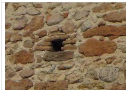
Detalle del mechina. Elemento de remata de ladrillo
