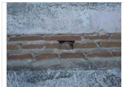
Detalle del mechinao oculto mediante un ladrillo
