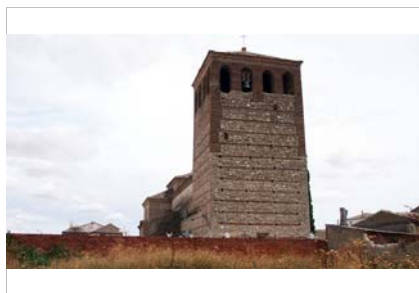
Torre original de tapia mixta fajeada con ladrillo
