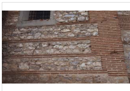
Detalle del machón y verdugadas del tramo recto del ábside
