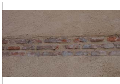
Detalle de la verdugada con tres hiladas.
