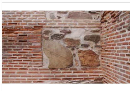
Detalle relleno del entrepañó
