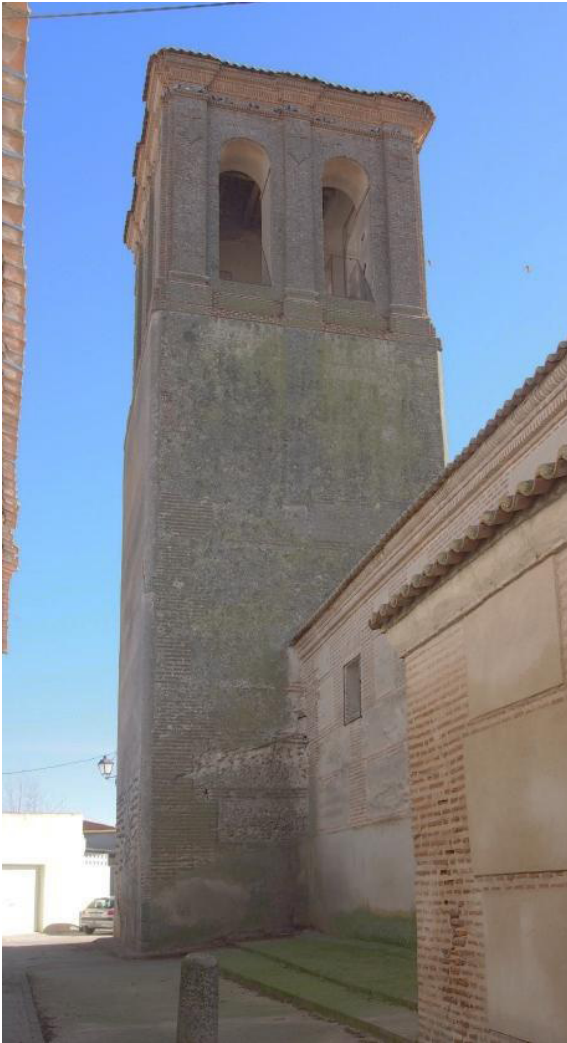
Figura 5.247. Torre de la iglesia de San Miguel, en Aldeaseca. Esgrafiado con despiece de sillares.
