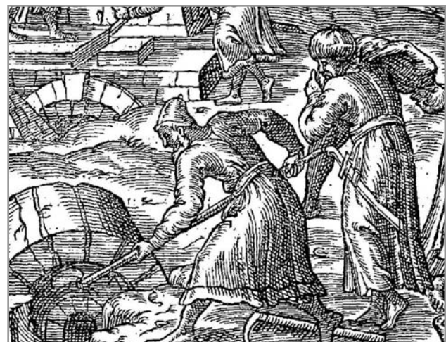
Figura 4.- Desmantelamiento de antiguos monumentos.
