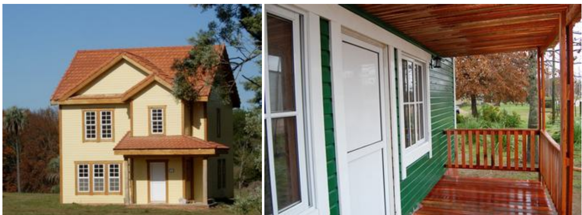
Fig. 6.14. E. grandis : Casa tipo canadiense en INTA – Casa de tipo social construida por INTA en Concordia
