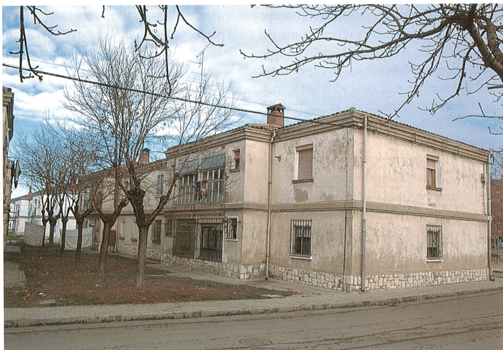
Vista de una parte de las viviendas de la primera fase del Poblado Endesa. Un pequeño núcleo extraño y no integrado en la dinámica general del Barrio España.
