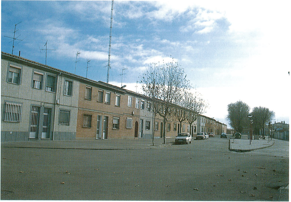
Vista de las viviendas sociales de promoción municipal en la calle del Roncal.
