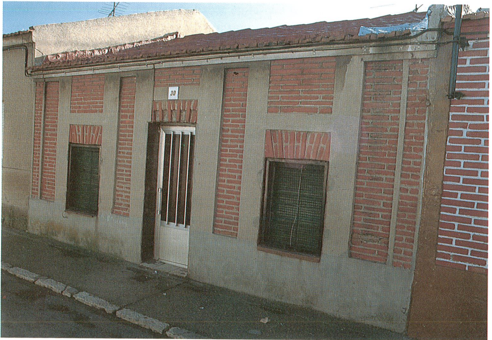
Una muestra de la pequeña vivienda molinera del Barrio España en la calle del Bierzo.
