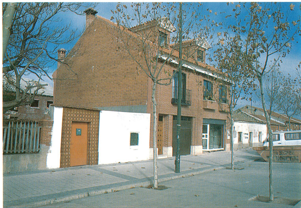
Ejemplo de sustitución de las viejas casas molineras en la Avenida de Santander, uno de los sectores de primera ocupación del Barrio España.
