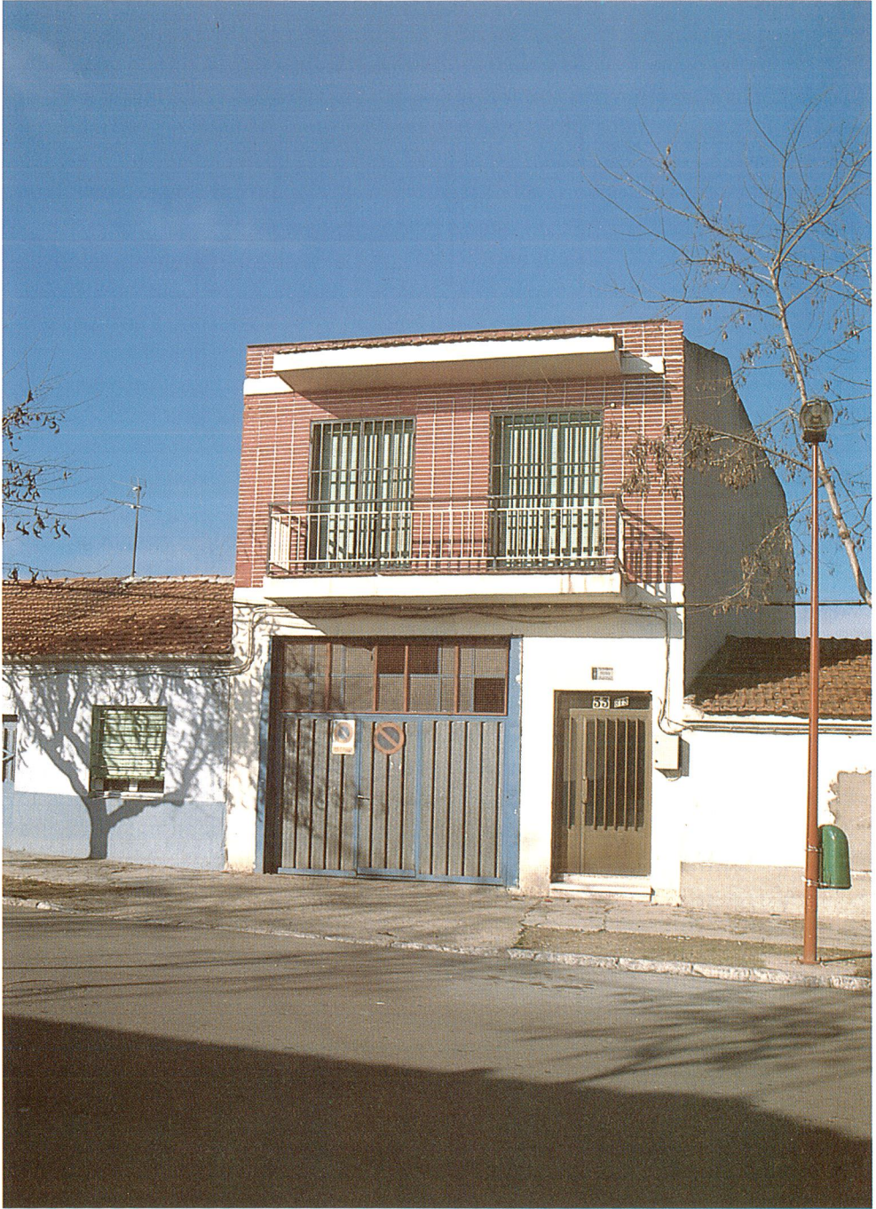
La «casa garaje». Un ejemplo de remodelado apoyado en la introducción de tipologías extrañas al barrio.
