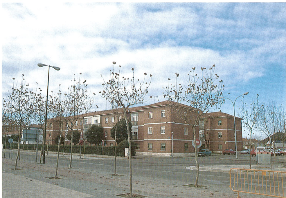
Vista del aspecto más cuidado que presenta la segunda fase de las viviendas del Poblado Endesa en la Avenida de Santander.
