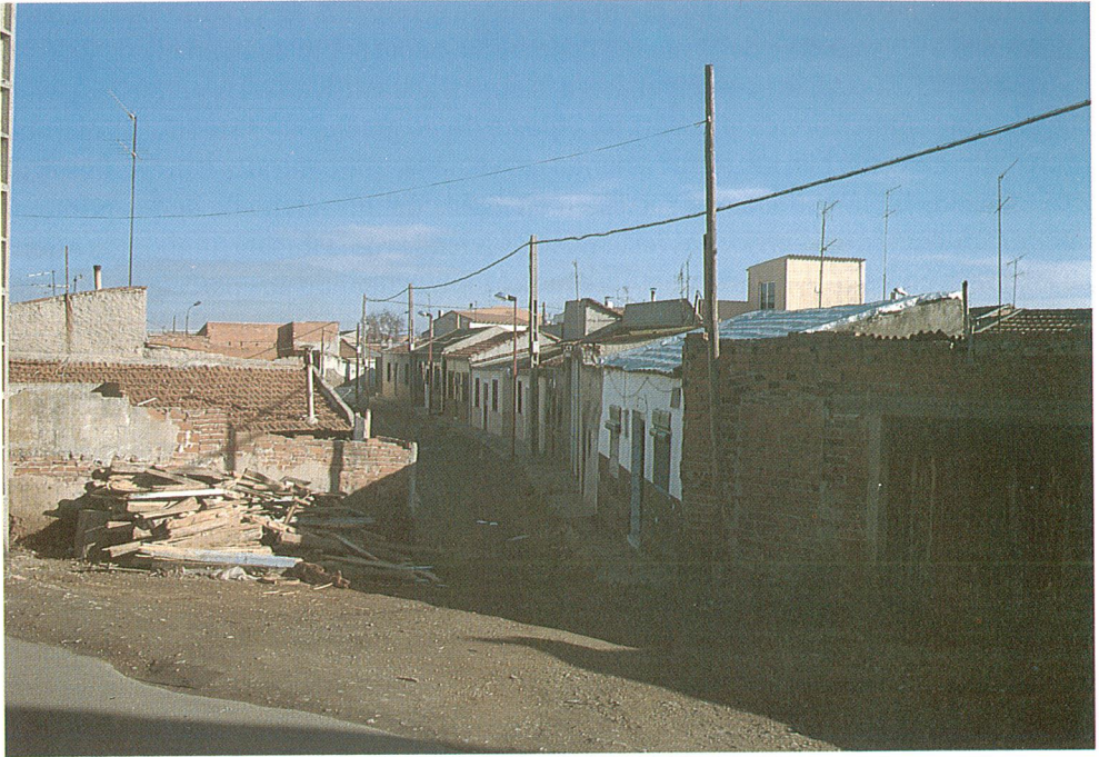
Vista de la calle Bergantiños. Uno de los sectores de más temprana ocupación sometido a un acusado proceso de degradación.
