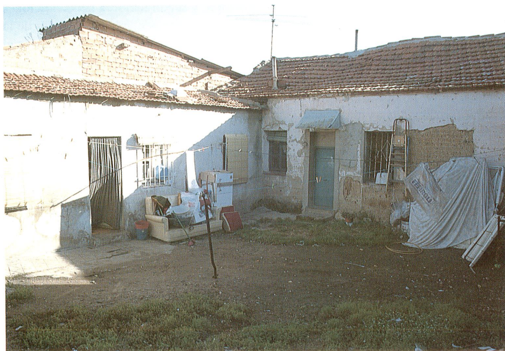
Degradación morfológica y marginación social asociadas a los restos de infraviviendas existentes en el tejido más antiguo del barrio. Extremo meridional de la calle Valle de Arán.
