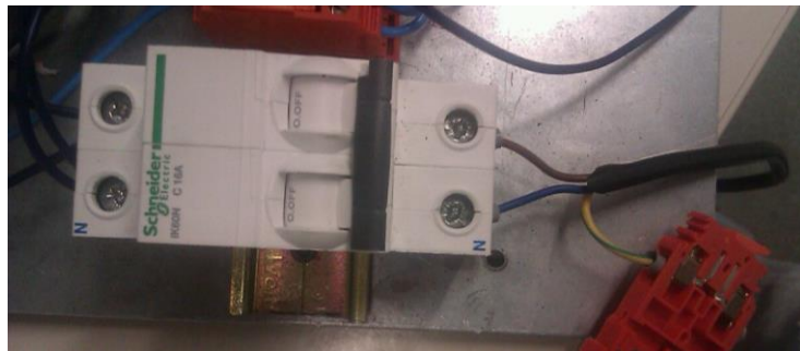
Figura 69. Montaje interruptor magnetotérmico
