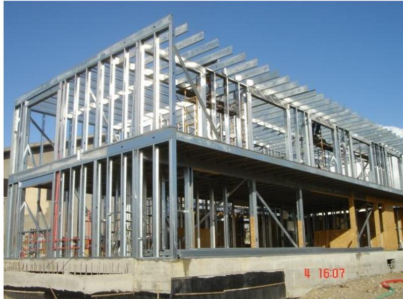
**Figura 6- Aplicación de perfiles conformados en frío en la construcción.**
