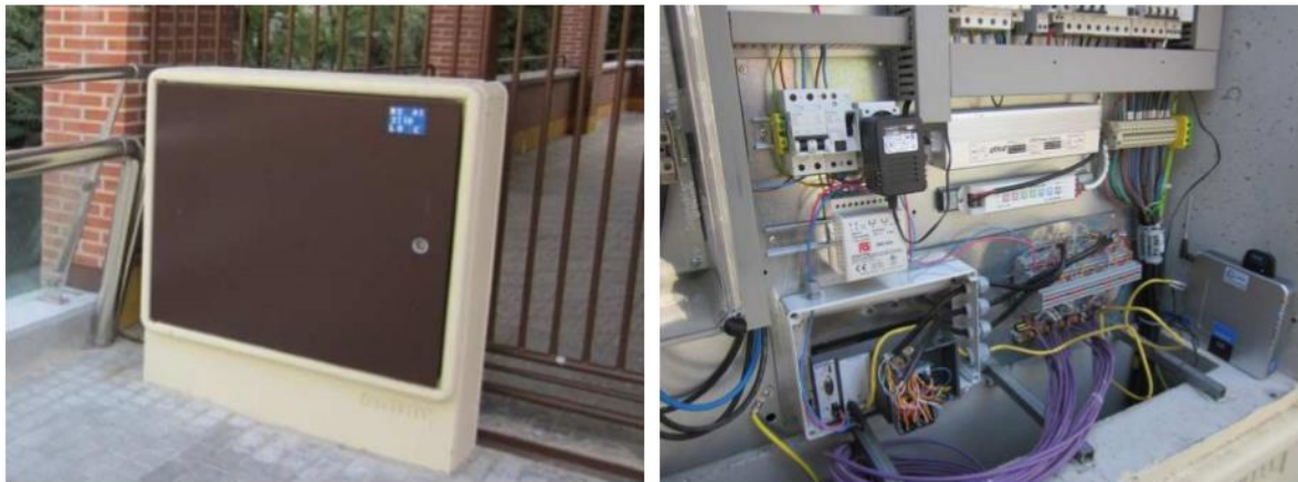
Figura 2.27. Sistema de adquisición de datos en la pasarela Pedro Gómez Bosque. (Jesús de Sebastián, 2013)
