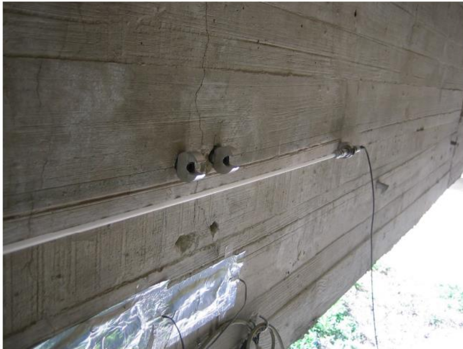
Figura 2.16. Disposición de los sensores en la viga. (Ingenieros, 2016)
