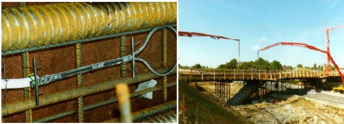
Figura 2.18. Puente de hormigón pre-tensado en Dresden (Alemania). (Meissner, 2016)
