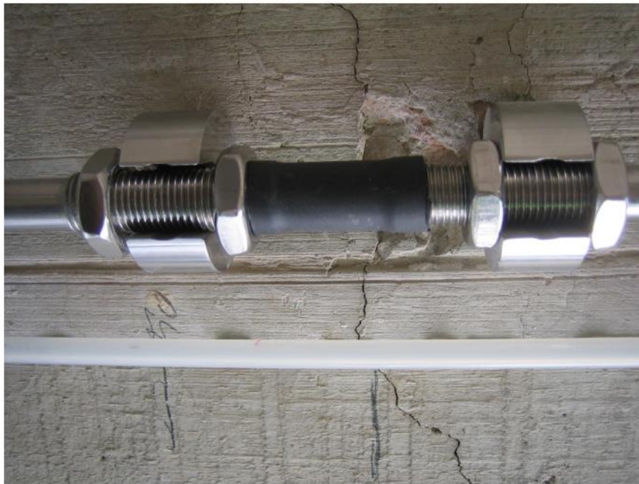
Figura 2.17. Instalación de los sensores en la fisura. (Ingenieros, 2016)
