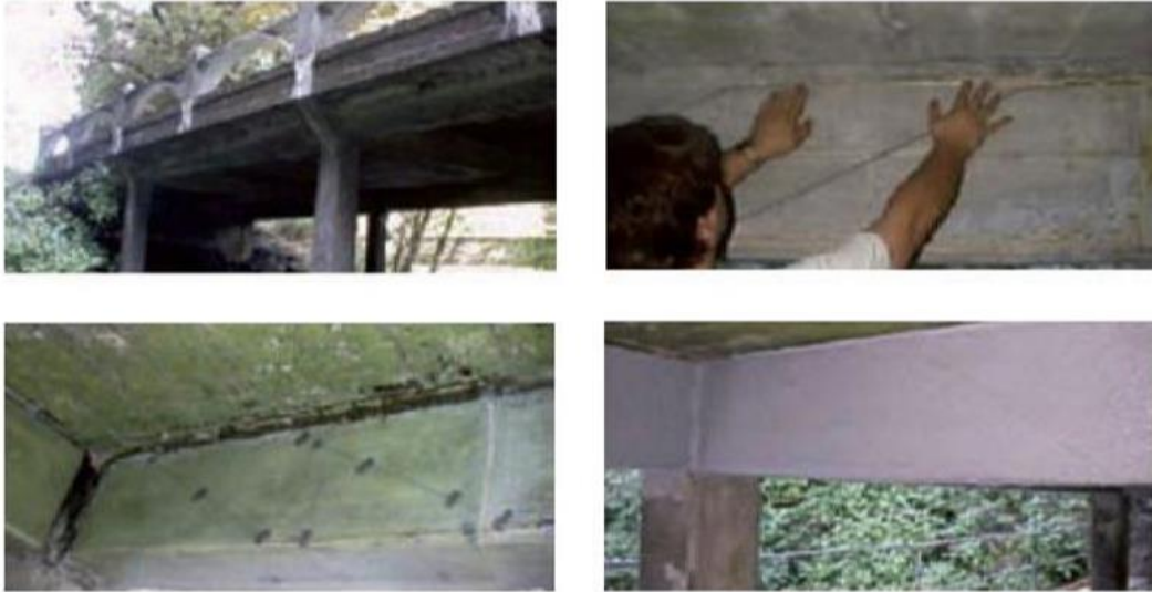
Figura 2.19. Instalación de sensores en el puente de Horsetail Falls (Oregón). (Llorente, 2014)
