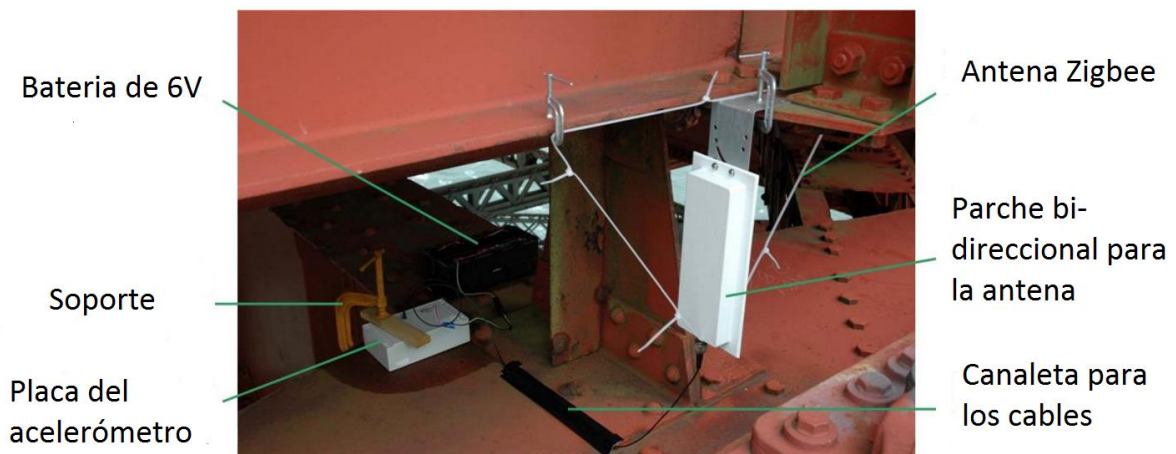
Figura 2.23. Instalación del nodo en el puente Golden Gate.
