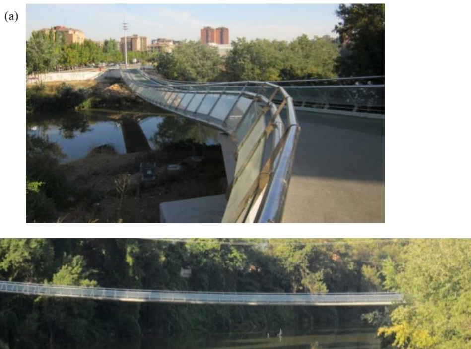
Figura 2.24. Pasarela Pedro Gómez Bosque. (a) Vista de la entrada a la pasarela. (b) Vista paisaje. (Jesús de Sebastián, 2013)
