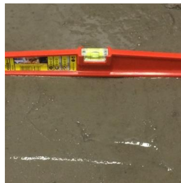
Figura III.8. Equilibrado superficie de hormigón mediante nivel
