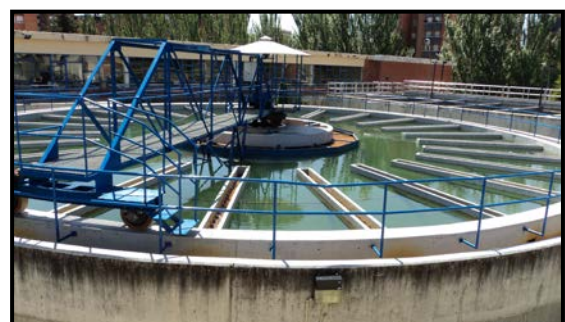
Figura 4. Sedimentador Acelerador con carro
