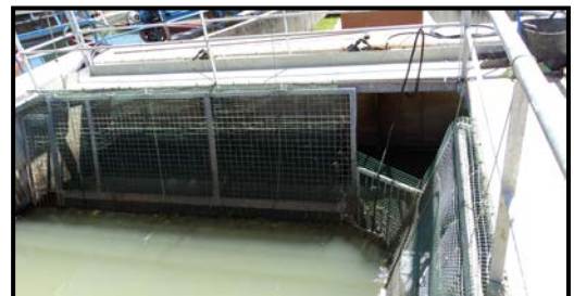
Figura 3. Torreta o cámara de mezcla (detalle desbaste)
