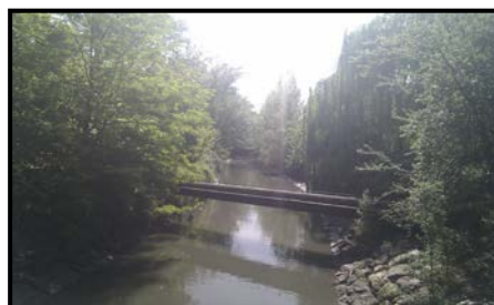
Figura 1. Zona de captación. Canal de Castilla
