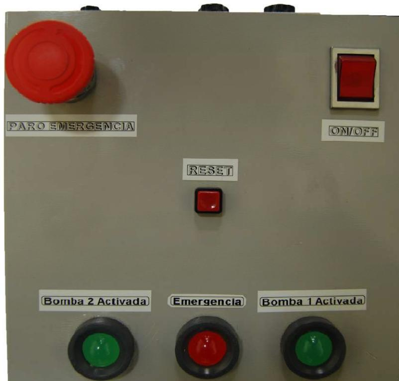
Figura 2.6.2.3 Botonería y leds del módulo
