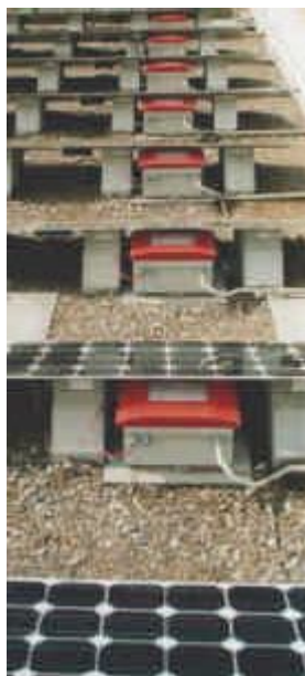
Figura 32. Ejemplo de colocación de inversores en cubierta.
