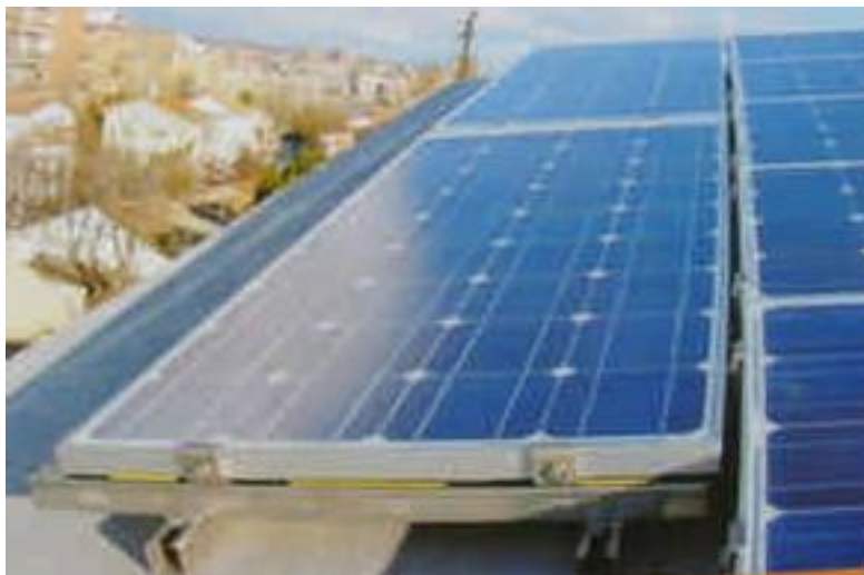
Figura 34. Estructura soporte de los módulos fotovoltaicos
