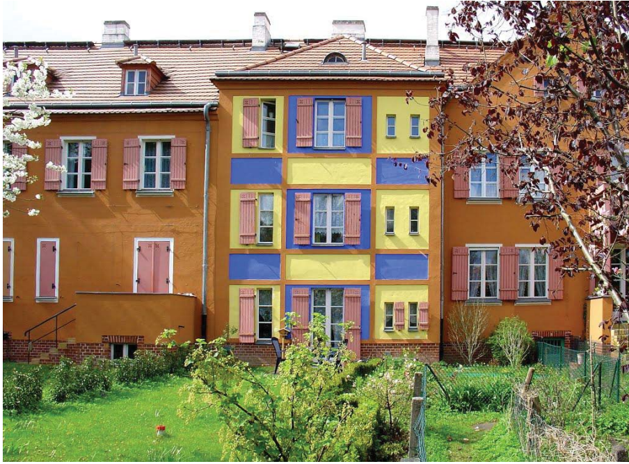
Fig. 1: fachada de las viviendas de la colonia Falkenberg en Berlín Grünau, B. Taut, 1913-1934.
