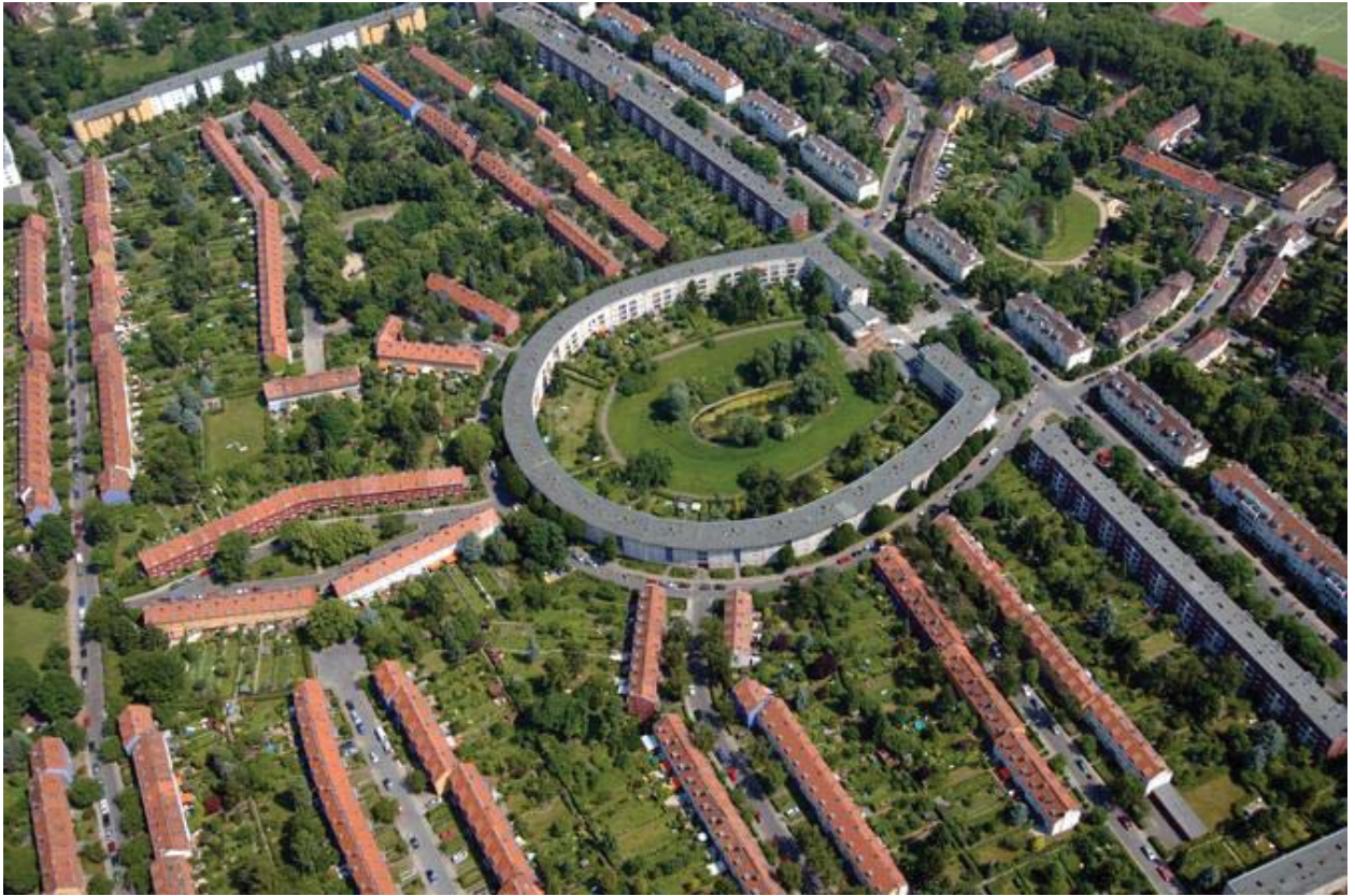
Fig. 28: vista aérea de la Siedlung de Britz , Berlín.
