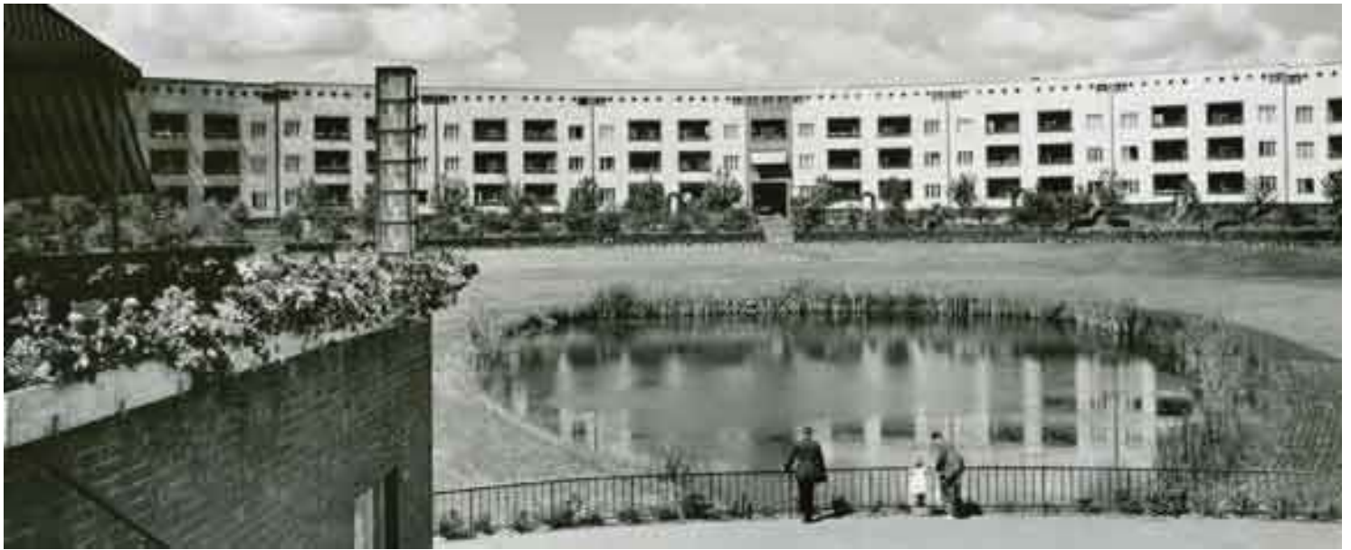
Fig. 30: vista del interior de la Herradura de la Siedlung de Britz en Berlín en el 1932, con el lago artificial y los diferentes patios privados.
