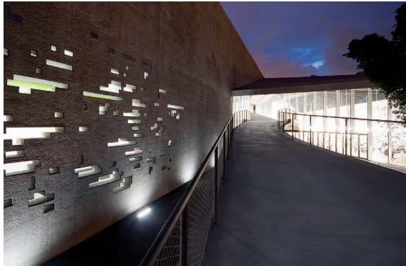
Img. 17: Acceso desde rampa parte inferior TEA.
