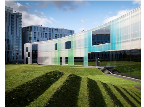
Img. 33: Fachada principal Centro Laban.
