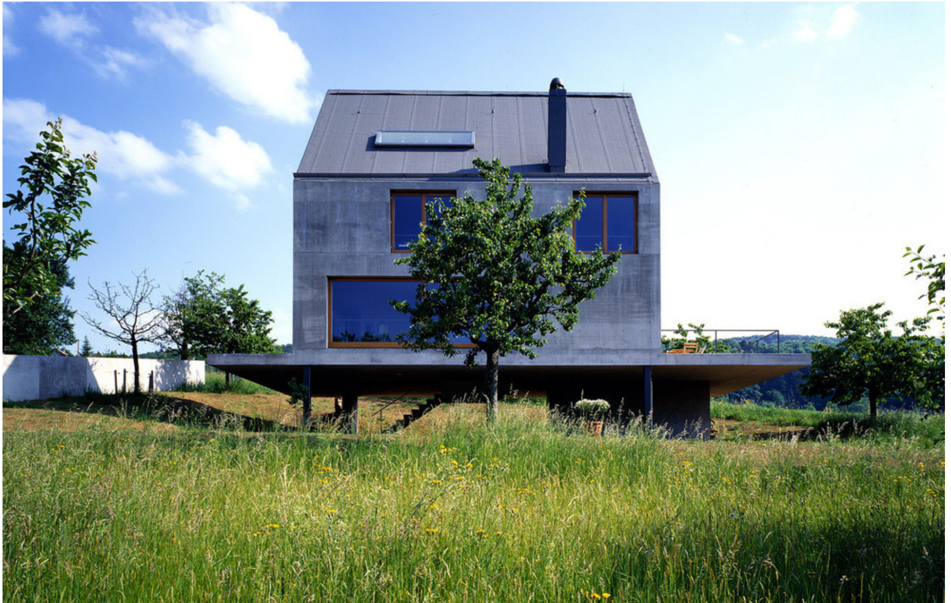
Img. 112: Vista general Casa Rudin.
