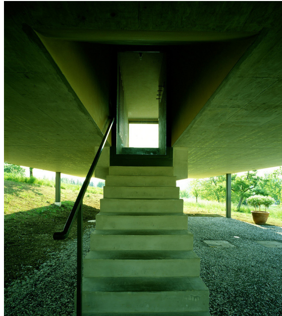
Img. 103: Entrada bajo plataforma.
