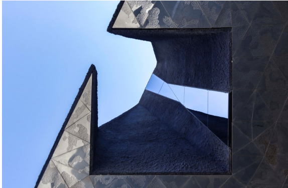
Imgl. 125: Lucernario cubierta Edificio Forum 2004.
