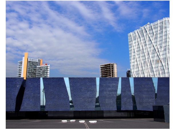
Img. 81: Vista lateral.
