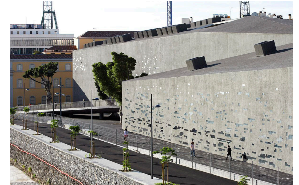
Img. 19: Lateral, cubierta y rampa TEA.
