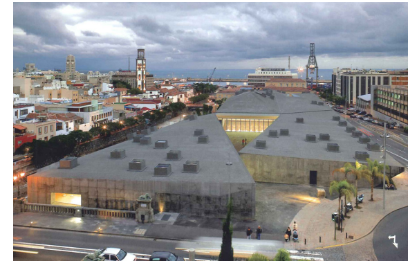
Img. 21: Vista frontal aérea.
