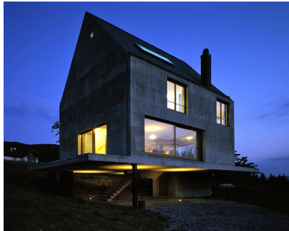
Img. 111: Vista nocturna iluminada.
