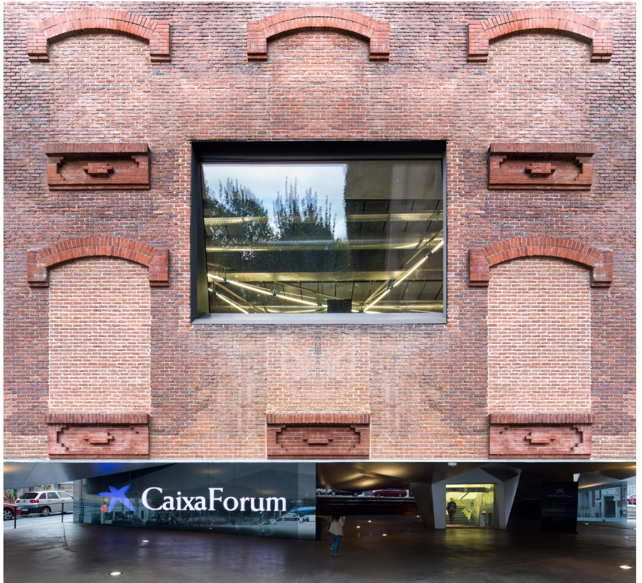
Img. 94: Vista entrada principal.
