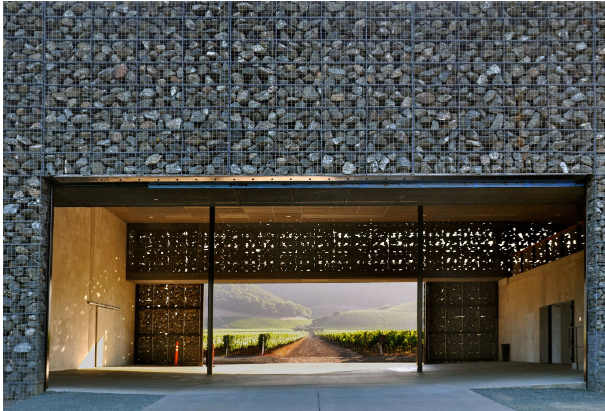
Img. 75: Fachada de gaviones de piedra.
