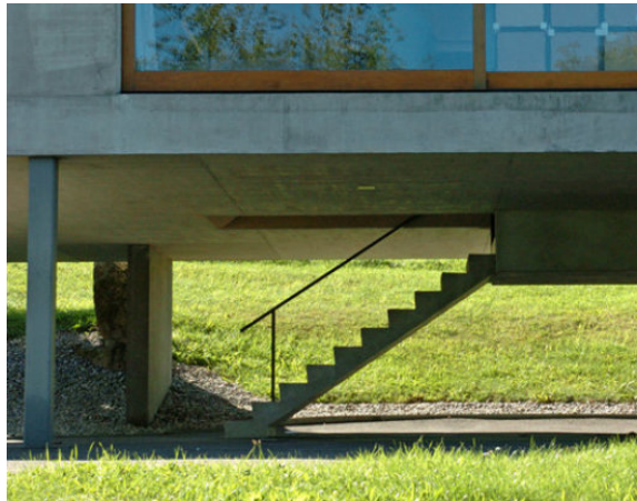
Img. 110: Entrada bajo plataforma.
