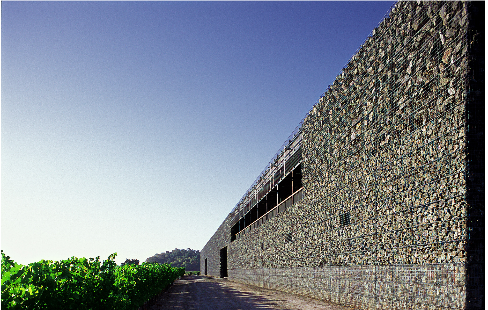
Img. 76: Fachada de gaviones de piedra.
