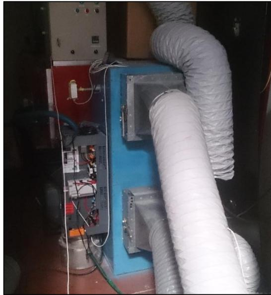
*Figura 12 - Unidad de Impulsión de Aire*
