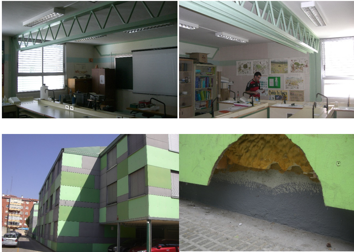
Imagen 29. Documentación fotográfica del IES Leopoldo Cano (David Cavero y autora). Arriba a la izquierda: laboratorio del instituto. Arriba a la derecha: interior de un aula del instituto; se observa la estructura metálica de cercha así como de pilares metálicos vistos en el cerramiento de fachada. Abajo a la izquierda: fachada actual del instituto. Abajo a la derecha: en un panel deteriorado de fachada se ha podido observar y hacer mediciones del montante de madera y del material aislante.
