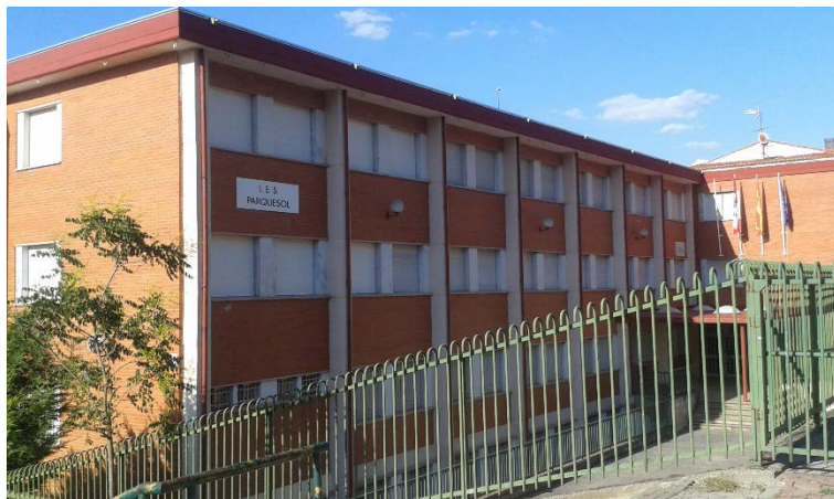
Imagen 5. IES Parquesol en calle Juan de Valladolid. (Autora)
