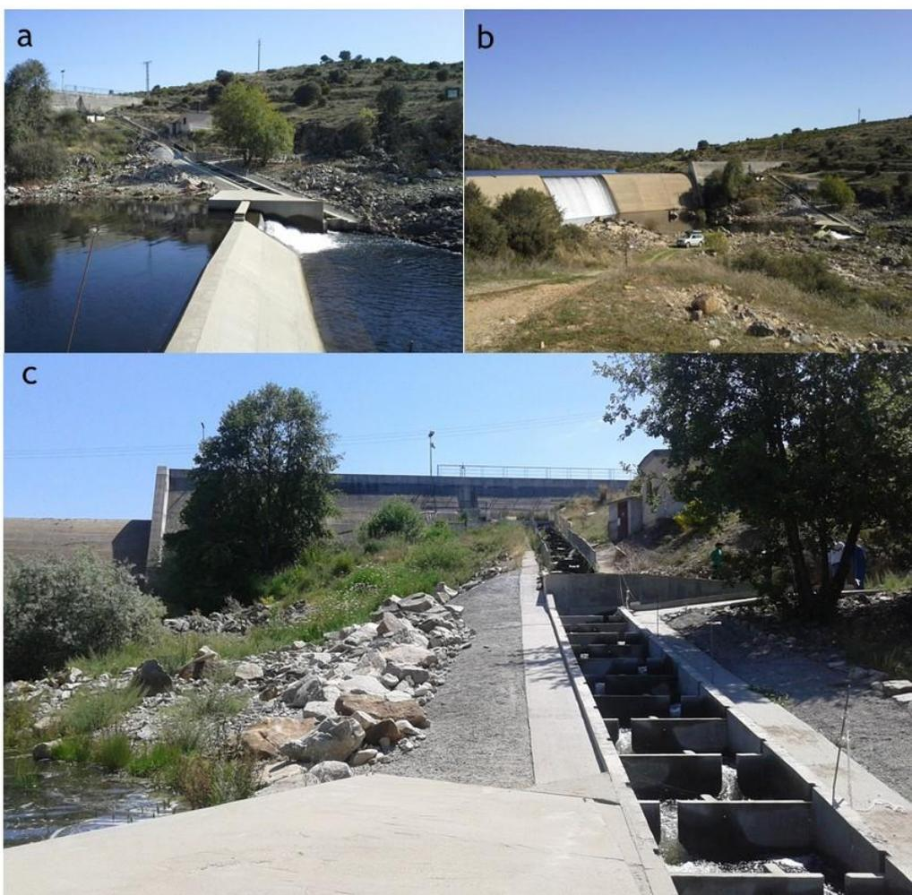
**Figura Nº 1.** Microembalse de la Presa San Fernando, justo aguas debajo de la presa (a), presa de San Fernando (b) y escala para peces (c).
