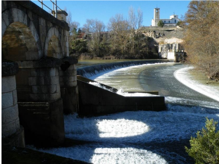
Figura 14. Estado actual del azud de Guma, detalle de la estructura a demoler.
