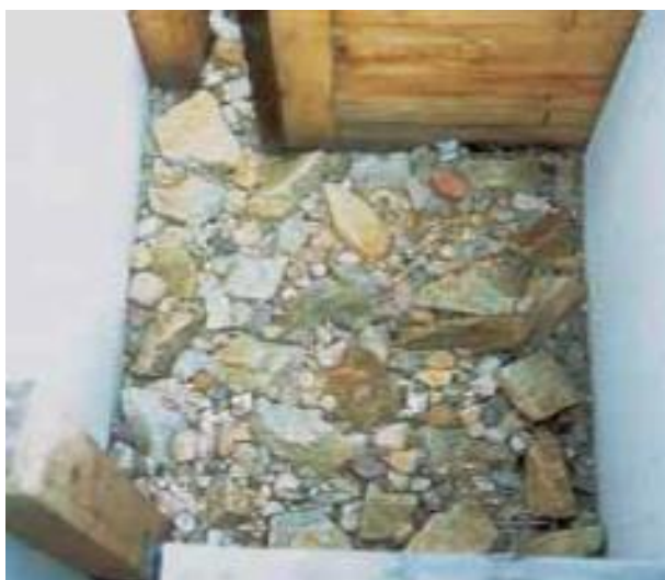
Figura 4. Detalle del lecho en un estanque de una escala (FAO/DVWK, 2002).
