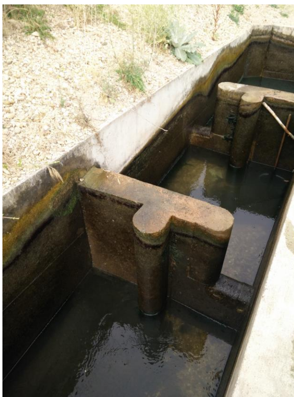
Figura 10. Ejemplo de tabique con vertedero sumergido y orificio de fondo en Quintana del Puente (Palencia).
