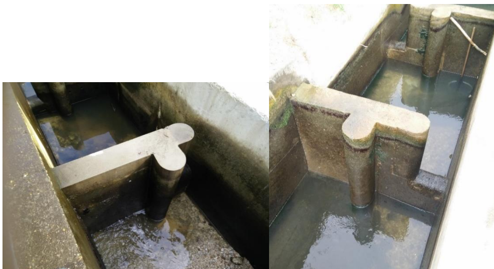
Figura 6. Detalle de escala de vertedero sumergido y orificio sumergido.
