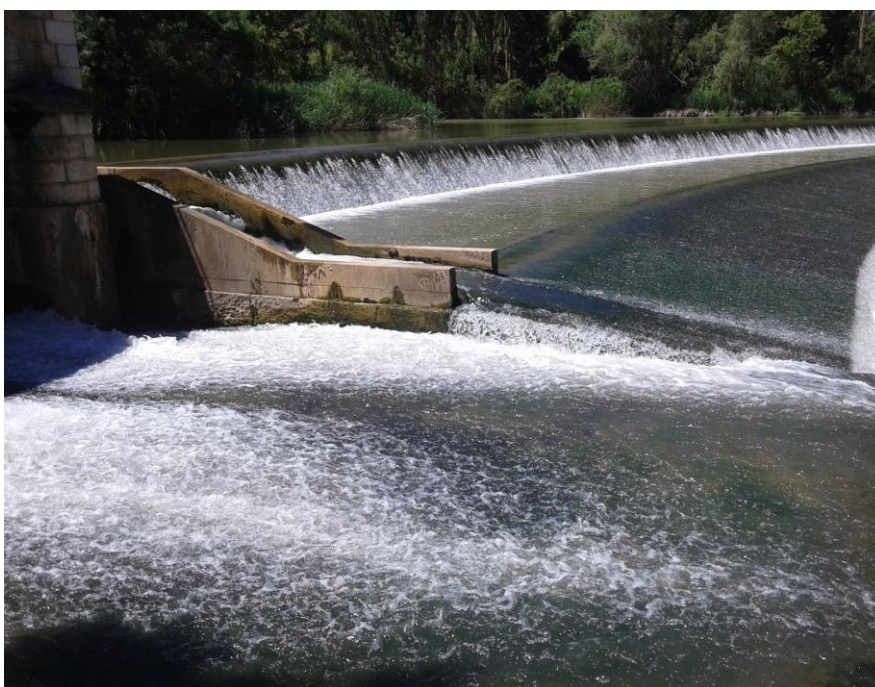
Figura 2. Situación actual de la antigua escala sobre el azud de Guma.
