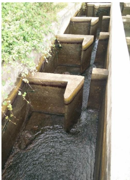
Figura 5. Detalle de escala de hendiduras verticales en Quintana del Puente.
