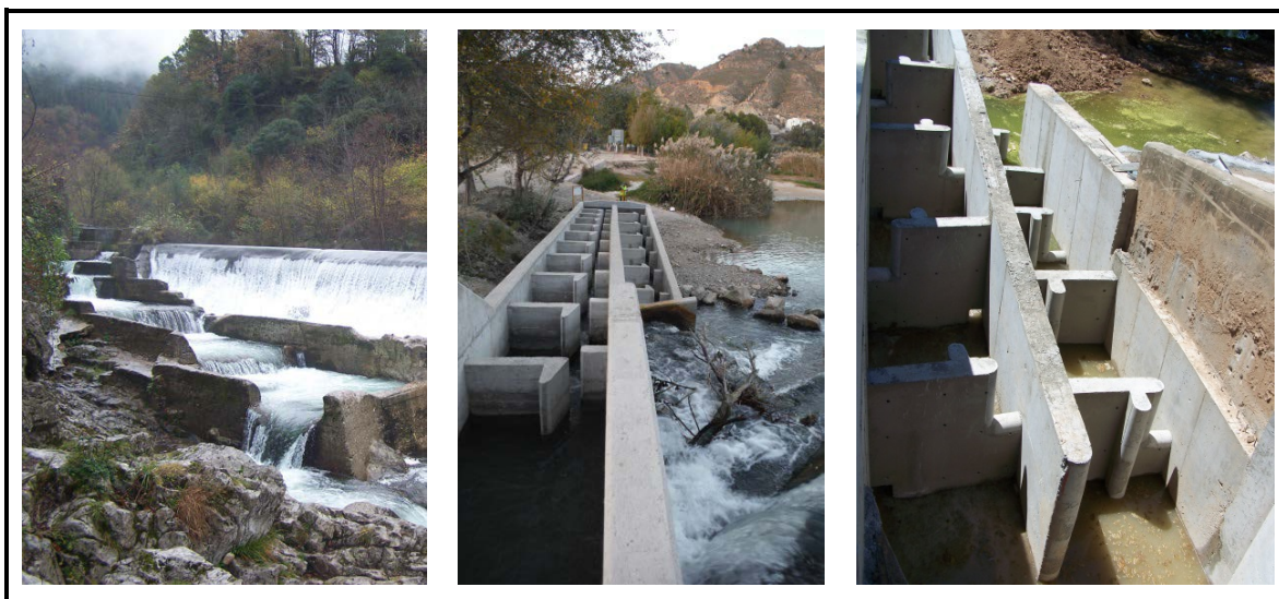
Figura 3. Ejemplos de tipologías de escalas de artesas o estanques sucesivos. Izq. Vertedero libre (río Sella, Asturias). Centro. Hendiduras verticales (río Segura, Murcia). Dcha. vertedero sumergido y orificio de fondo (río Duero, Valladolid). (Fuente: propia).
