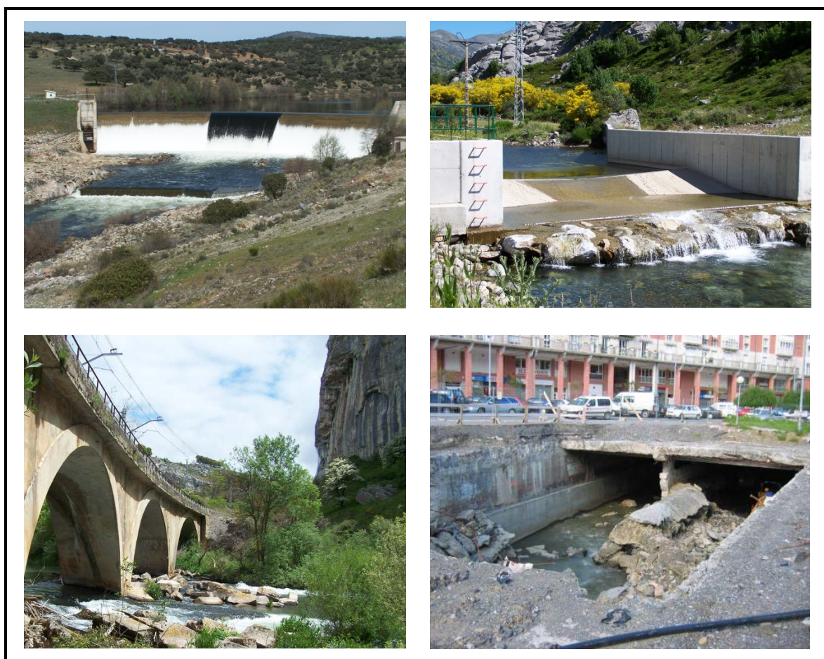
Figura 2. Ejemplos de obstáculos al libre movimiento de los peces. Arriba: izq. Presa; dcha. estación de aforo tipo V-flat. Abajo: izq. Descalce aguas abajo de cimentación de puente; dcha. oscuridad por río soterrado. (Fuente: propia)
