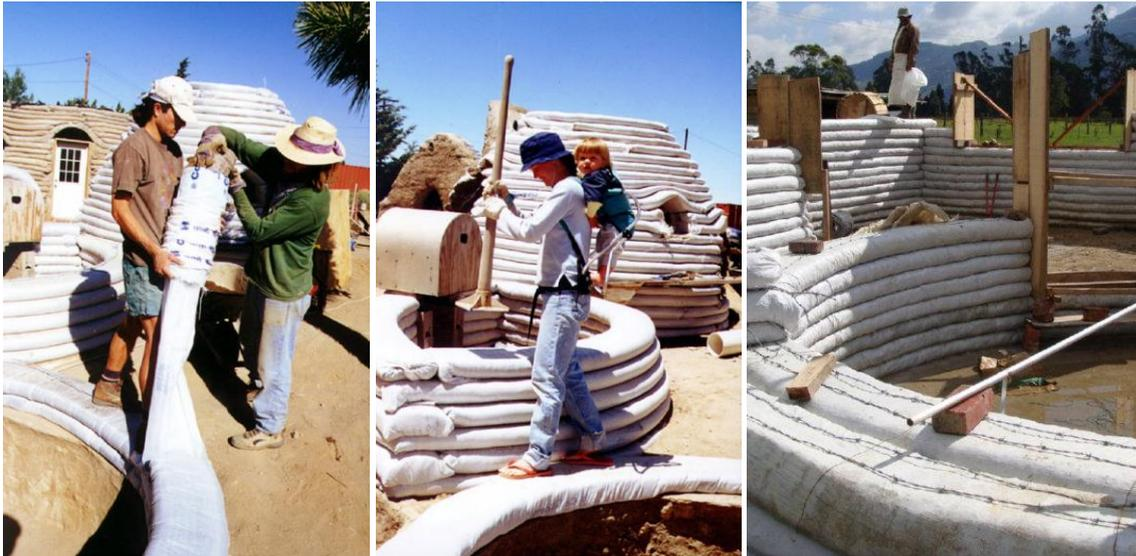
Figura 65. Processo Construtivo “Superadobe”
