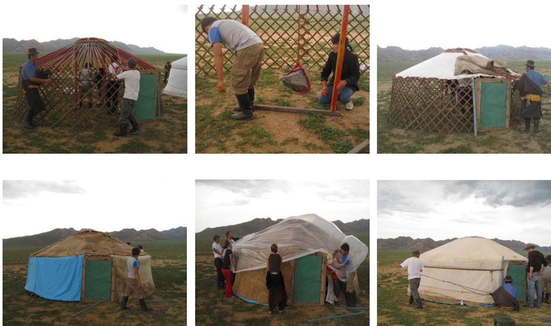
Figura 79. Processo de Montagem do Ger
