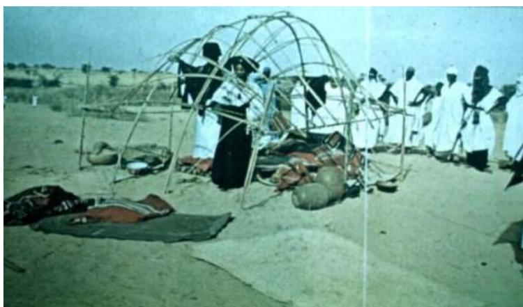
Figura 81. Montagem da estrutura de uma habitação da tribo *Rendille*
