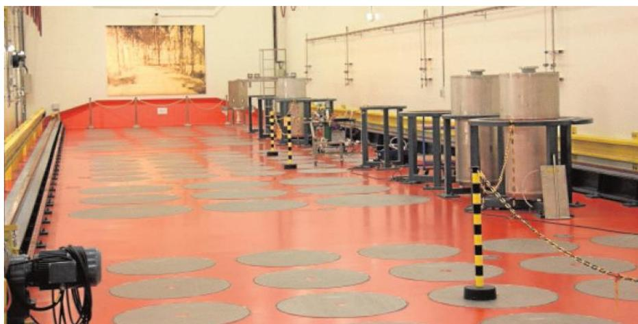
**Figura 5.5. Tubos de almacenamiento de material radiactivo**
