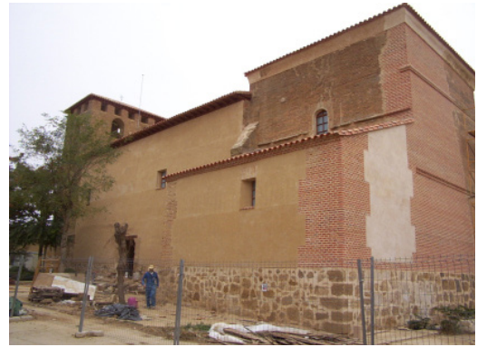
Fig. 10. San Esteban. Obras de restauración concluidas. Se aprecia la nueva fábrica del muro del presbiterio y las zonas de tapial de la fachada sur revocadas.
