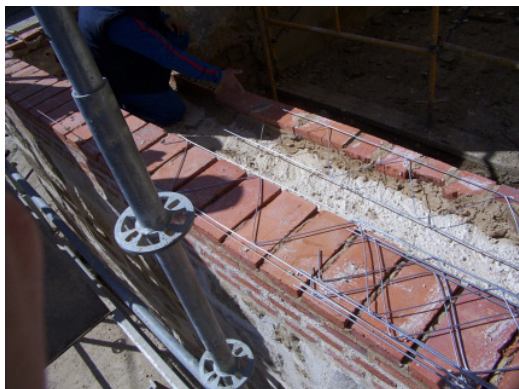
Fig. 7. San Esteban. Restauración de urgencia del muro del presbiterio para evitar el desplome de la armadura de cubierta. Foto del autor.
