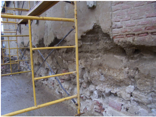
Fig.9. San Esteban. Perdida de masa del tapial en la fachada sur por capilaridad y salpicaduras. Foto del autor.
