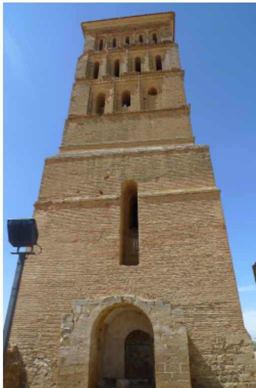
Fig. 4. La torre de San Pelayo, en Villavicencio de los Caballeros. El primer cuerpo de esta imponente torre, aprovecha restos de otra torre anterior construida en tapial, (se pueden adivinar en la ventana de la desaparecida escalera). Esto además justifica el escalonamiento entre ambos cuerpos. Foto del autor.
