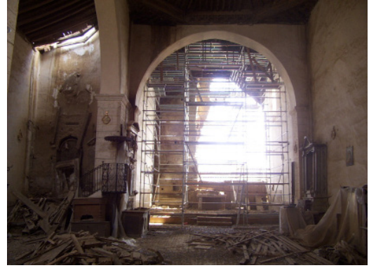
Fig. 6. San Esteban. Villamayor de Campos, Zamora. Estado de la iglesia antes de las distintas fases de restauración. Foto del Autor.
