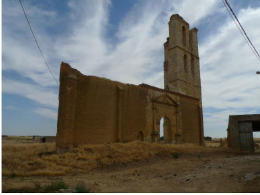
Fig. 5. San Juan. Tamariz de Campos. La parte de la fachada que queda en pie, evidencia la construcción de las dos hojas: tapial interior y ladrillo exterior, de forma separada. Foto del autor.
