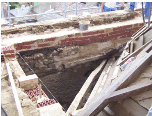
Fig.8. San Esteban. Coronación del muro del presbiterio. Puede observarse en la foto la zona de tapial, la zona original de adobes que incorpora la estructura de apoyo del artesanado ochavado, y la suplementación con ladrillo y mortero de cal donde se aprecian los nudillos preparados para recibir la estructura de la cubierta. Foto del autor.
