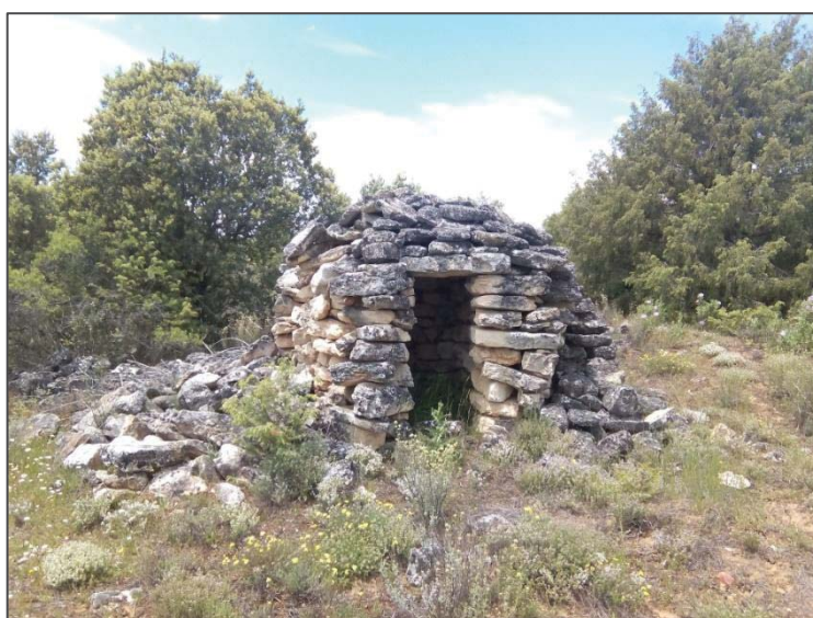
FIGURA 37. Refugio de pastores en la paramera del arroyo de los Pozarrones, margen este.
