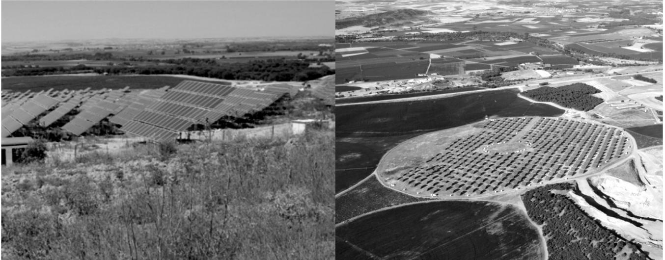
**Figure 8** : Installation photovoltaïque sur un ancien terrain irrigué à Montelareina, 1,8 MW sur 36 hectares, composée par 19 investisseurs de 96 kW chacun, développée à l'issue du DR 661/2007.
