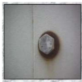
Ilustración 5.4: Corrosión galvánica. [53]
