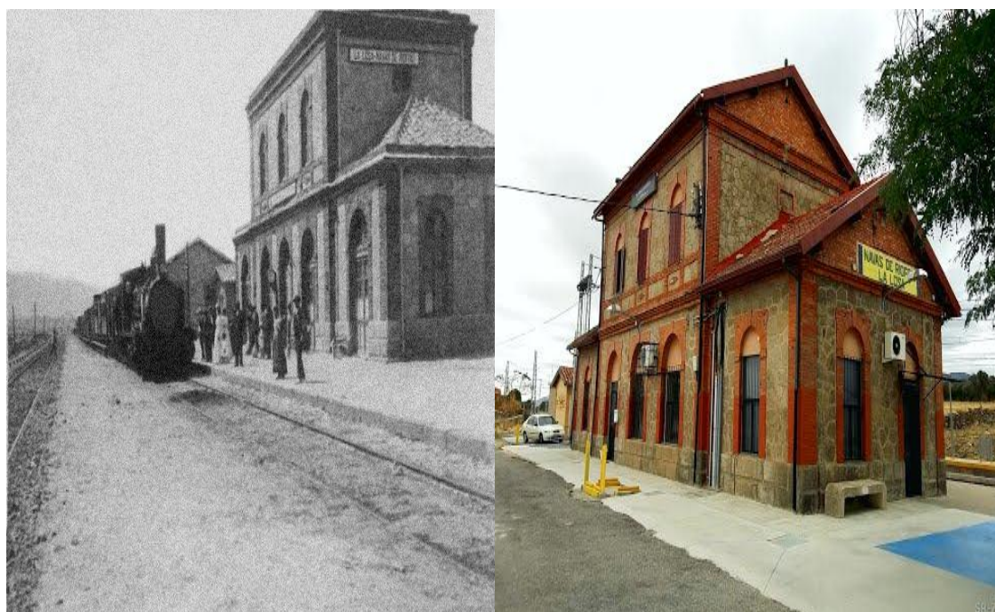
Figura 11. Fotografía de la estación de tren de Navas de Riofrío antigua y moderna
